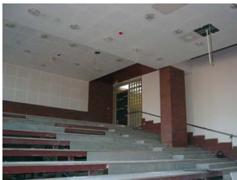
Fot. 7 Audytorium na 130 miejsc, montaż głośników i urządzeń multimedialnych
