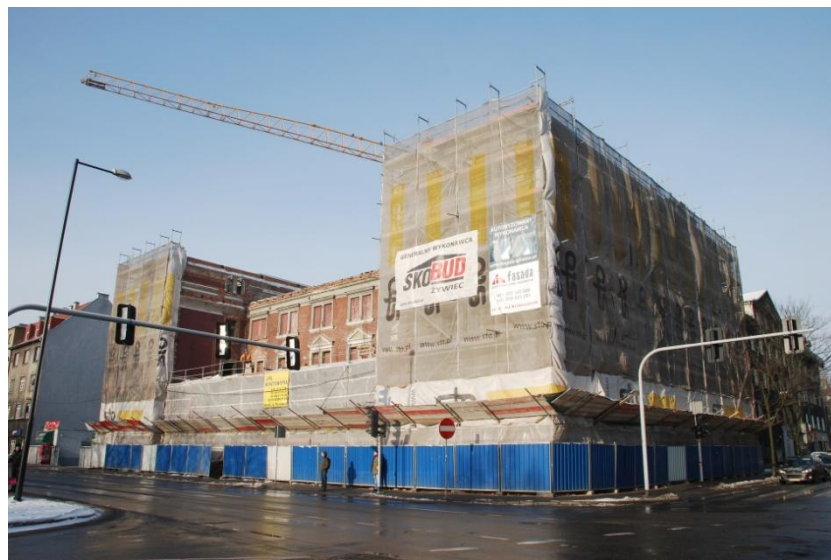
Przebudowa budynku SDK przy ul. Strzody 10 na potrzeby Wydziału Architektury
