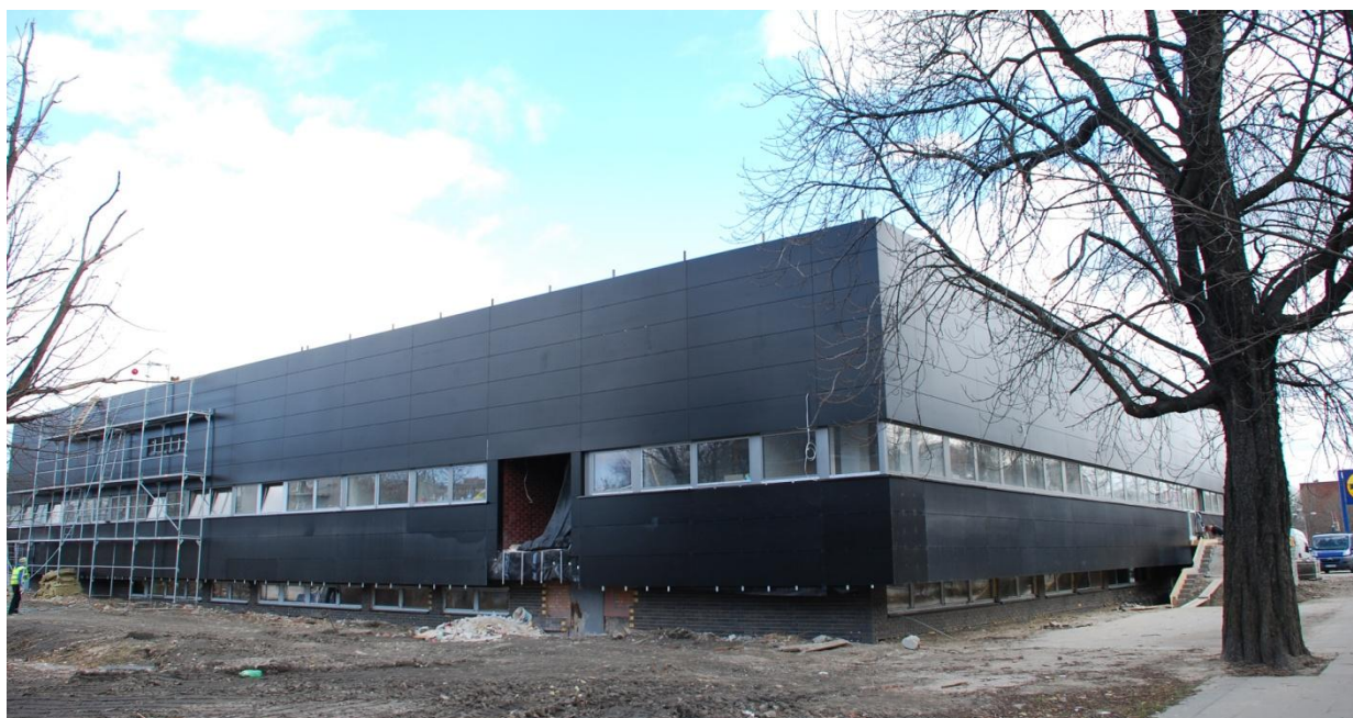
Przebudowa byłej stołówki studenckiej przy ul. Pszczyńskiej 85 na potrzeby Samorządu i organizacji studenckich Politechniki Śląskiej
