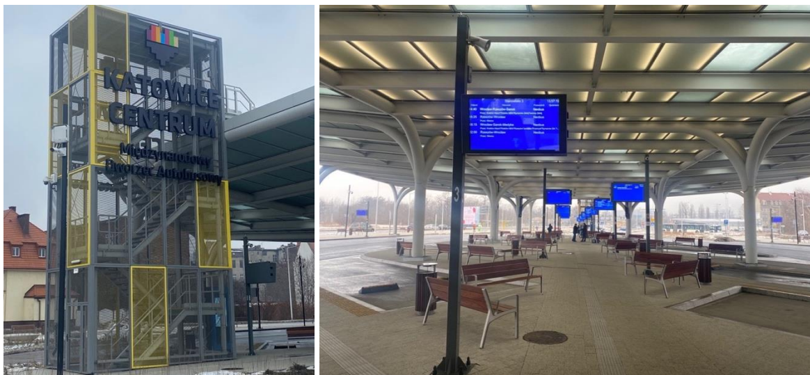
Rys. 21. Centrum przesiadkowe Katowice „Sądowa” Źródło: materiały własne
