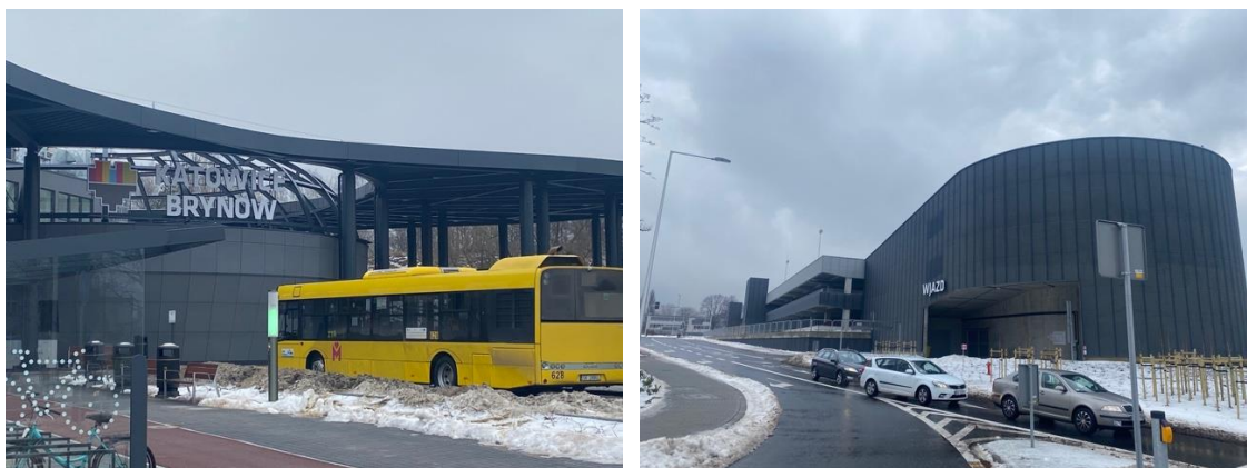
Rys. 22. Centrum przesiadkowe Katowice „Brynów” Źródło: materiały własne
