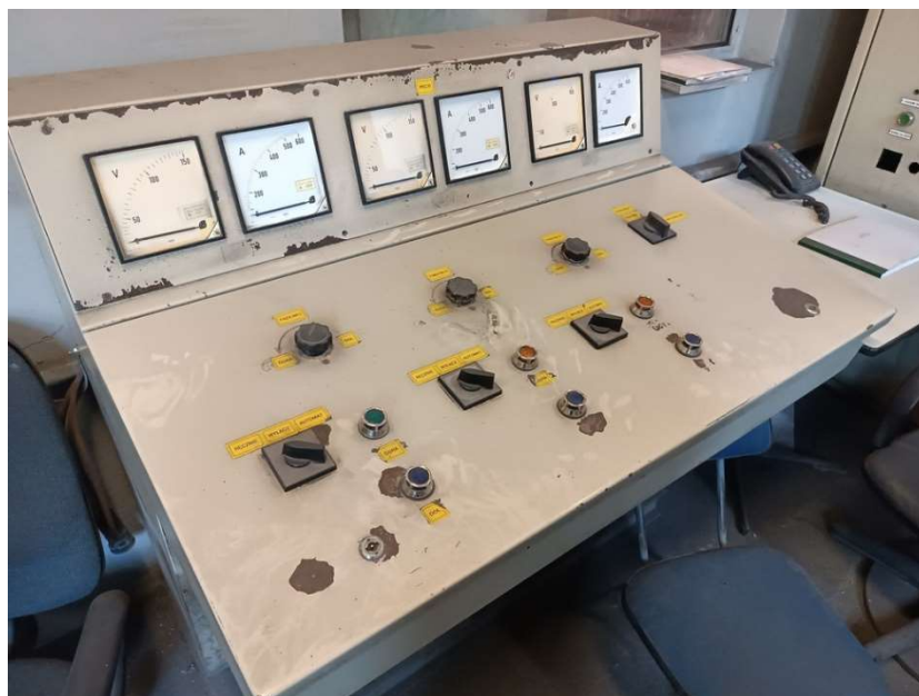
Rys. 15. Pulpit sterowniczy pieca rezystancyjno-lukowego starego typu
