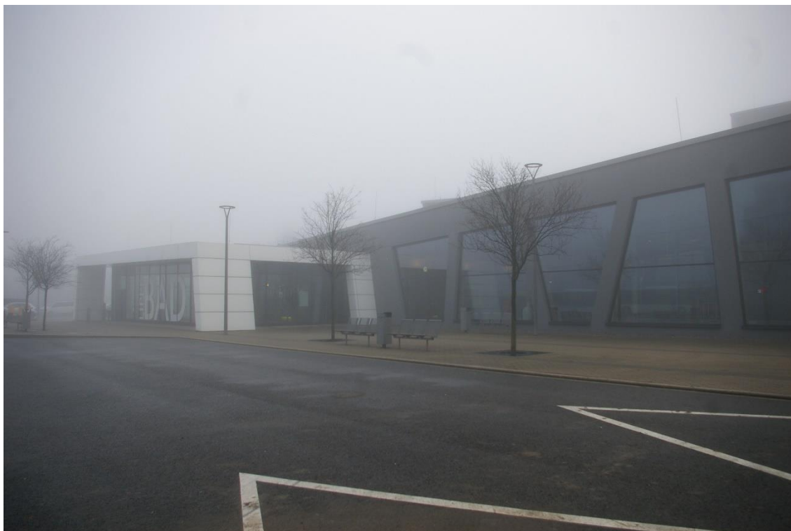
Rysunek 31. Basen pasywny w Lippe Bad Lünen widok na elewację zachodnią (fotografia Autorki).
