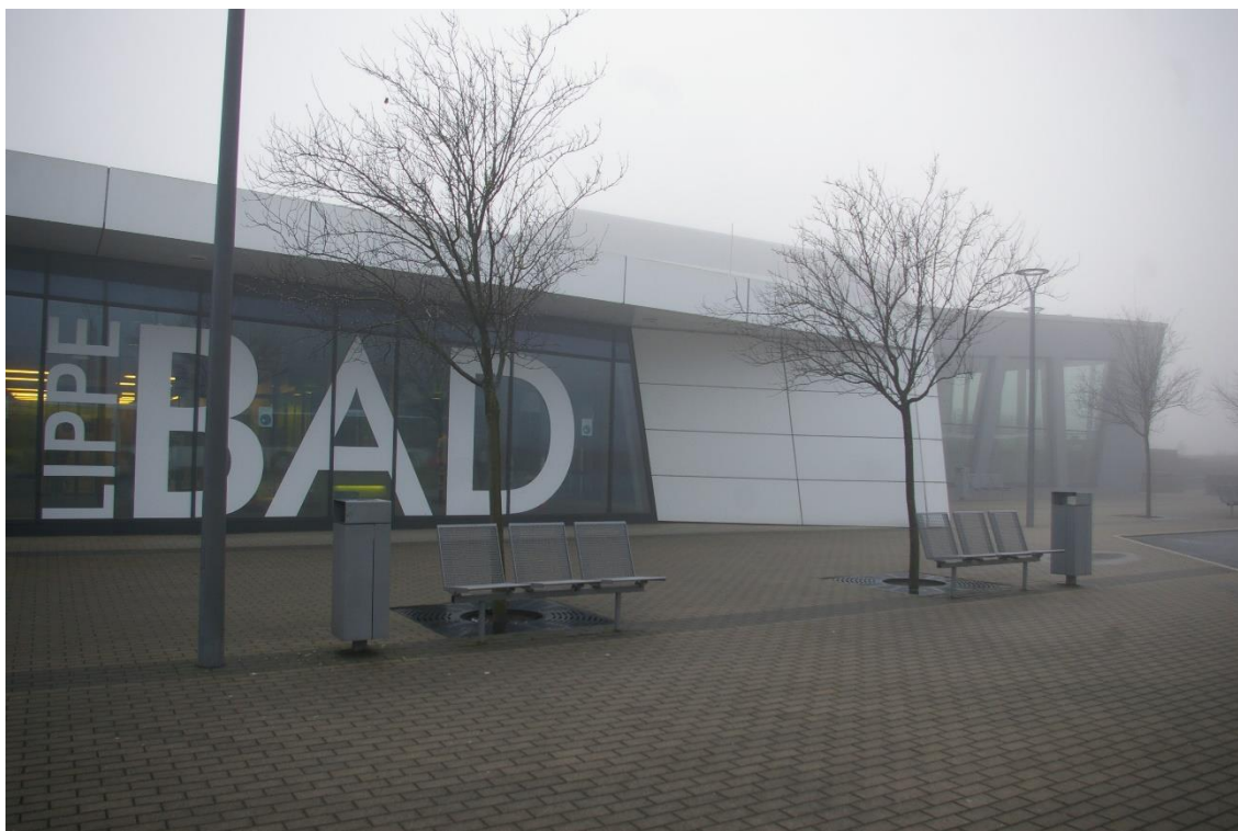
Rysunek 14. Basen pasywny w Lippe Bad Lünen widok na elewację zachodnią (fotografia Autorki).
