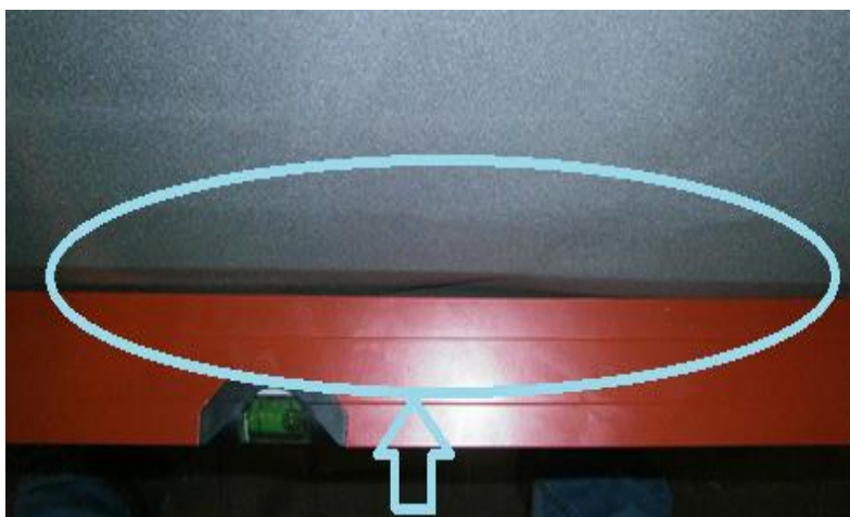
Rys. 41. Deformacja elementu (13,2 mm) podestu ruchomego po spawaniu bez chłodzenia mikro-jetowego i bez użycia podkładki miedzianej [źr. wł.]
