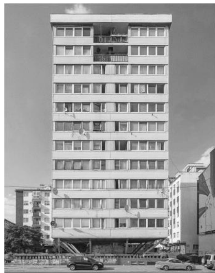
Ryc. 2.17. Budynek mieszkalny wielorodzinnny (konstrukcja trzono-linowa), Wrocław, Polska, projektant: Jacek Burzyński, Andrzej Skorupa, źródło: polska-org.pl, dostęp: 9.09.2022 r.
