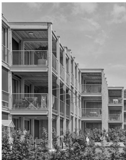
Ryc. 2.53. Budynek mieszkalny wielorodzinny, Eich, Szwajcaria, projektant: Dolmus Architekten, źródło: www.archdaily.com, dostęp: 9.09.2022 r.
