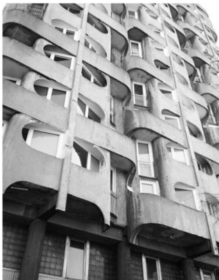
Ryc. 2.2. Zespół zabudowy wielorodzinnej, pl. Grunwaldzki, Wrocław, Polska, projektant: Jadwiga Grabowska-Hawrylak, źródło: autorka.
