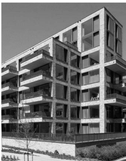
Ryc. 2.56. Budynek mieszkalny wielorodzinny, Amsterdam, Holandia, projektant: Koschuch Architects, źródło: www.archdaily.com , dostęp: 9.09.2022 r.
