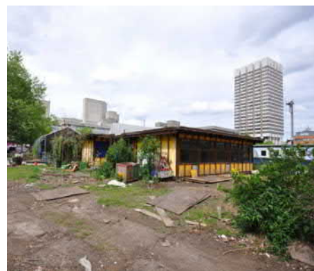
Fot.4. Budynek, z którego pozyskano materiały
