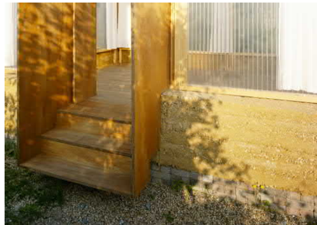
Fot.4. Podmurówka z cegieł betonowych i ziemi
