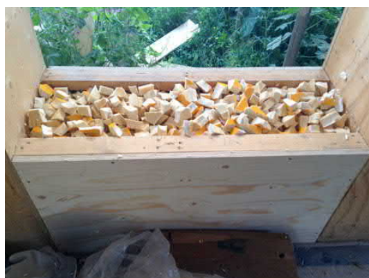
Fot.2. Ściana wypełniona odpadami
