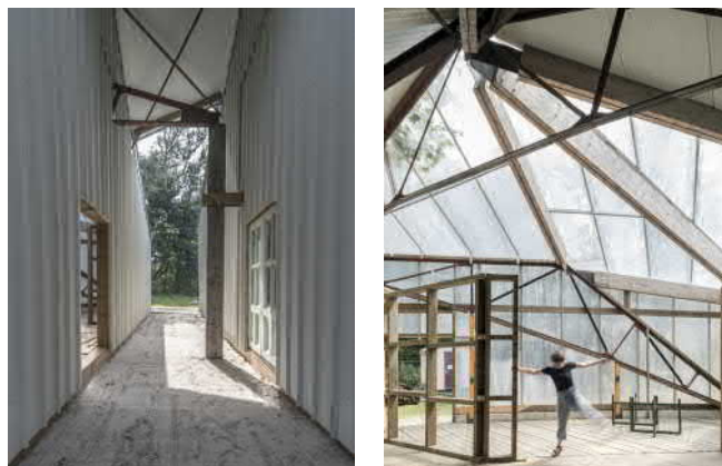
Fot. 5 i 6. Konstrukcja z kratownic miejscami wzmocniona drewnem
