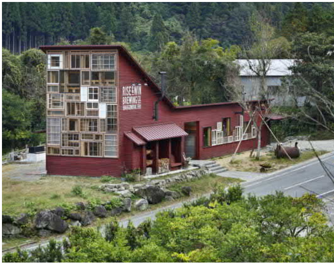
Fot.1. Elewacja z odpadów drewnianych i okien rozbiórkowych
