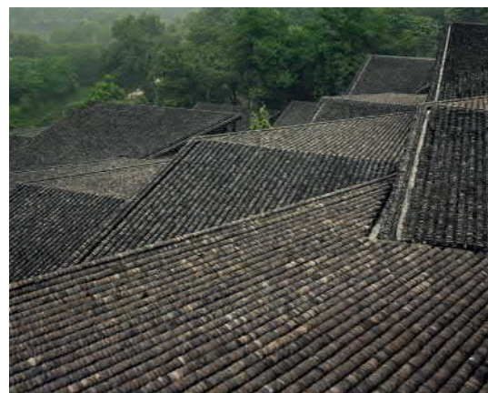
Fot.4. Detal dachu
