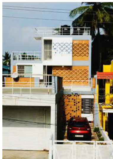
Fot.6. Rama bramy głównej
