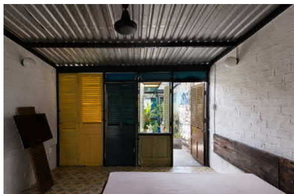
Fot.4. Pokrycie dachu ze stalowej blachy trapezowej
