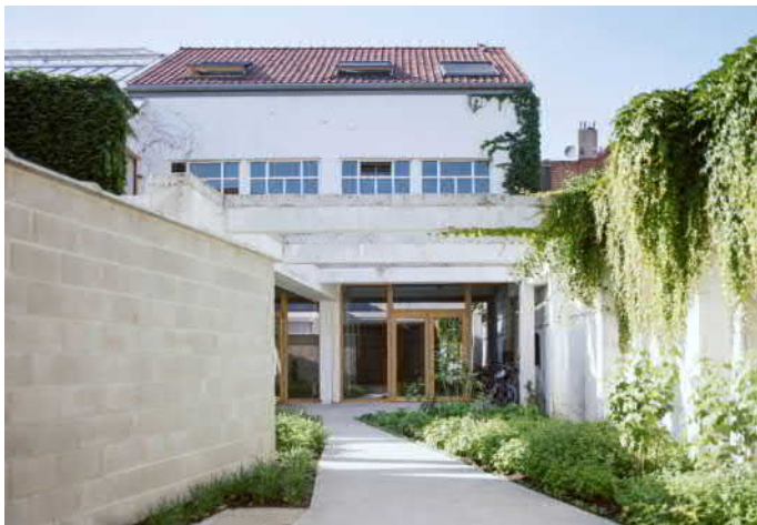
Fot.1. Widok od strony wejścia.
