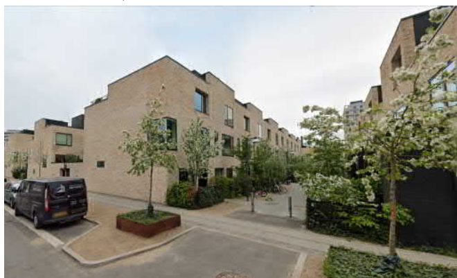
Fot.3. Elewacja z cegieł rozbiórkowych.
