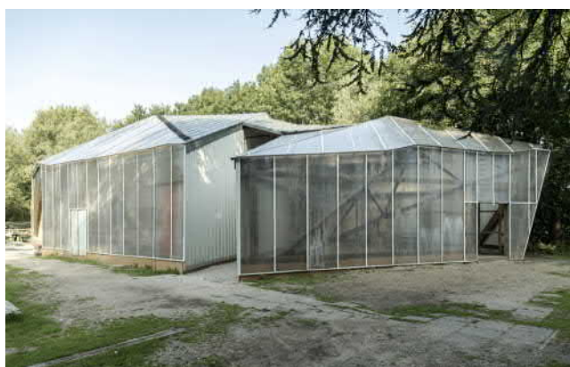
Fot.2. Elewacja z płyt poliwęglanowych
