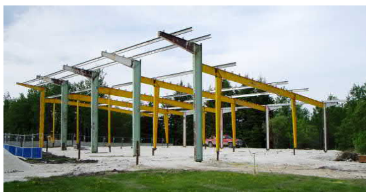
Fot.3. Konstrukcja stalowa pozyskana z rozebranych magazynów.
