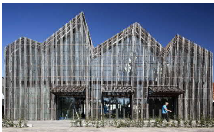
Fot.1. Charakterystyczny kształt dachu budynku.
