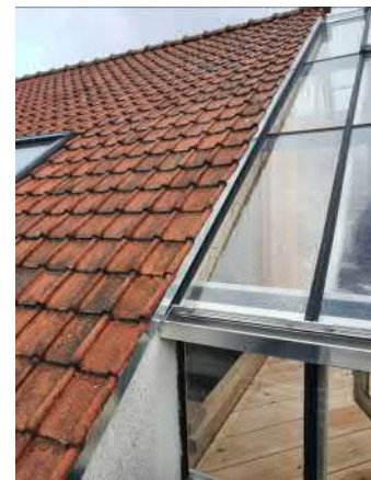
Fot.4. Ułożone ponownie dachówki
