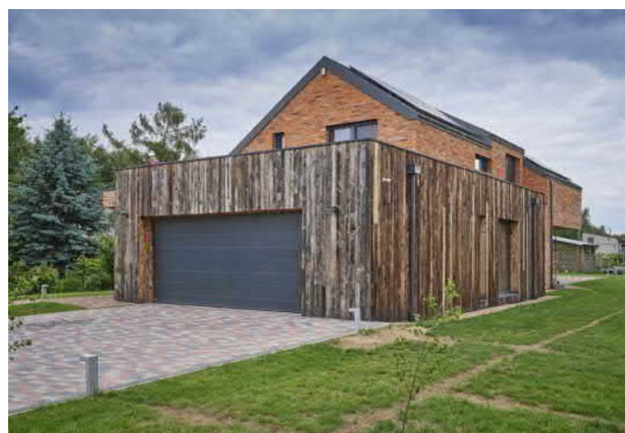
Fot.1. Elewacja garażu i części technicznej z drewna rozbiórkowego.
