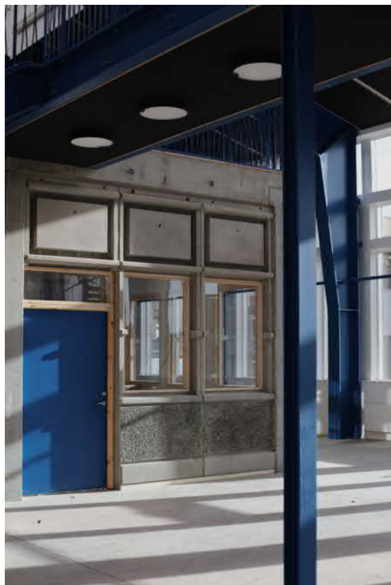
Fot.5. Ściana wewnętrzna z odzyskanego betonu.
