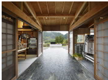
Fot.2. Podłoga z odpadów ceglanych
