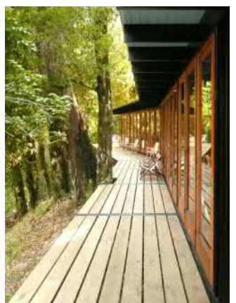
Fot.2. Przeszklona fasada z odzysku
