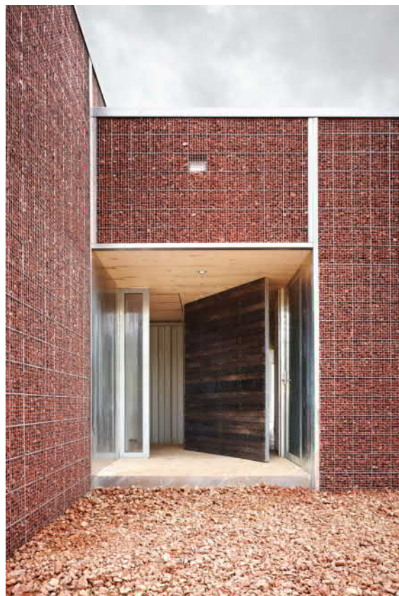
Fot.4. Detal siatki wypełnionej ceglany m gruzem
