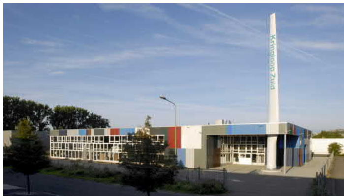
Fot.2. Widoczna turbina wiatrowa i ogrodzenie z odzysku.
