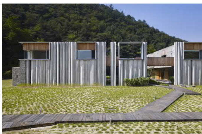
Fot.1. Ściana z betonu uformowana na wzór tkaniny
