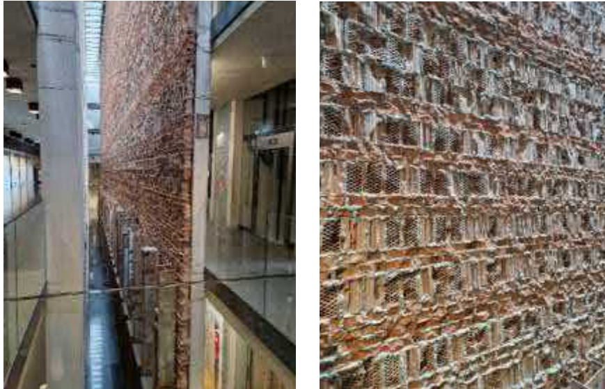
Fot. 13. Okładzina ściany wewnętrznej wykonana z rozbiórkowej cegły i pustaków w Centrum Spotkania Kultur w Lublinie. Autor zdjęć: Beata Kucharczyk-Brus.
