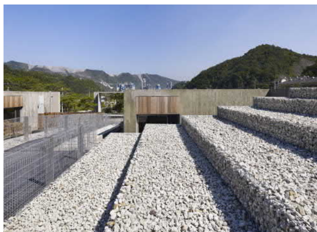
Fot.4. Resztki betonu tworzą dodatkową izolację dachu od słońca.
