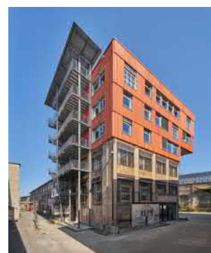
Fot.7. Zewnętrzna klatka schodowa
