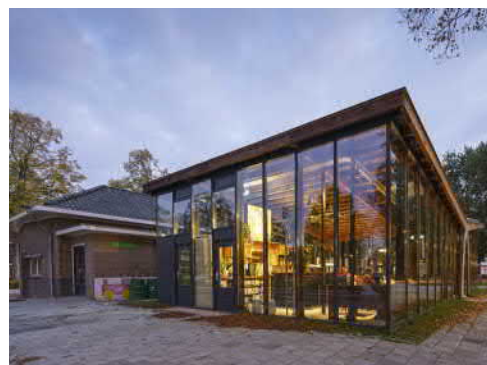
Fot.6. Aluminiowe profile wykorzystane na fasadzie
