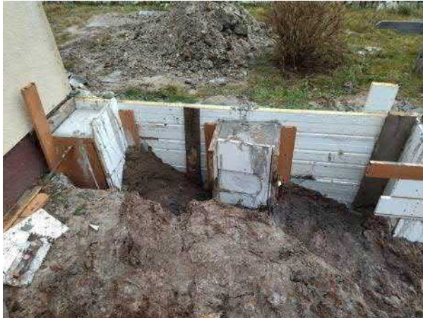
Fot. 23. Szalunek fundamentów wykonany z odpadowych płyt warstwowych. Źródło: fotografia własna
