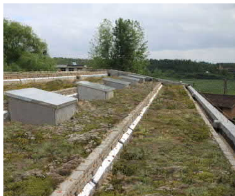
Fot.6. Zielony dach z warstwami izolacji z gruzu
