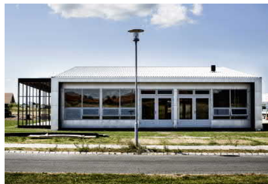
Fot.7. Odzyskane okna
