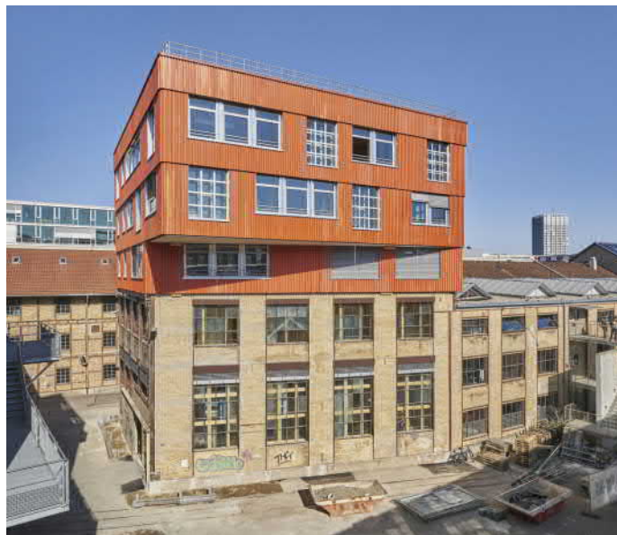
Fot.1. Elewacja z rozbiórkowej blachy falistej o charakterystycznym kolorze.
