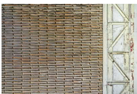
Fot.6. Dachówki wykorzystane do budowy ściany działowej
