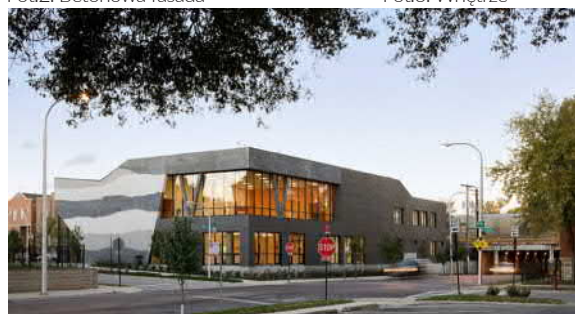
Fot.5. Widok na elewację.
