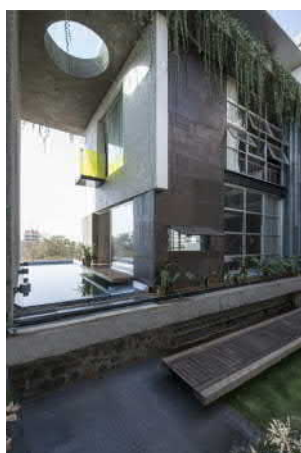
Fot.3. Okładzina z płyt metalowych
