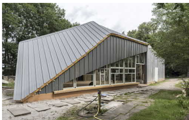
Fot.3. Płyty warstwowe na dachu i elewacji, odzyskana stolarka okienna
