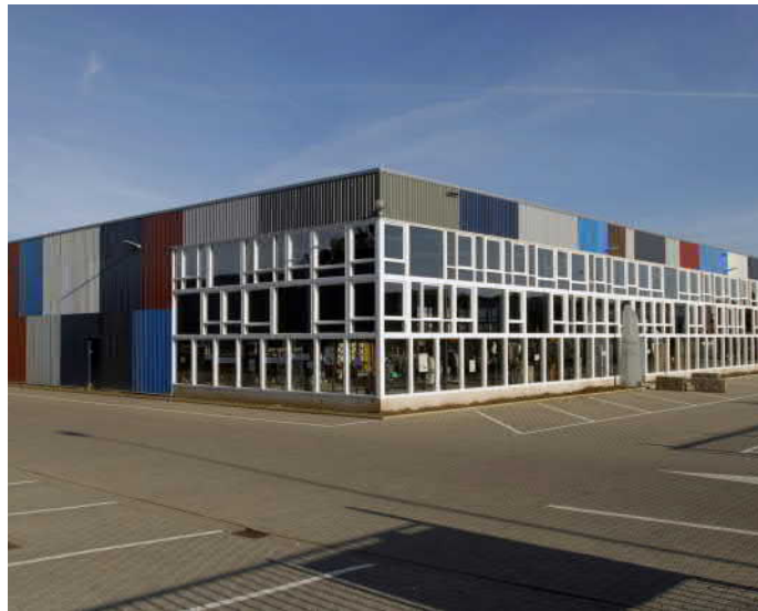
Fot.1. Przeszklony narożnik budynku.
