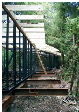
Fot.3. Stalowa konstrukcja
