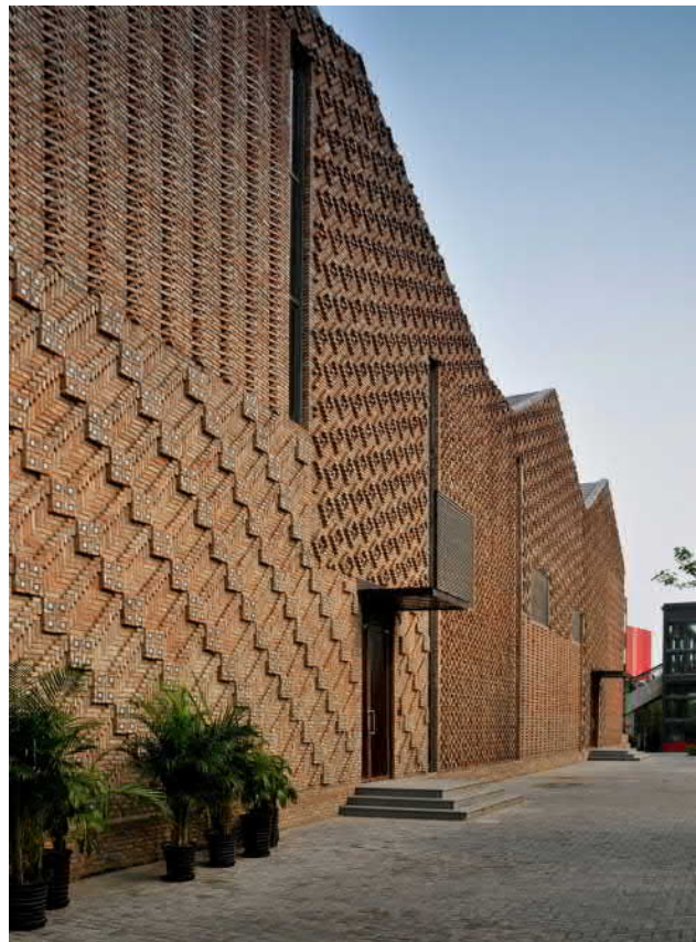
Fot.5. Elewacja podzielona na sekcje o różnych wzorach cegieł
