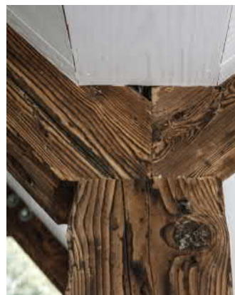
Fot.4. Detal łączenia konstrukcji
