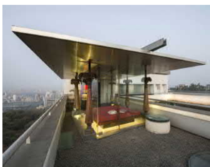
Fot.6. Pawilon na dachu ze 100-letnimi kolumnami
