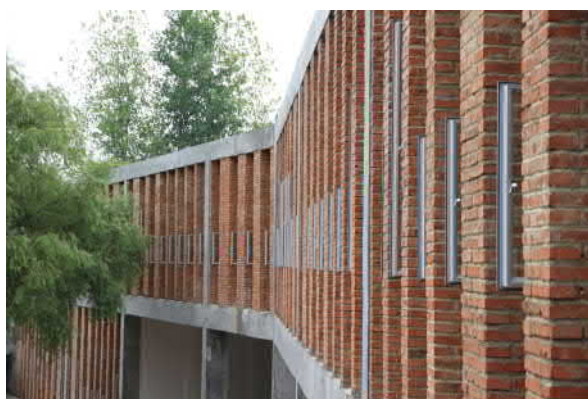
Fot.3. Ceglana elewacja
