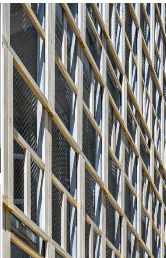
Fot.6. Okładzina elewacji z drewnianych ram drzwiowych.
