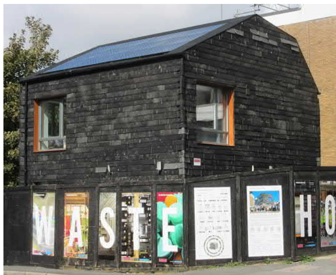
Fot.1. Elewacja pokryta płytkami dywanowymi.
