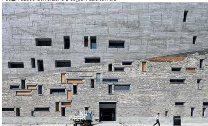
Fot.4. Fasada utworzona z cegieł i dachówek pochodzących z rozebranych budynków w mieście.
