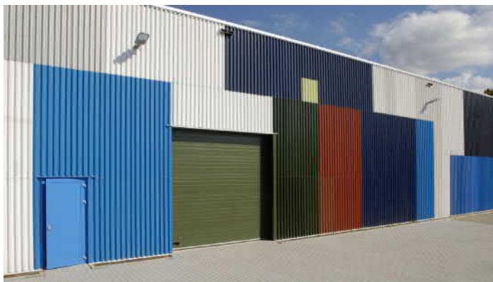
Fot.2. Odzyskana brama wjazdowa wkomponowana w elewację z blachy
