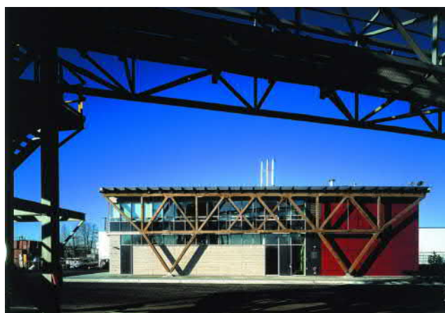
Fot.2. Elewacja z charakterystyczną kratownicą
