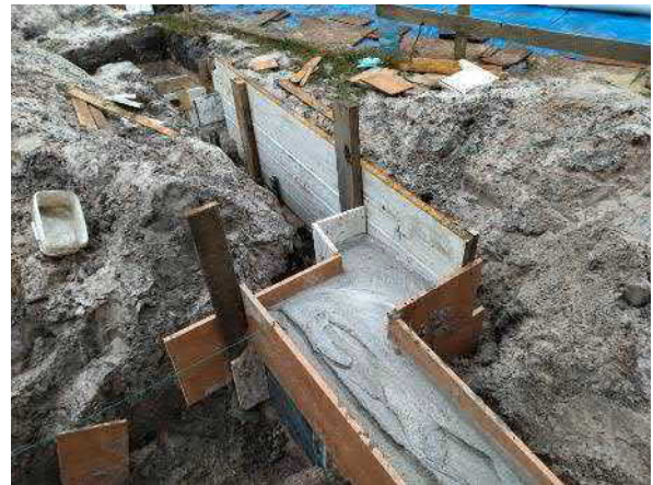
Fot. 10. Płyty meblowe wykorzystane jako szalunek. Źródło: fotografia własna.
