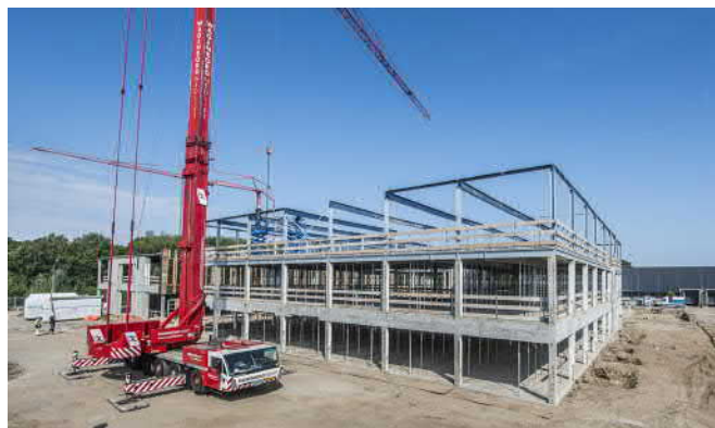
Fot.3. Stalowa konstrukcja pozyskana z rozebranych budynków
