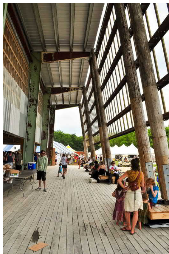
Fot.4. Stare słupy elektryczne i podłoga z odzyskanych desek.
