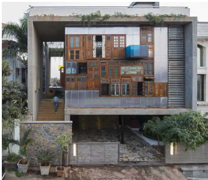
Fot.1. Elewacja wejściowa.
