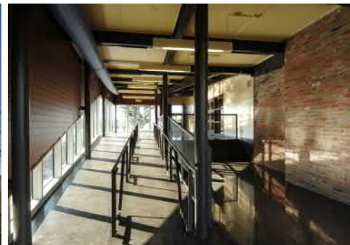
Fot.3. Ściany działowe z rozbiórkowej cegły
