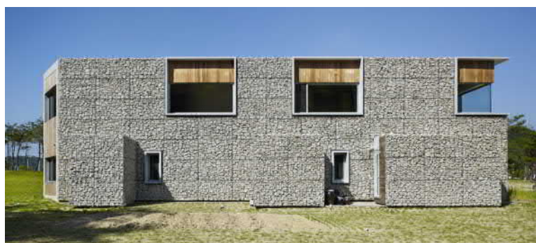
Fot.2. Ściana z gabionów wypełnionych kruszonymi resztkami betonu.
