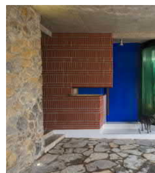
Fot.7. Ściany z wydobytych podczas prac ziemnych kamieni
