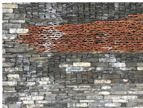
Fot.5. Detal ściany, technika wapan
