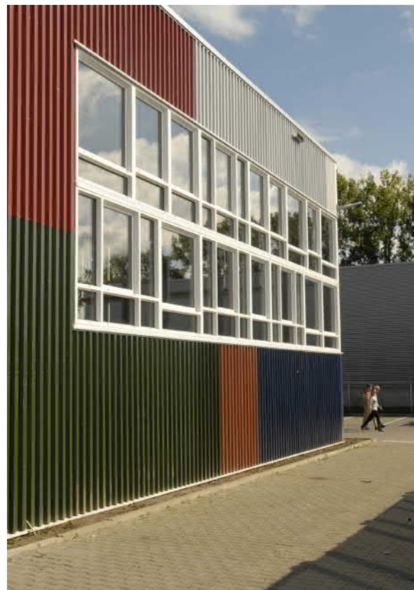
Fot.4. Okna pochodzące z rozbiórki budynku mieszkalnego.
