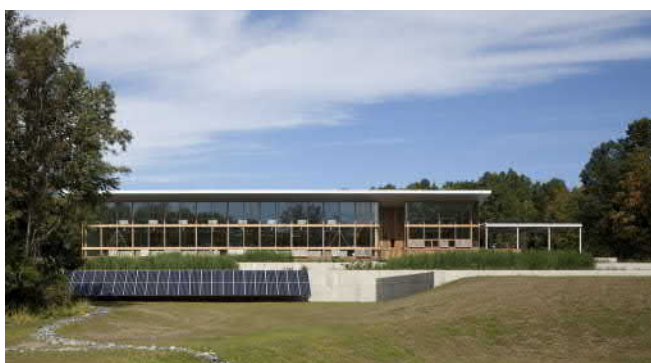
Fot.3. W budynku zastosowano panele fotowoltaiczne.
