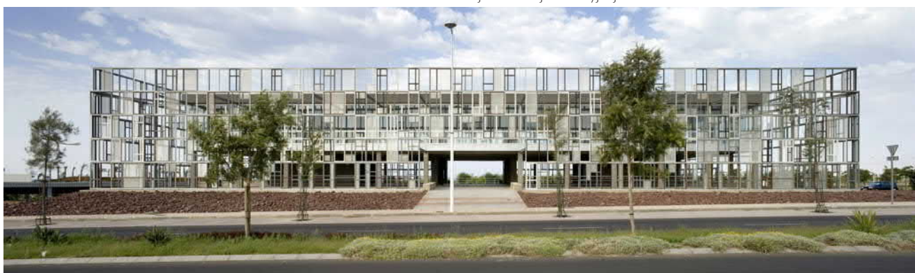
Fot.5. Zewnętrzna ośłona budynku stworzona z aluminiowej stolarki, profili aluminiowych i metalowych blach o różnych kolorach
