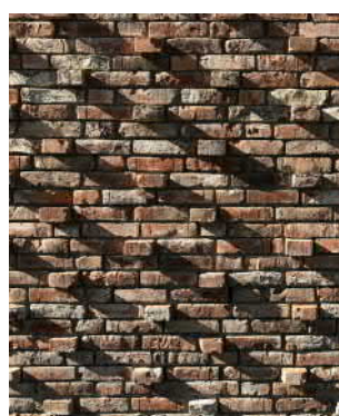
Fot.6. Detal elewacji ceglanej
