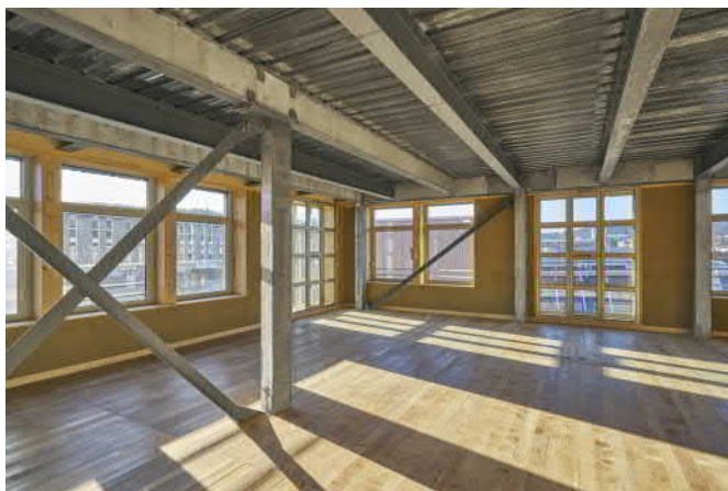
Fot.3. Stalowa konstrukcja szkieletowz z budynku w Bazylei
