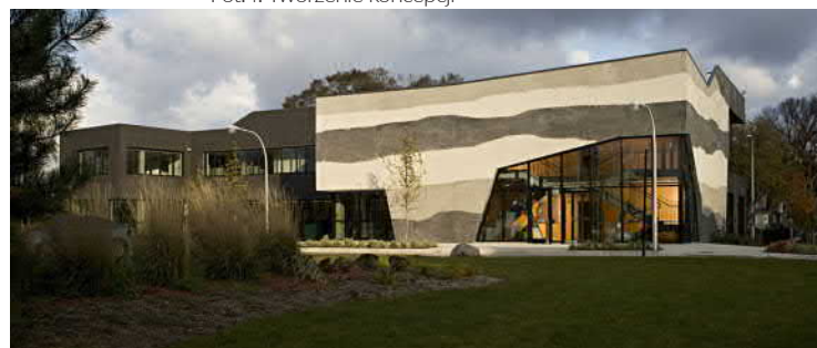
Fot.6. Charakterystyczny wzór elewacji powstały z wykorzystania różnych otrzymanych resztek mieszanek betonowych
