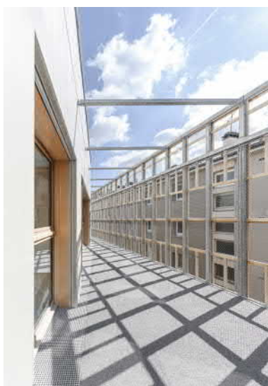
Fot.2. Okładzina widziana od wnętrza.
