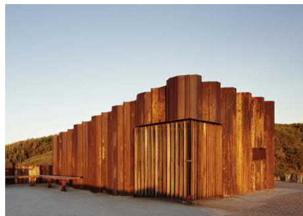
Fot.7. Detal elewacji
