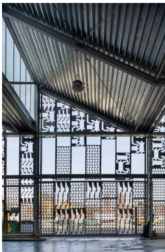
Fot.2. Detale elewacji z płyt konturowych i drewna
