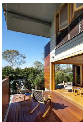
Fot.4. Dach wykonany z modułów podłogi podniesionej
