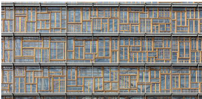
Fot.2. Gotowa fasada składająca się z przygotowanych wcześniej paneli okien.
