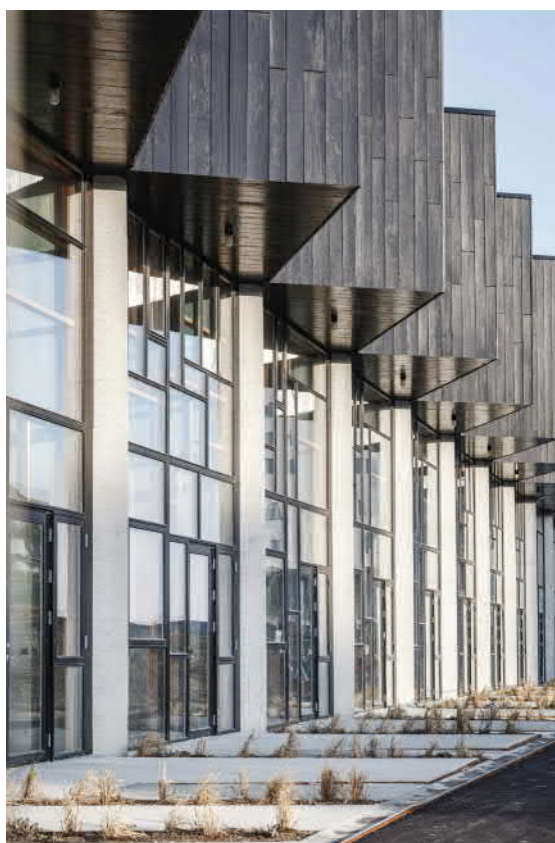
Fot.2. Stolarka okienna pozyskana z remontowanych budynków i drewno uzyskane z odpadów z manufaktury
