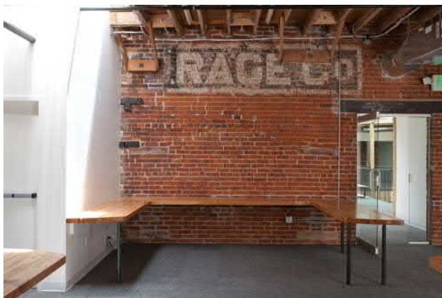
Fot.2. Ubytki w ścianie wewnętrznej uzupełnione cegłą rozbiórkową
