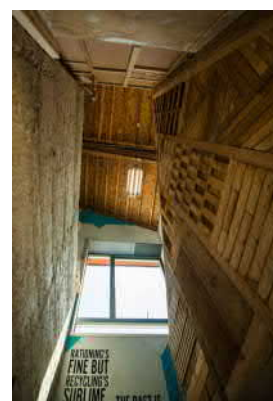
Fot.4. Ściany z odpadów.
