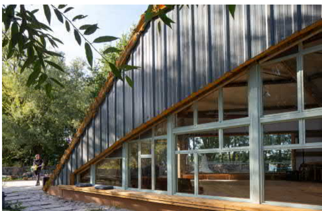
Fot.4. Detal elewacji i drewnianych parapetów służących jako ławki
