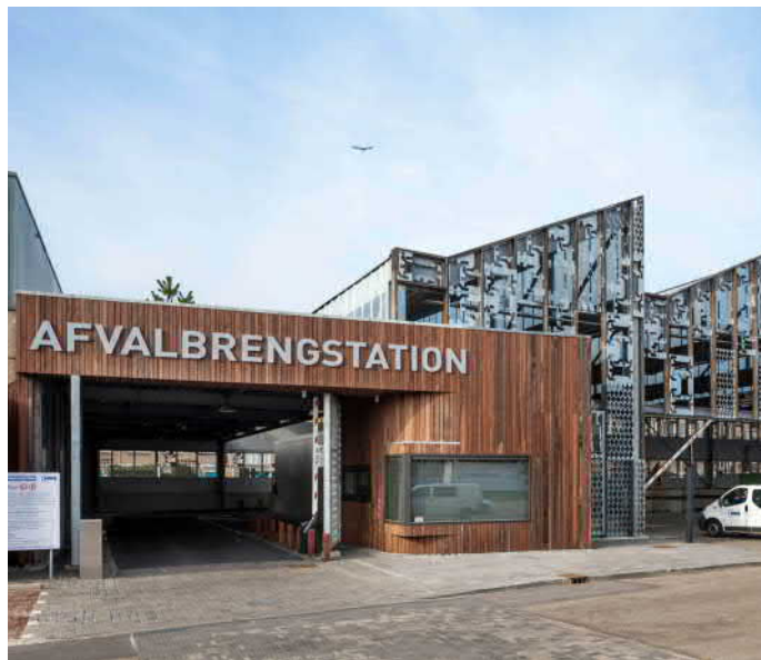
Fot.1. Elewacja z pociętego drewna azobe
