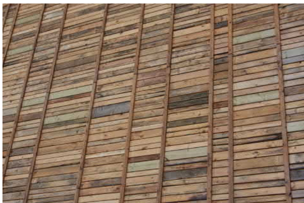
Fot.4. Drewno na okładzinę pozyskano z palet przeznaczonych do spalania
