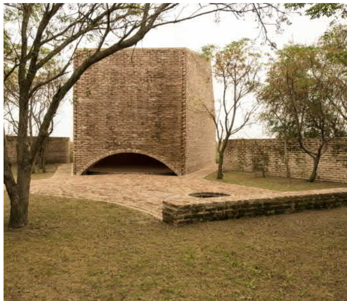
Fot.1. Widok na kaplicę od strony dziedzińca
