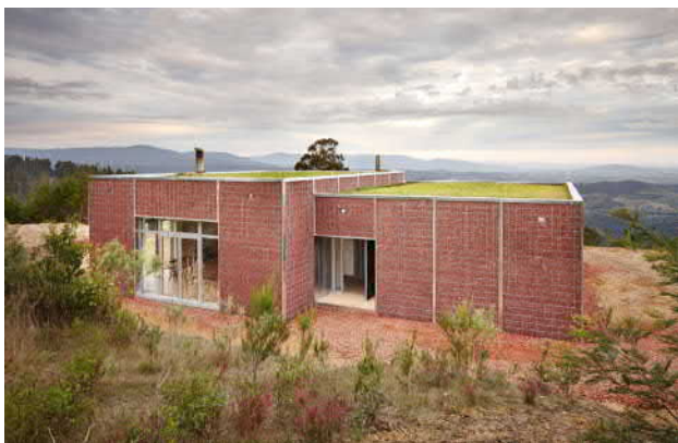
Fot.2. Wszystkie elewacje pokryte kruszoną cegłą.
