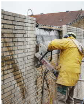
Fot.5. Wycinanie starej elewacji
