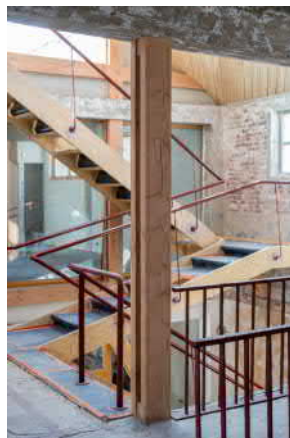
Fot.3. Odzyskana balustrada
