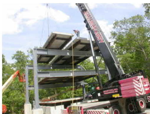
Fot.6. Montaż paneli na konstrukcji
