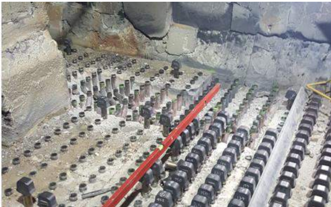
Rysunek 16.9. Komora paleniskowa – wymiana uszkodzonych dysz fluidyzacyjnych
