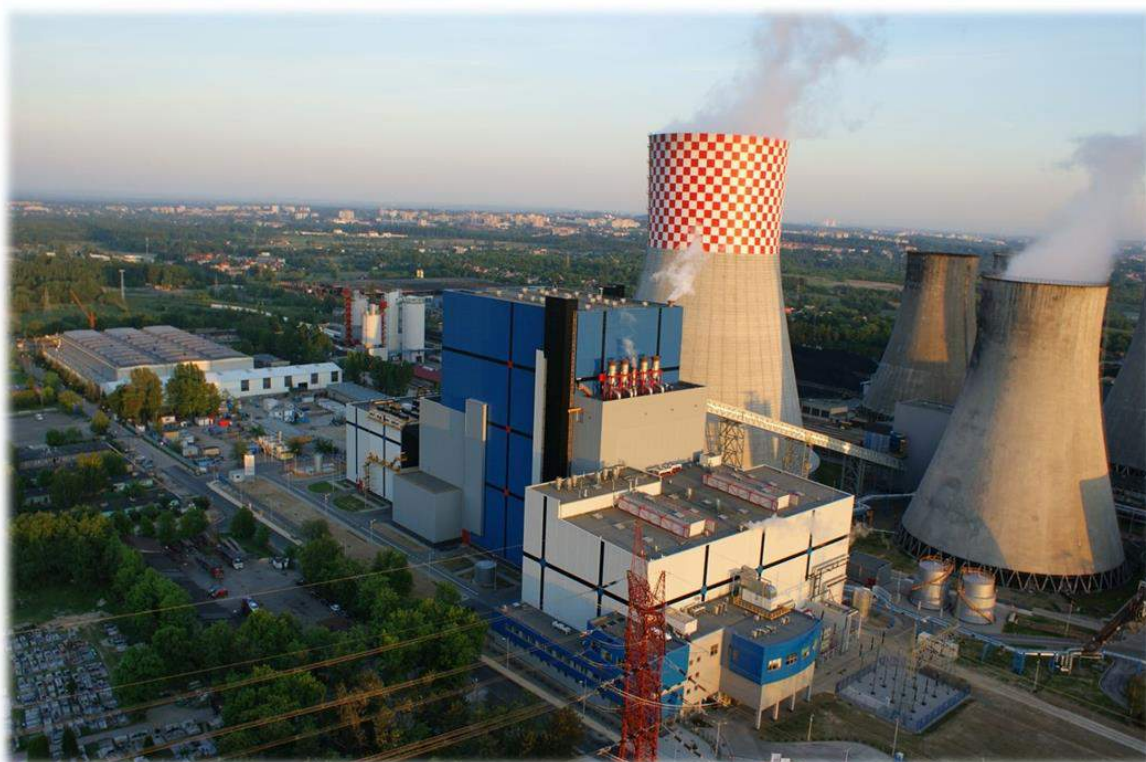
Rysunek 4.1. Widok nadkrytycznego bloku energetycznego nr 10 z kotłem fluidalnym CFB 1300 w Elektrowni Łagisza
