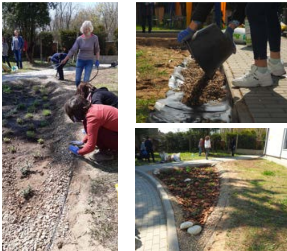
Fot. 26-28. Prace wykonawcze infiltracyjnego ogrodu deszczowego w Drzewicy
