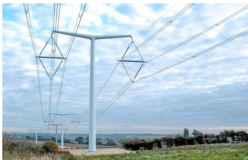
Rys. 2.7 Konstrukcja typu T-Pylon projektowana na napięcie znamionowe 275 kV i 400 kV
