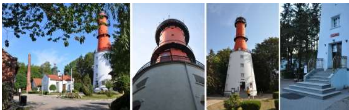
Ilustracja 83: Latarnia morska Rozewie I
