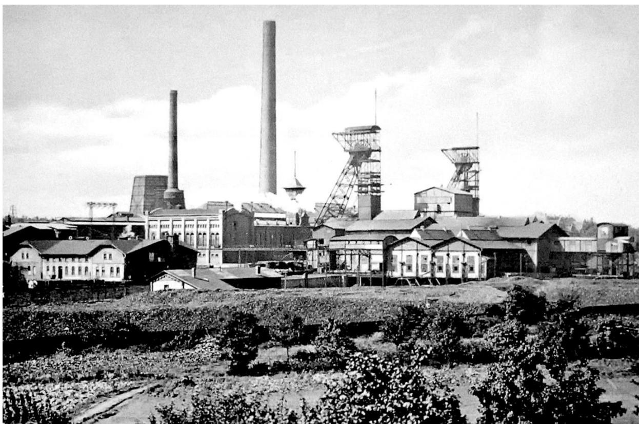
Rys. 91. Archiwalna dokumentacja fotograficzna KWK „Bobrek-Miechowice” (1936–1944) (Polska-org, 2020c)
