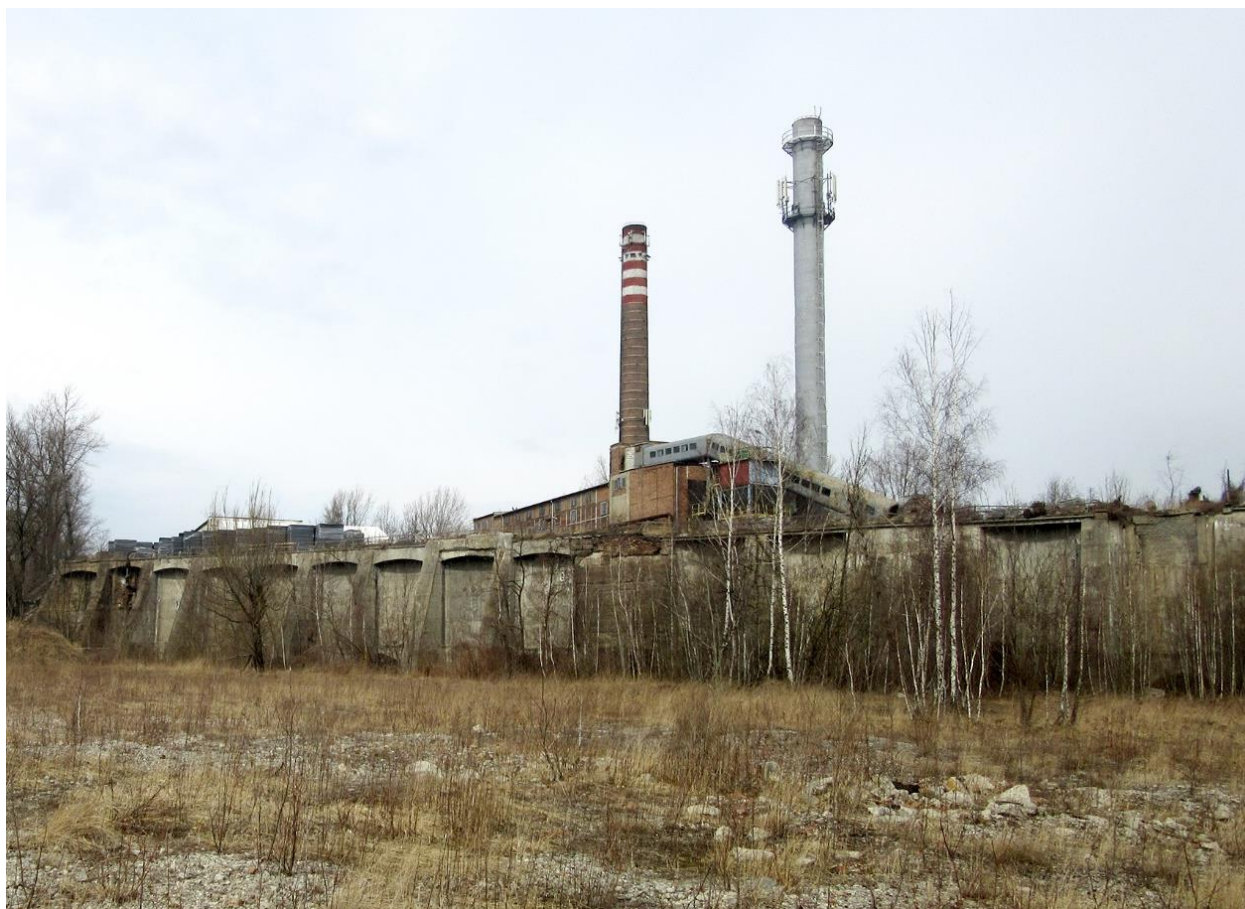
Rys. 116. Zagospodarowanie terenów zlikwidowanej KWK „Nowy Wirek” (fot. A. Wyrzykowska, 2020)
