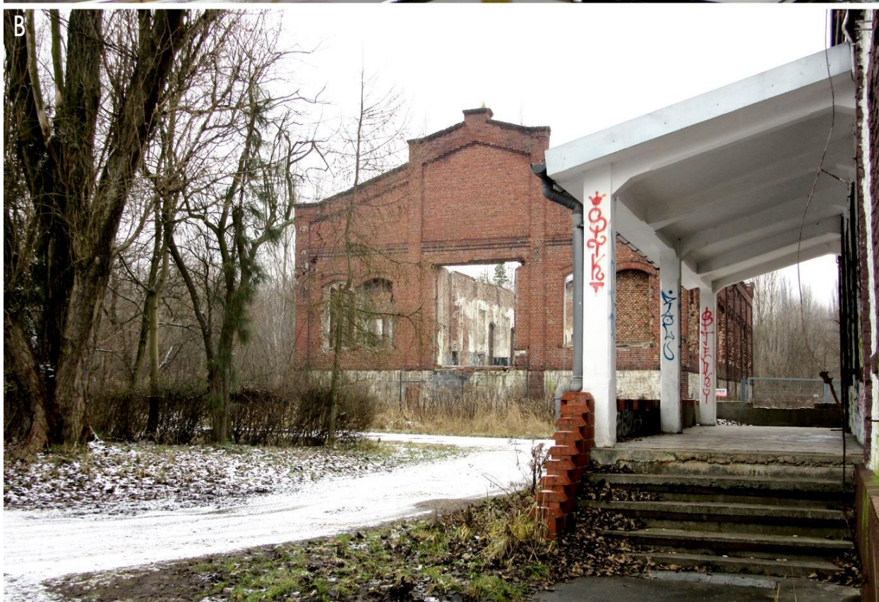
A – tereny przemysłowe na terenie KWK „Porąbka-Klimontów” ruch II „Porąbka” (fot. A. Wyrzykowska, 2020); B – obiekty pokopalniane KWK „Porąbka-Klimontów” ruch „Klimontów” (fot. A. Wyrzykowska, 2020).
