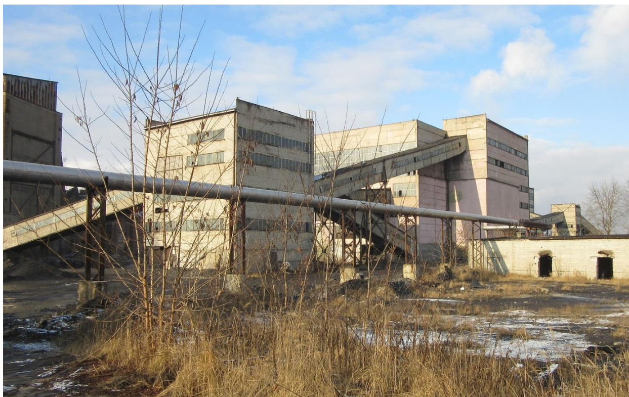
Rys. 9. Pozostałości infrastruktury zakładu przeróbczego KWK „Paryż” w Dąbrowie Górniczej (fot. A. Wyrzykowska, 2020)
