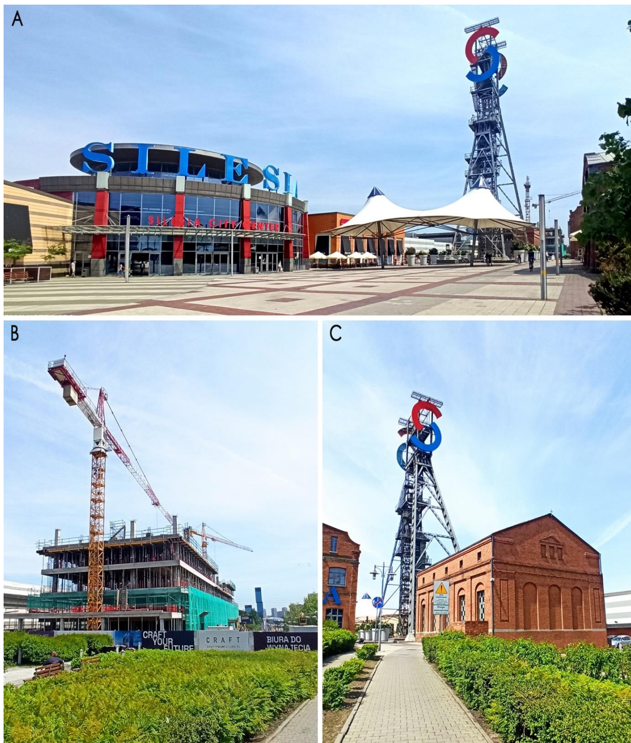
A – widok na Centrum Handlowe Silesia City Center; B – prace budowlane przy budowie biurowca „Craft”; C – widok na maszynownię i wieżę wyciągową szybu „Jerzy” – obecnie kaplica św. Barbary.
