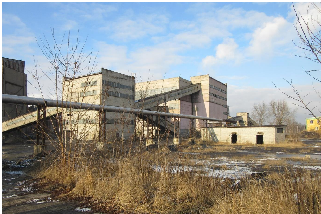
Rys. 119. Zagospodarowanie terenów zlikwidowanej KWK „Paryż” – pozostałości infrastruktury zakładu przeróbczego (fot. A. Wyrzykowska, 2020)
