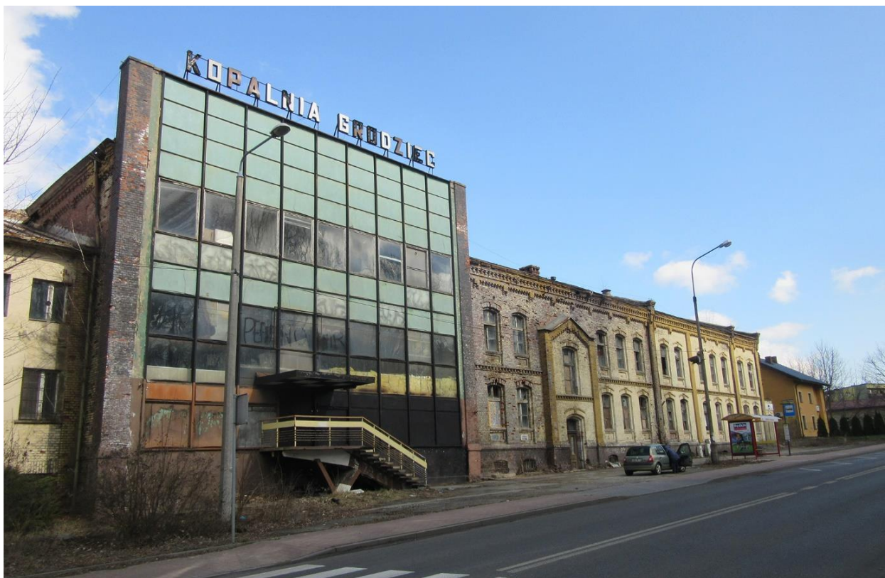
Rys. 101. Zagospodarowanie terenów zlikwidowanej KWK „Grodziec” – widok od ul. Barlickiego w Będzinie (fot. A. Wyrzykowska, 2021)
