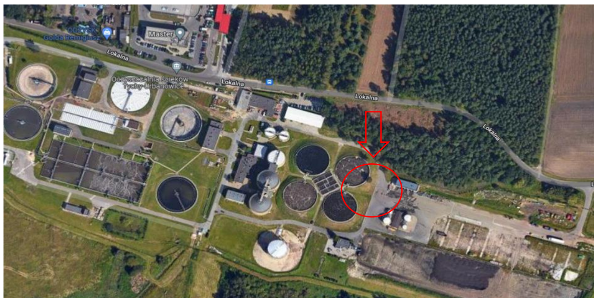
Rys. 24. Oczyszczalnia ścieków "Tychy-Urbanowice" (strzałką zaznaczono miejsce, w którym umiejscowiono instalację KBT do biooczyszczania powietrza pochodzącego ze zbiornika odpadów tłuszczowych)
