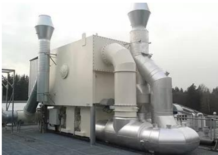
Rys. 4. Dopalacz termiczny, instalacja firmy Rotec (wg https://rotec.pl/dopalacze-lotnych-zwiazkow-organicznych.html )
