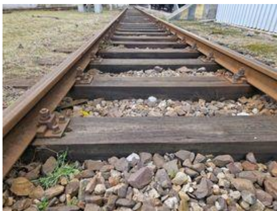
Rysunek 1. Tor kolejowy zbudowany na podkładach drewnianych
