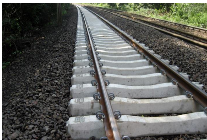
Rysunek 6. Przykładowy tor na podkładach strunobetonowe [6]
