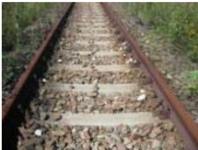
Rysunek 5. Przykładowy tor na podkładach żelbetowych [5]
