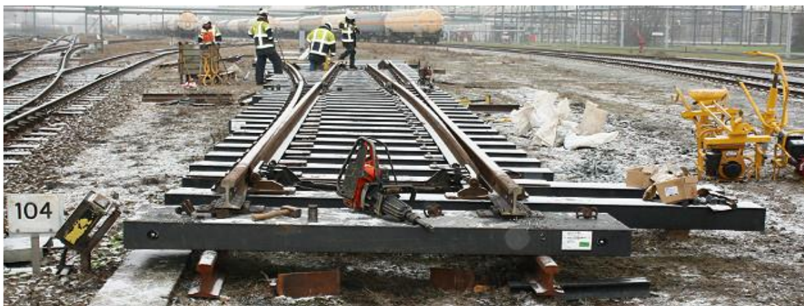
Rysunek 16. Podkłady kompozytowe w rozjazdach i skrzyżowaniach
