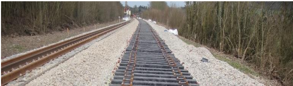
Rysunek 12. Przygotowane podkłady polimerowe firmy Sicut pod budowę toru [10]
