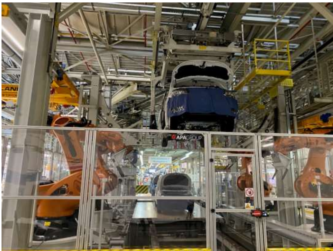
Rysunek 28. Roboty TYTAN. Stacja rozładunku samochodów z zawieszki na platformę
