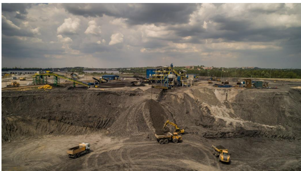
Rys. 2.7. Makroniwelacja terenu starej kopalni odkrywkowej piasku przez Haldex Sosnowiec
