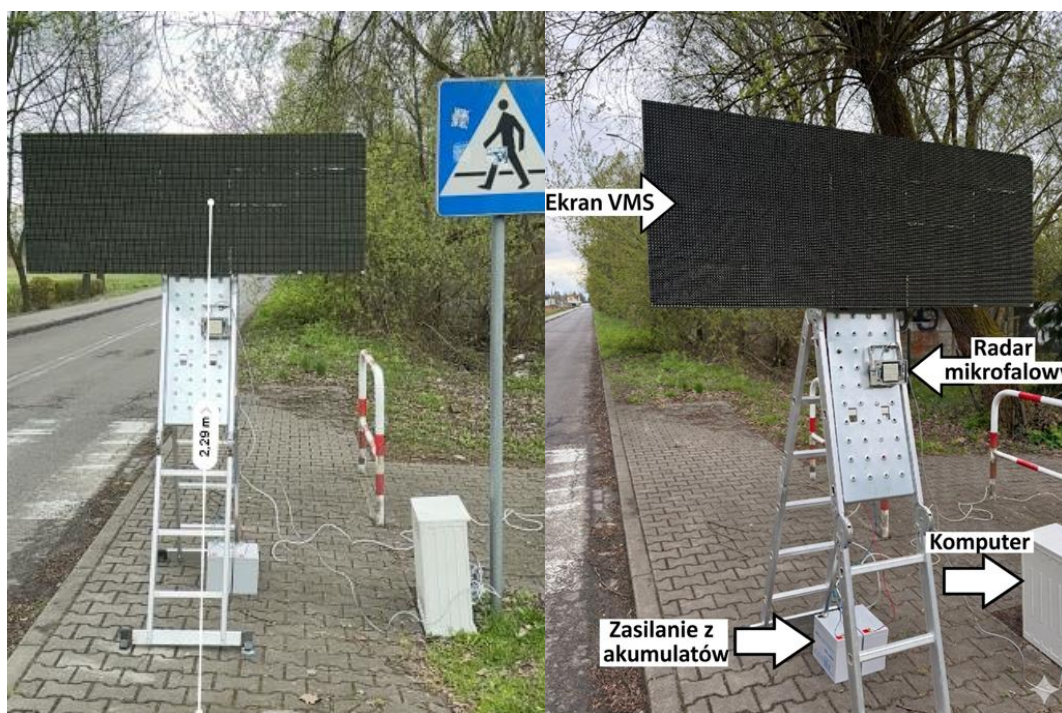
Rysunek 104. Zestawienie urządzeń systemu wsparcia bezpieczeństwa niechronionych uczestników ruchu drogowego
