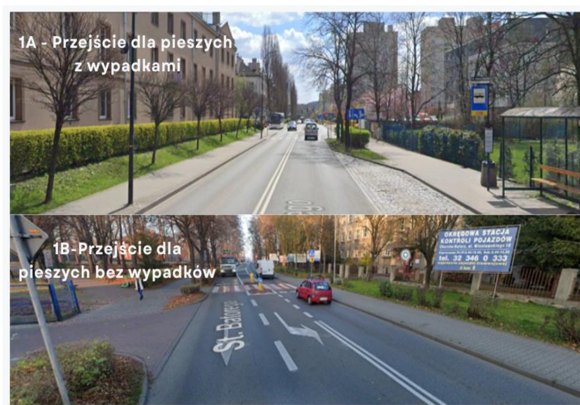
Rysunek 87. Przykładowe przejścia dla pieszych wybrane do procesu walidacji metod i modeli oceny bezpieczeństwa, przejścia nr 1 w ciągu ulicy Stefana Batorego w Chorzowie
