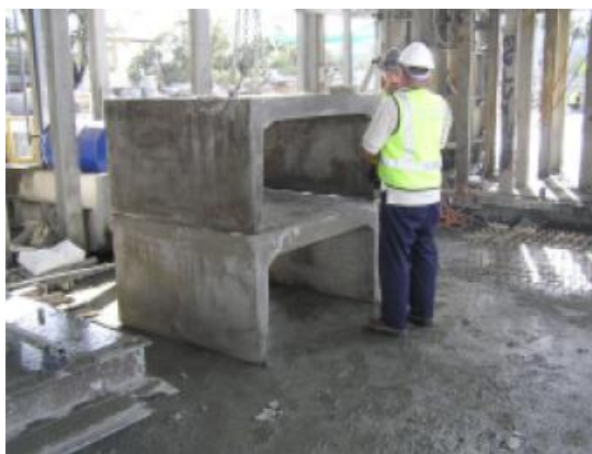
Rys. 30. Przepusty skrzynkowe wykonane z geopolimeru [143]
