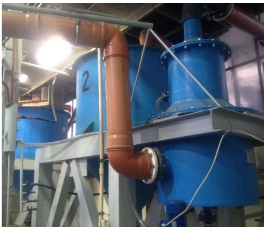
Rysunek 22 Układ absorpcji par procesowych
