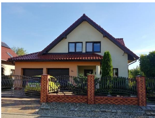
Rys. 5.1. Widok strony północnej domu jednorodzinnego objętego badaniami
