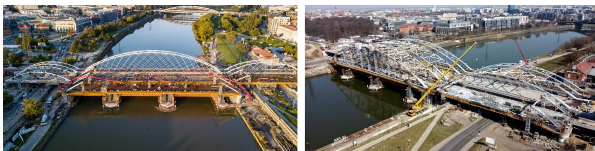
Rysunek 54. Obiekt M1 w trakcie budowy [207,210]
