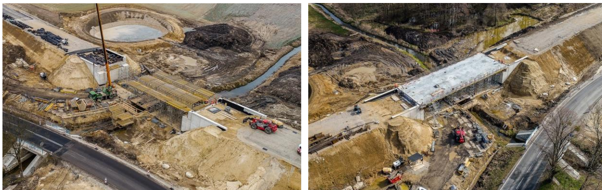
Rysunek 50. Obiekt MD-18 w trakcie budowy [202]
