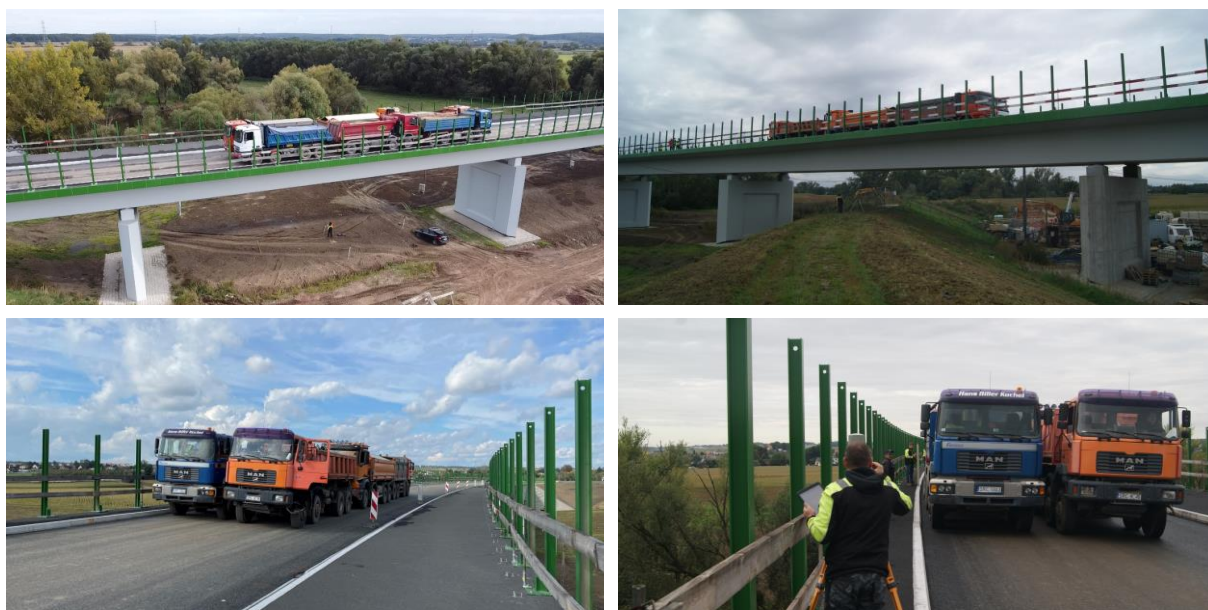
Rysunek 90. Próbne obciążenie obiektu MG-1
