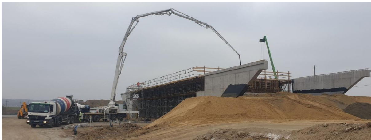
Rysunek 42. Obiekt WG-4 w trakcie budowy
