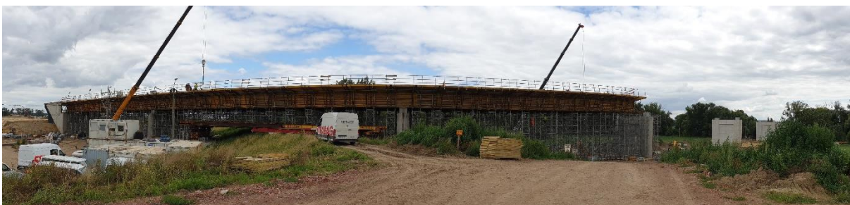
Rysunek 38. Obiekt MG-1 w trakcie budowy
