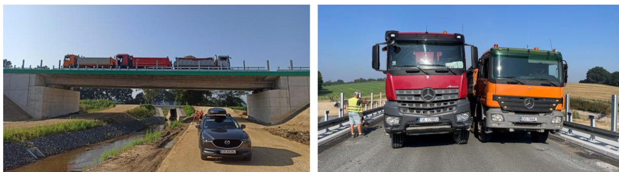
Rysunek 94. Próbné obciążenie obiektu MD-18
