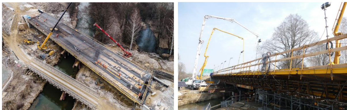
Rysunek 46. Obiekt MD-1 w trakcie budowy [202]
