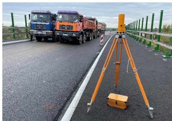
(b) pomiar przemieszczeń za pomocą niwelacji precyzyjnej
