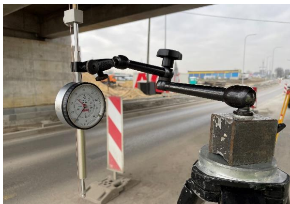
(a) pomiar przemieszczeń czujnikami zegarowymi
