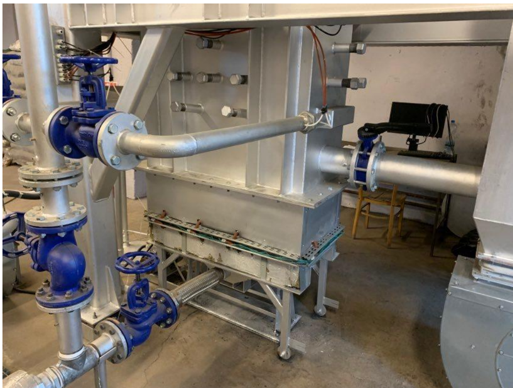
Rys. 8.16 Ruszt wibracyjny na stanowisku laboratoryjnym 0,5 MWt
