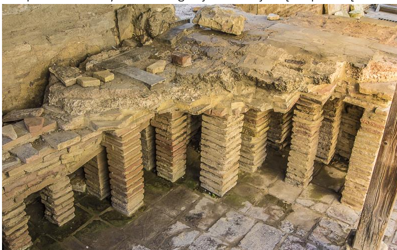
Zdjęcie 1 Rzymski system centralnego ogrzewania – Hypocaustum w termach Konstantyna. Autor: Jerry Everard.
