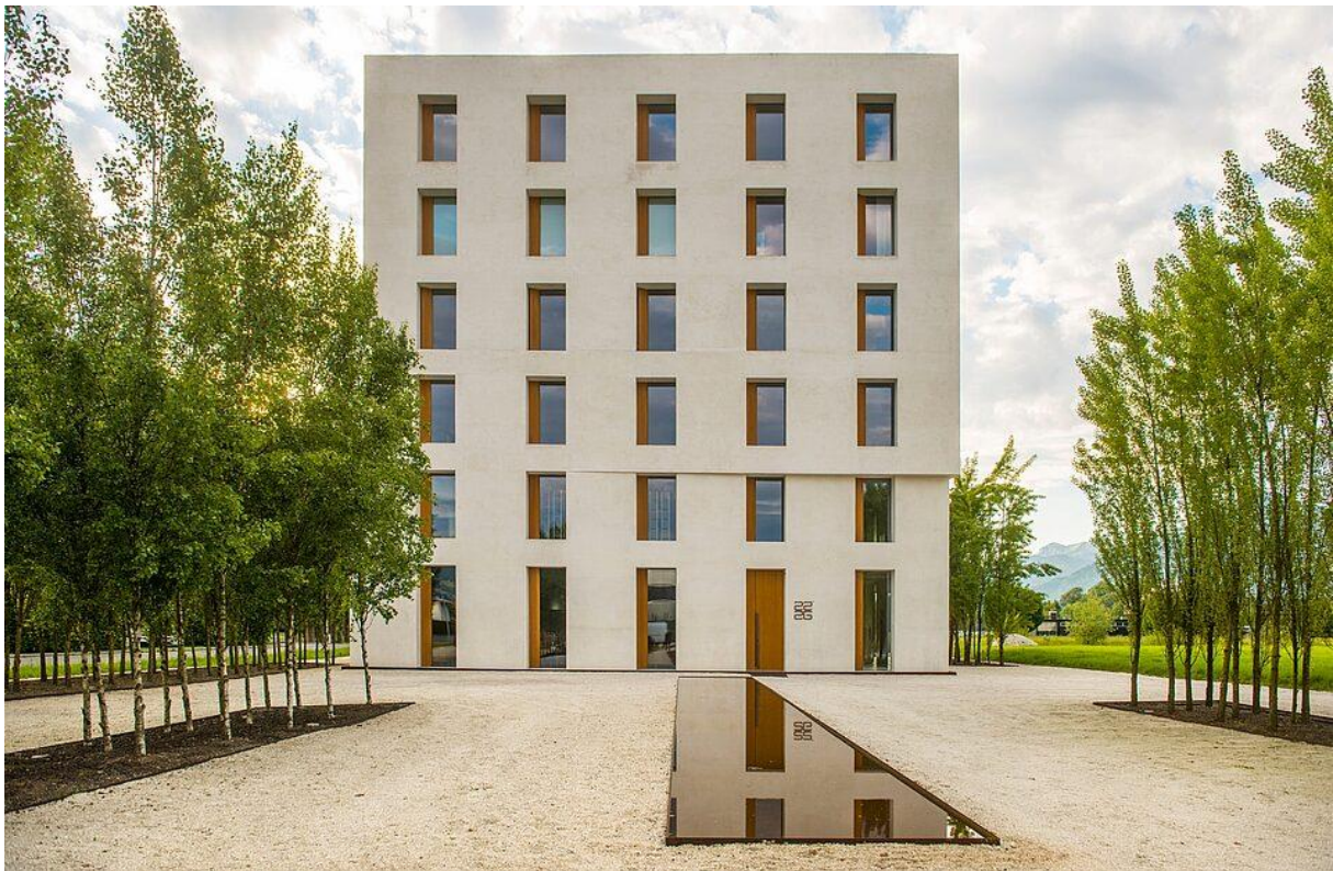
Zdjęcie 6. Budynek 2226, Lustenau, projektu pracowni Baumshlager Eberle.
