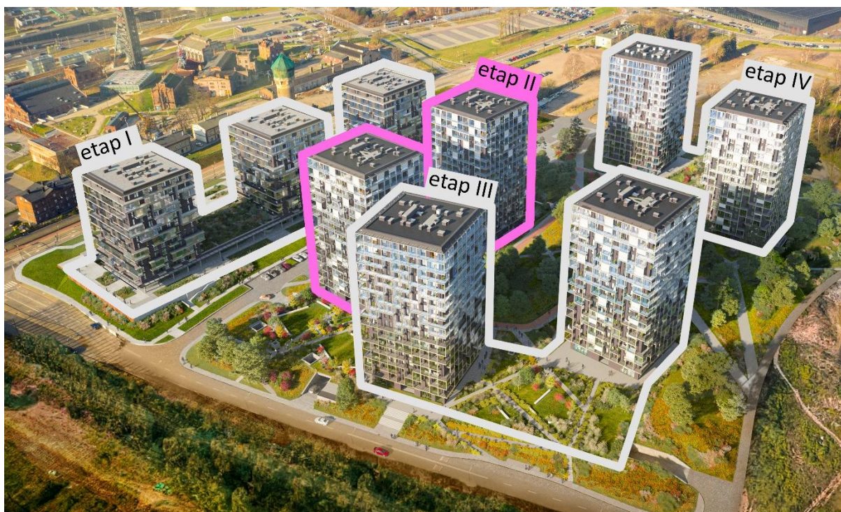
Ilustracja 58 Pierwsza Dzielnica w Katowicach, podział na etapy Źródło: opracowanie własne na podstawie materiałów Medusa Group
