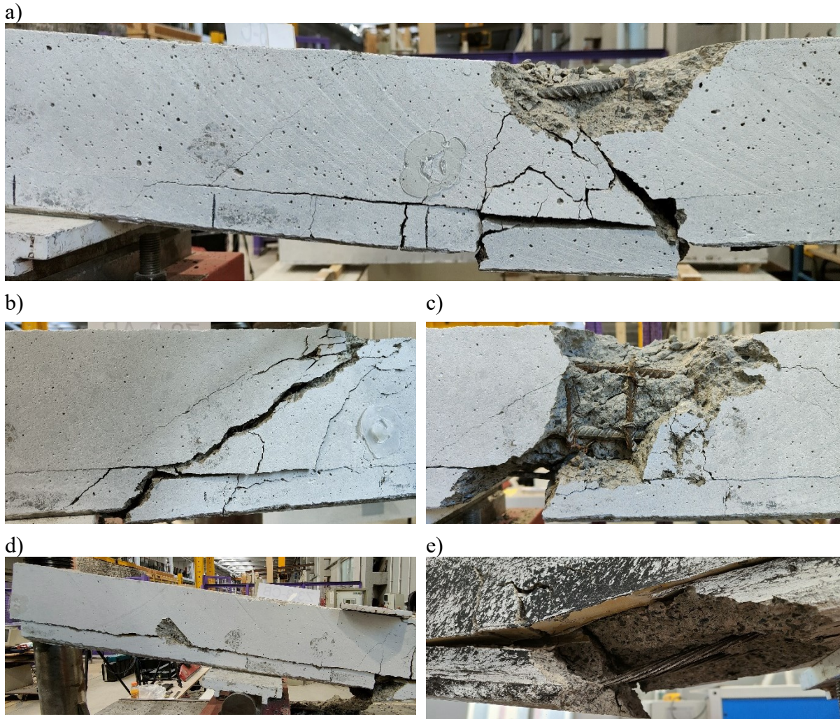
Fig. 6.49. View beams after failure: a) Z2.3_AB, b-c) Z2.3_AB, d-e) Z3.3_CB Rys. 6.49. Widok belek po zniszczeniu: a) Z2.3_AB, b-c) Z2.3_AB, d-e) Z3.3_CB
