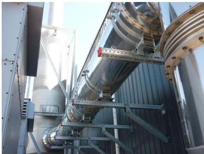
Rys. 2.5. Instalacja gazowa w elektrociepłowni [41]
