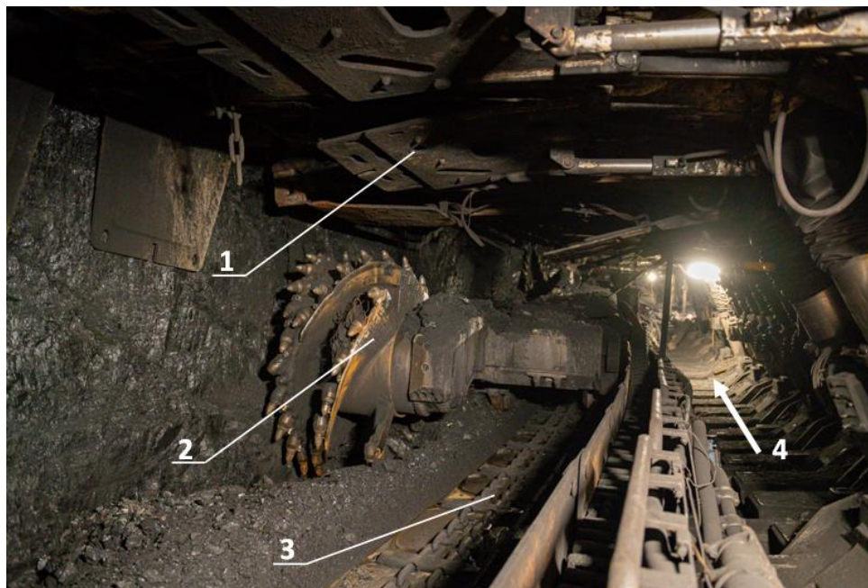
Rys. 2.3. Widok wyrobiska ścianowego z sekcjami obudowy ścianowej (1), kombajnem ścianowym (2), przenośnikiem zgrzeblowym (3) oraz drogą przejścia załogi (4)
