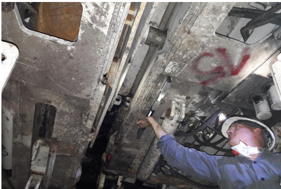
Rys. 8.4. Pomiar ręczne nachylenia stropnicy –przy użyciu BOCH Professional GIM 60
