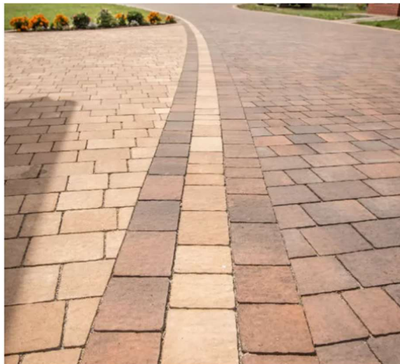
Rys. 13. Przykład zastosowania cementu hutniczego CEM III/A 42,5N - LH/HSR/NA do produkcji kostki brukowej [113]
