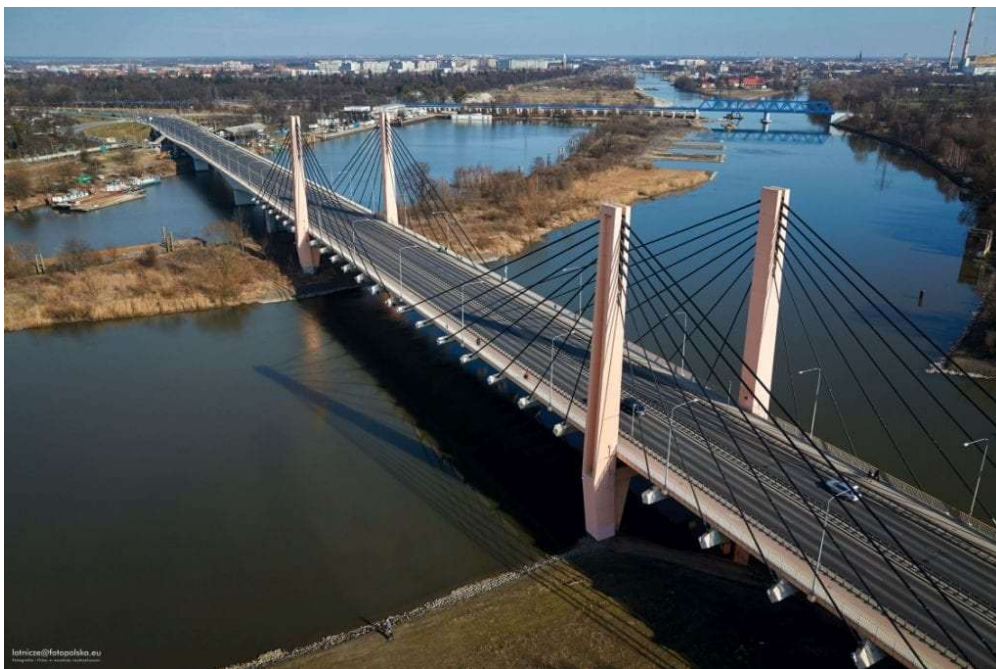
Rys. 7. Widok mostu „Milenium” we Wrocławiu [7]
