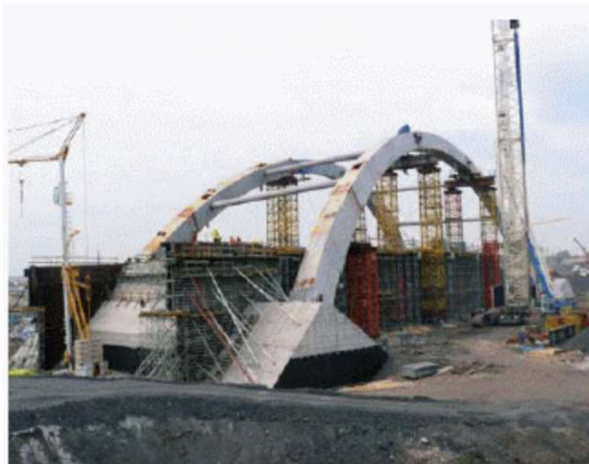
Rys. 19. Przyczółek obiektu WD 464 - węzeł Sośnica w Gliwicach [114]
