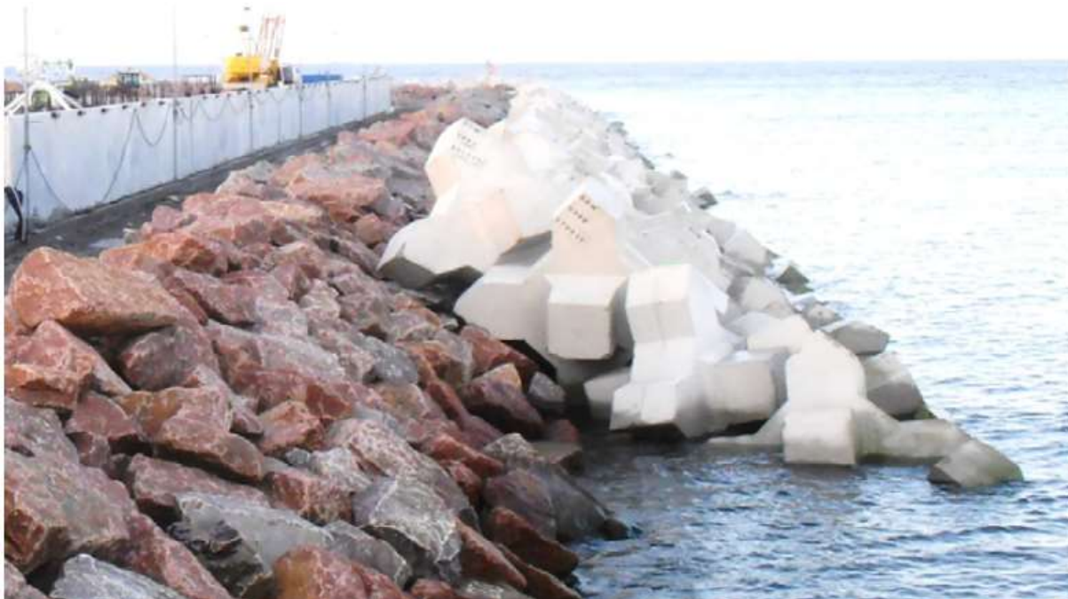
Rys. 10. Zabezpieczenie falochronu elementami prefabrykowanymi Xbloc w Świnoujściu [53]
