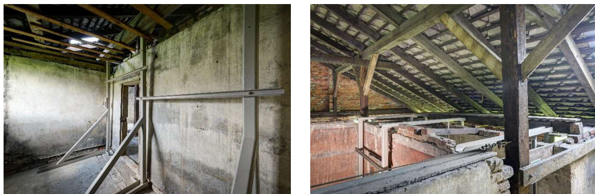
Rys. 7-31. B-123, zabezpieczenie ścian działowych
