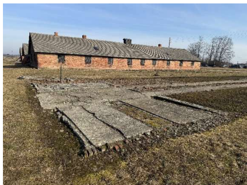
Rys. 5-9. Relikty – pozostałości ścian fundamentowych i posadzek po barakach rozebranych przed powstaniem Muzeum: a) posadzka betonowa, b) posadzka ceglana
