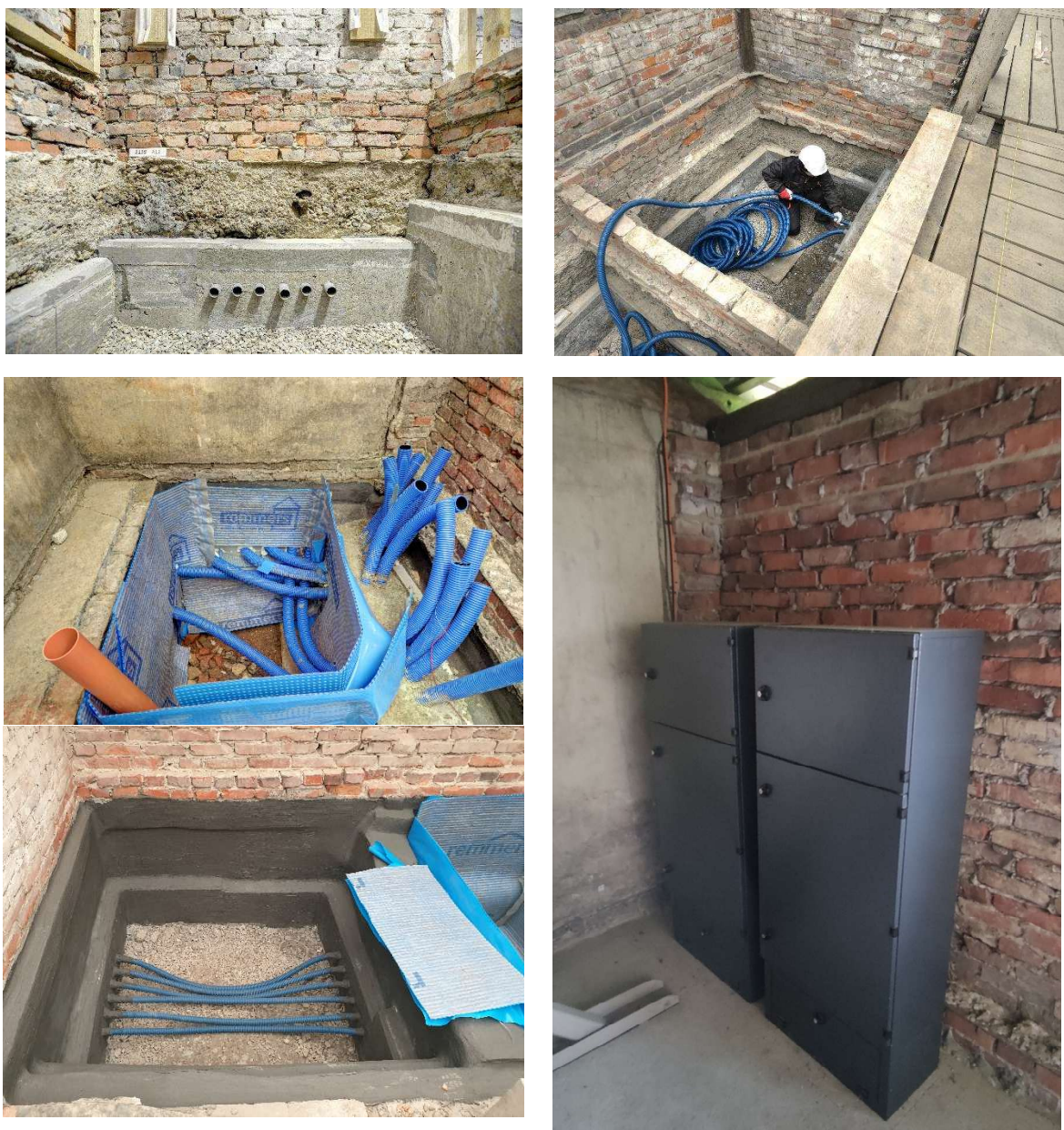
Rys. 4-41. Ułożenie kanalizacji kablowej, przejścia przez ścianę przygotowane na etapie betonowania podbić
