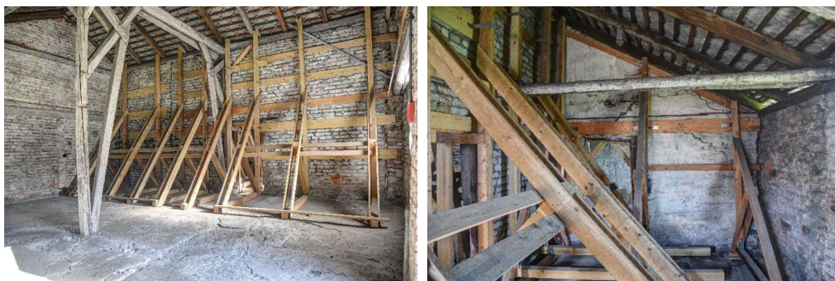
Rys. 7-20. Zabezpieczenie spękanych, niestabilnych wewnętrznych ścian tymczasowymi drewnianymi konstrukcjami – odcinek BIb, barak B-115
