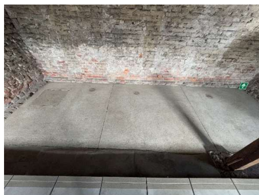
Rys. 5-7. Przykład rozmieszczenia betonowej posadzki zastępczej w baraku B-124
