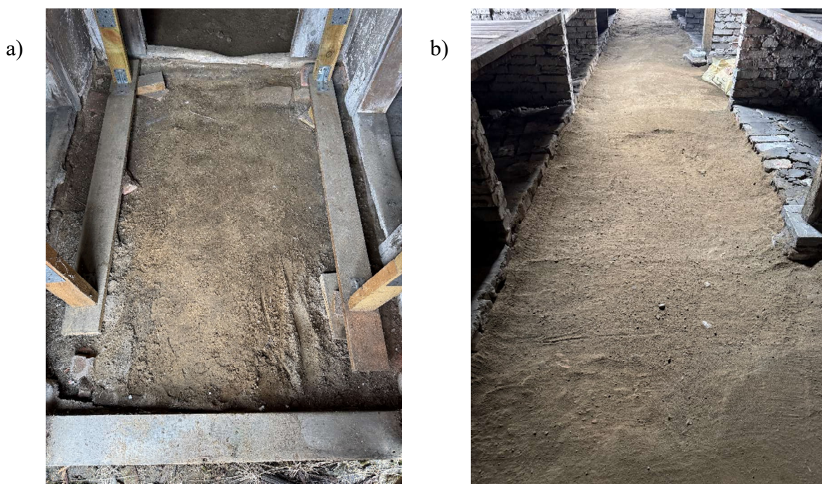
Rys. 5-4. Posadzka klepisko a), b) barak B-79
