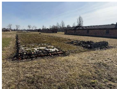
Rys. 5-9. Relikty – pozostałości ścian fundamentowych i posadzek po barakach rozebranych przed powstaniem Muzeum: a) posadzka betonowa, b) posadzka ceglana
