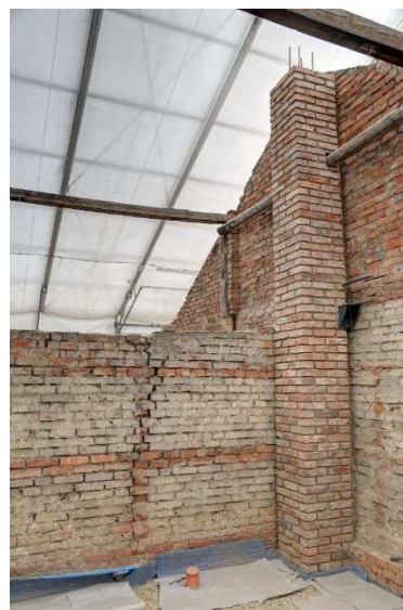
Rys. 7-47. Filar żelbetowo-murowany: a) filar podczas wykonywania warstwy murowanej, b) filar po zabetonowaniu i przykotwieniu do ściany szczytowej
