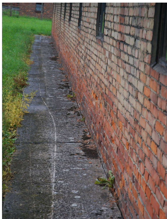
Rys. 4-14. Wtórna betonowa opaska przy baraku a) B-123, b) B-139
