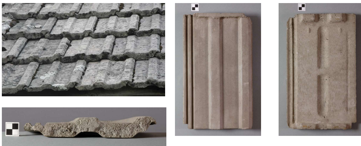
Rys. 6-7. Cementowa zakładkowa dachówka marsylska o wyrazistym, lecz płaskim podwójnym żłobieniu (typ 2)
