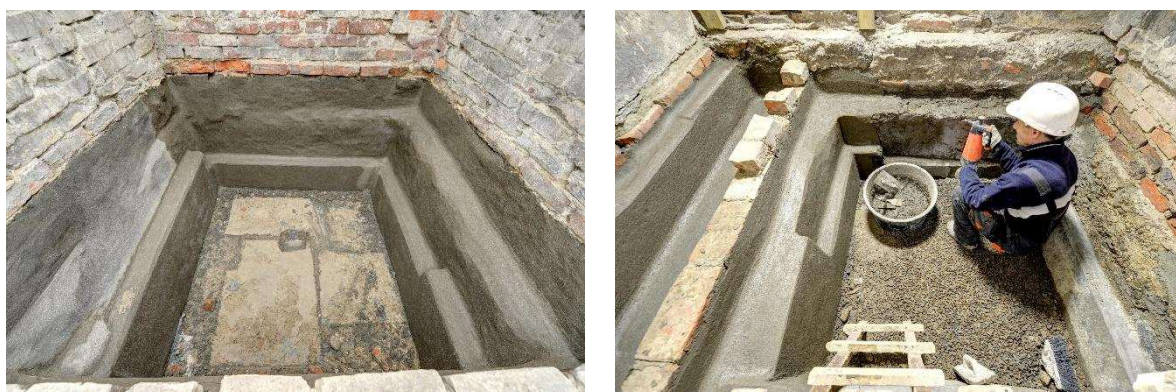
Rys. 4-34. Fundamenty po pobiciu: a) boczne powierzchnie fundamentów cechują się licznymi uskokami, b) układanie warstw hydroizolacji fundamentów
