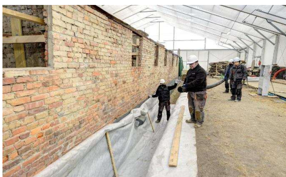
Rys. 4-36. Budowa drenażu opaskowego
