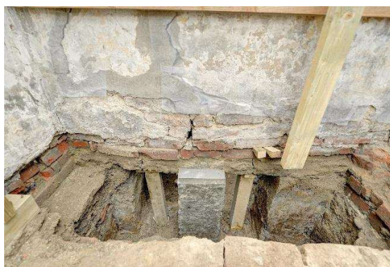
Rys. 4-33. Podbijanie fundamentów
