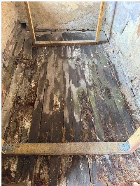
Rys. 5-10. Przykłady uszkodzeń posadzek: a) posadzka ceglana (barak B-113), b) posadzka ceglana (barak B-114), c) posadzka drewniana (barak B-134), d) posadzka betonowa (barak B-113)
