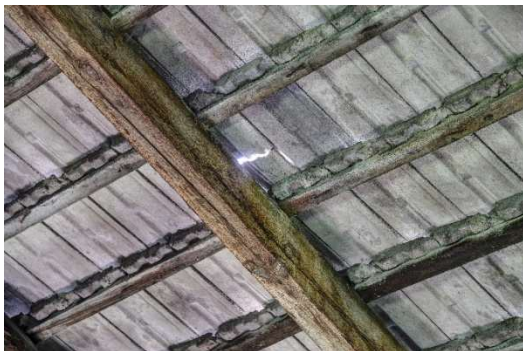
Rys. 6-15. Przykłady uszkodzeń poszycia dachowego a) pęknięcie pojedynczych dachówek (barak B-127), b) mech porastający dachówki
