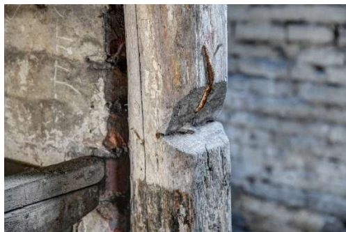
Rys. 6-16. Przykłady stosowania materiału rozbiórkowego do budowy więźb : a) przykład słupa więźby dachowej, który przed wojną w innym obiekcie pełnił prawdopodobnie funkcję krokwi, b) krokiew o przekroju kołowym
