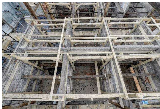
Rys. 4-39. Zabezpieczenie ścian boksów prycz drewnianymi konstrukcjami
