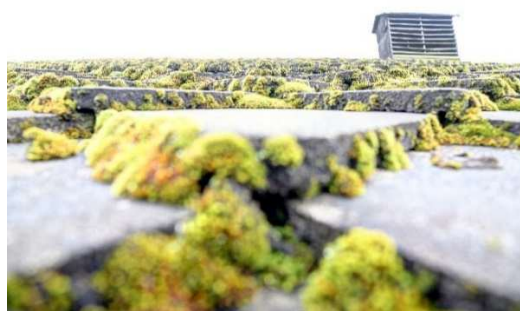
Rys. 6-15. Przykłady uszkodzeń poszycia dachowego a) pęknięcie pojedynczych dachówek (barak B-127), b) mech porastający dachówki
