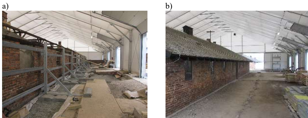
Rys. 7-45. Północna ściana podłużna baraku: a) ściana oraz zbudowana przy niej stalowa konstrukcja podczas rektyfikacji, b) ściana po przeprowadzonej rektyfikacji, ustabilizowaniu w nowym położeniu i zdemontowaniu konstrukcji stalowej.
