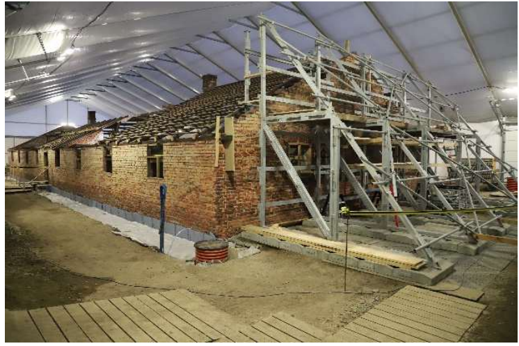
Rys. 9-7. Aparatura rejestrująca i rektyfikowana ściana w trakcie badań in situ
