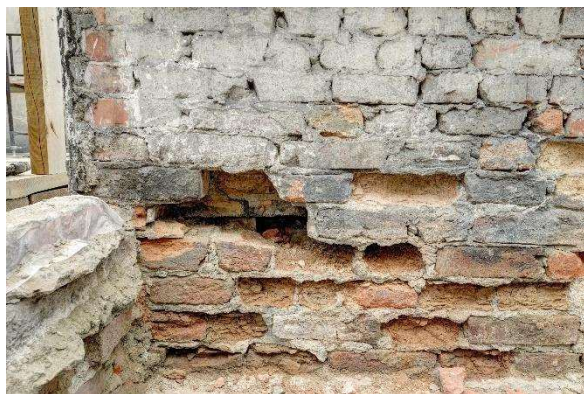
Rys. 4-6. Fundament – przykłady uszkodzeń górnych fragmentów ścian fundamentowych: a) korozja wywołana głównie przyczynami o charakterze biologicznym (uszkodzeń doznają pojedyncze cegły), b) uszkodzenia wywołane cyklami zamarzania (uszkodzeń doznają cegły znajdujące się w określonym położeniu)
