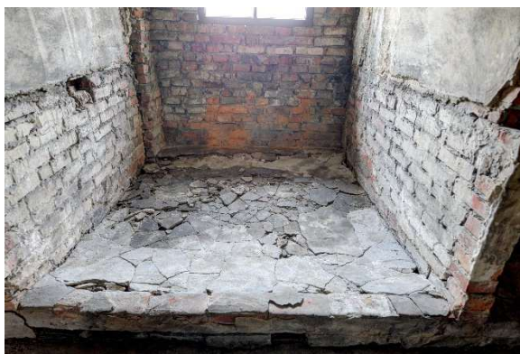
Rys. 5-14. Posadzki ceramiczne w boksach prysz, na których wykonano betonowe wtórne zacierki
