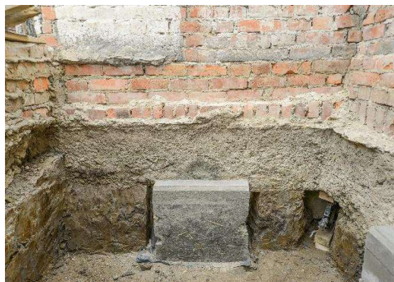
Rys. 4-32. Podbijanie fundamentów, a) przygotowany odcinek do szalowania, tymczasowo zabezpieczony podnośnikiem trapezowym, b) podbity fragment oryginalnej ławy fundamentowej
