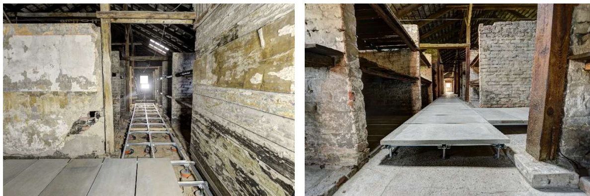
Rys. 5-5. Posadzka zastępcza betonowa
