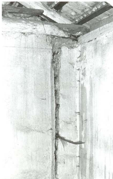
Rys. 7-14. Zniszczone połączenia w ścianach (dokumentacja z lat 60 XX w.: a) oderwanie ściany szczytowej od wewnętrznej podłużnej, b) oderwanie ściany zewnętrznej podłużnej od wewnętrznej działowej ściany poprzecznej, [5]
