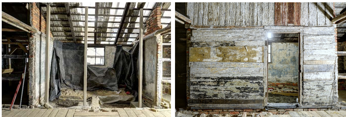
Rys. 7-32. Barak B-124, a) montaż stalowych elementów nośnych dla drewnianej ścianki, b) ścianka po montażu
