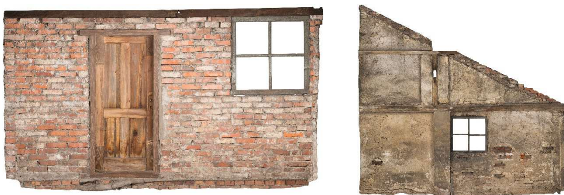
Rys. 4-21. Zdjęcia fotogrametryczne wykonane przed kompleksową konserwacją w Baraku B-123 a) ściana podłużna południowa (widok od środka), b) ściana szczytowa zachodnia (widok od środka)
