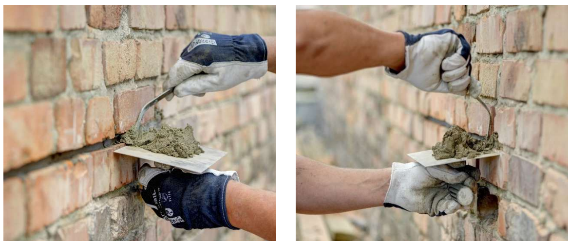
Rys. 7-52. Wzmocnienie ścian, uzupełnienie fugi po montażu prętów wzmacniających ze stali austenitycznej
