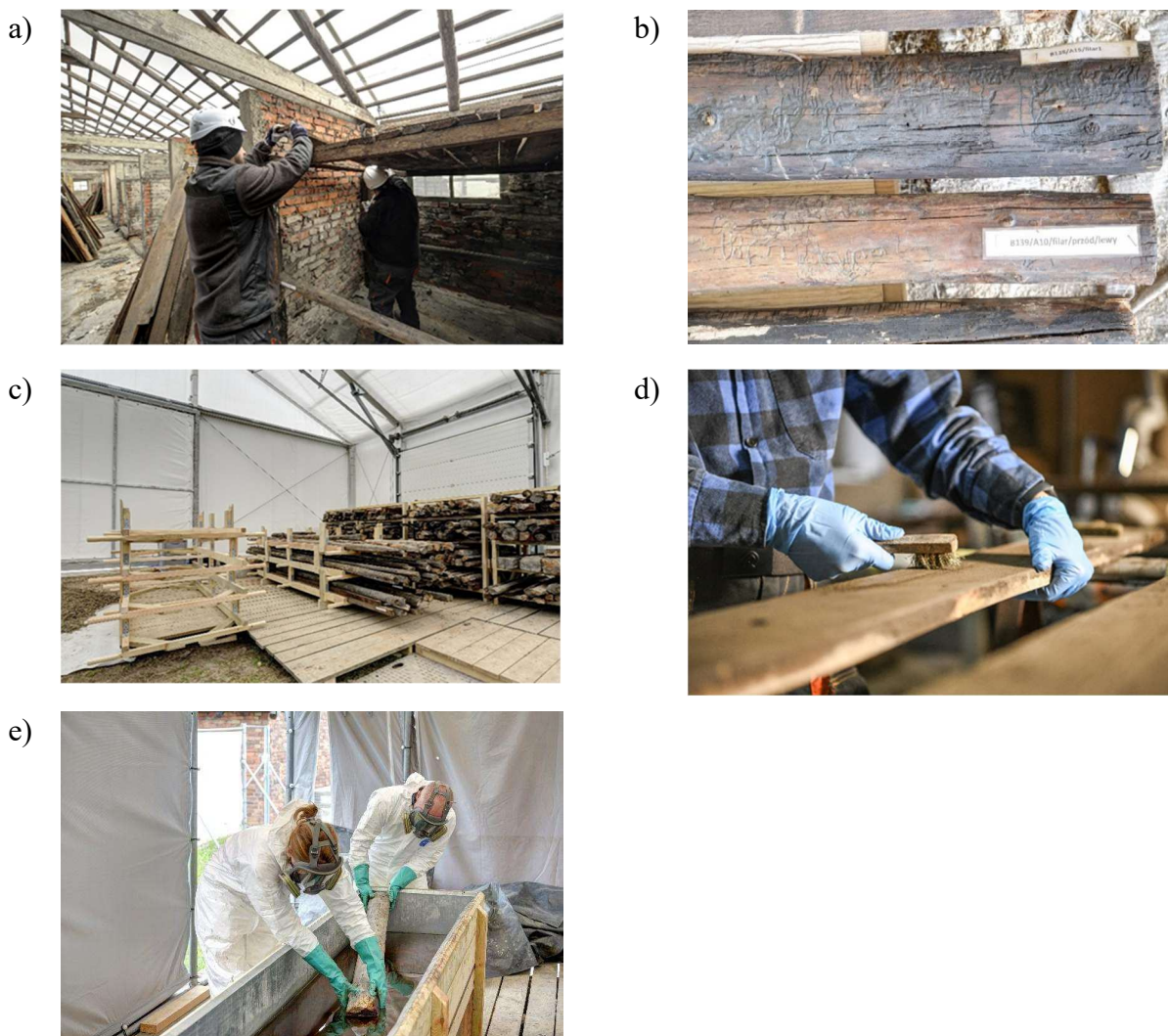
Rys. 4-38. Postępowanie z pryczami w trakcie wykonywania nowego posadowienia baraków: a) demontaż prycz, b) przykład oznaczenia elementów, c) składowanie elementów prycz, d) czyszczenie elementów prycz przed konserwacją, e) konserwacja
