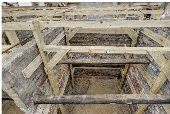
Rys. 4-39. Zabezpieczenie ścian boksów prycz drewnianymi konstrukcjami
