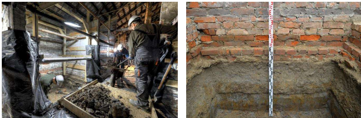
Rys. 4-23. Prace ziemne wewnątrz baraku, demontaż warstw podposadzkowych w boksach prycz
