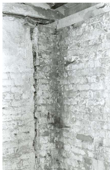
Rys. 7-13. Uszkodzona ściana zewnętrzna jednego z baraków murowanych, odcinek BIIb, rok 1958, [5]
