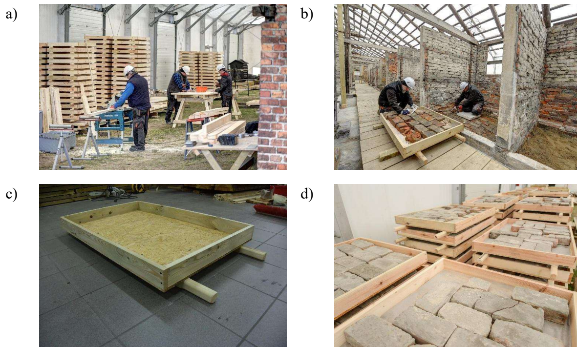
Rys. 5-16. Demontaż oryginalnej ceramicznej posadzki w boksach prycz: a) produkcja noszy, b) przekładanie cegieł do noszy, c) nosze, d) przechowywanie posadzki
