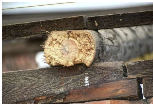
Rys. 6-16. Przykłady stosowania materiału rozbiórkowego do budowy więźb : a) przykład słupa więźby dachowej, który przed wojną w innym obiekcie pełnił prawdopodobnie funkcję krokwi, b) krokiew o przekroju kołowym
