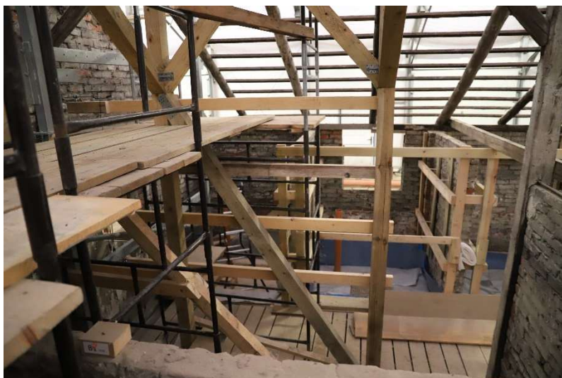
Rys. 7-38. Widok baraku, rektyfikowanej ściany i konstrukcji oporowej: a) od strony południowo-zachodniej, b) wnętrze baraku z widocznym pomostem, zastrzałami konstrukcji oporowej oraz drewnianą konstrukcją niezwiązaną z rektyfikowanym układem i pomostem
