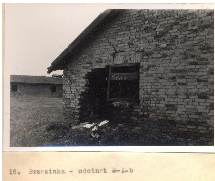
Rys. 7-13. Uszkodzona ściana zewnętrzna jednego z baraków murowanych, odcinek BIIb, rok 1958, [5]
