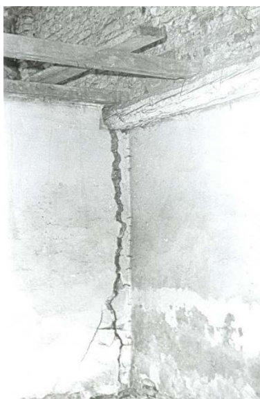
Rys. 7-13. Uszkodzona ściana zewnętrzna jednego z baraków murowanych, odcinek BIIb, rok 1958, [5]
