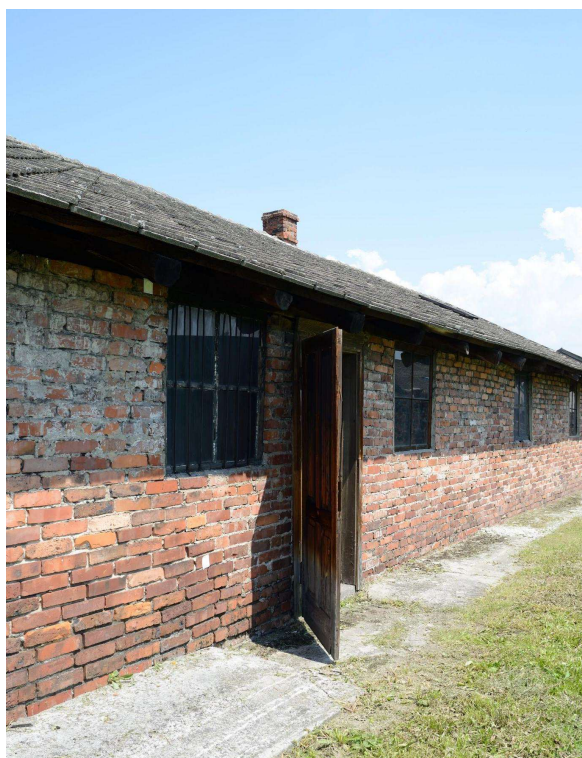
Rys. 4-14. Wtórna betonowa opaska przy baraku a) B-123, b) B-139
