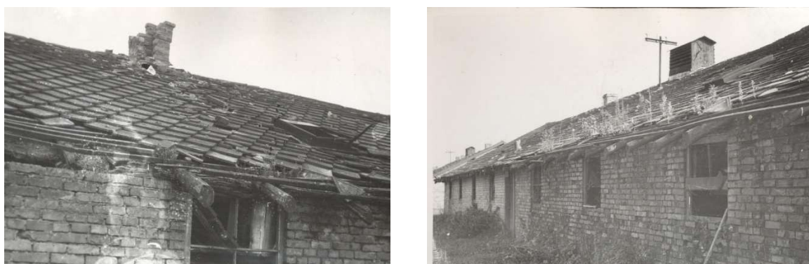
Rys. 6-18. Przykłady degradacji pokrycia dachowego w latach 60. XX w.
