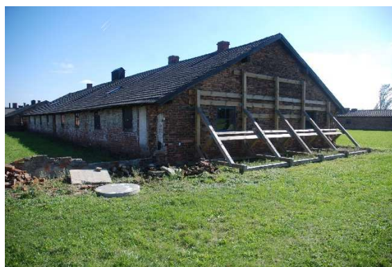
Rys. 7-15. Tymczasowe zabezpieczenie zdeformowanych ścian szczytowych zachodniej w baraku B-124
