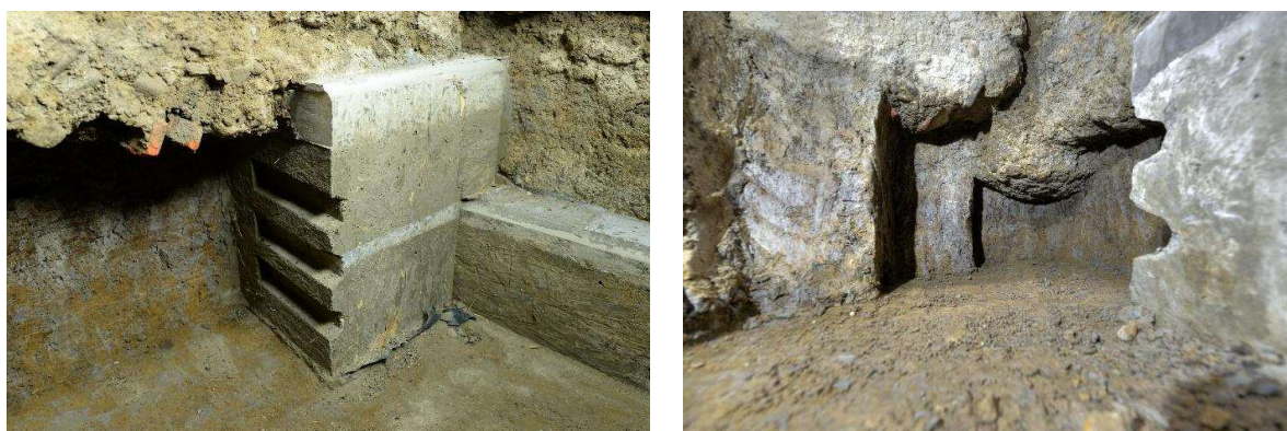
Rys. 4-26. Podbijanie fundamentów a) uzyskana powierzchnia z wrębami w miejscu przy końcu betonowanego odcina, b) podbicie fundamentu słupa drewnianego konstrukcji więźby dachowej
