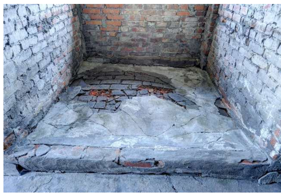
Rys. 5-14. Posadzki ceramiczne w boksach prysz, na których wykonano betonowe wtórne zacierki
