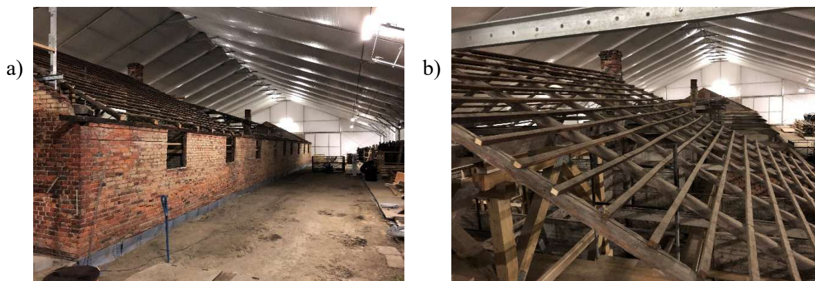
Rys. 2-8. Baraki B-138 i B-139 podczas remontu realizowanego w ramach GPK – widok ogólny: a) wnętrze namiotu z barakiem, b) drewniana więźba dachowa
