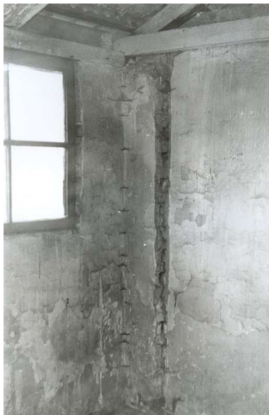
Rys. 7-14. Zniszczone połączenia w ścianach (dokumentacja z lat 60 XX w.: a) oderwanie ściany szczytowej od wewnętrznej podłużnej, b) oderwanie ściany zewnętrznej podłużnej od wewnętrznej działowej ściany poprzecznej, [5]
