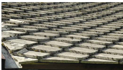
Rys. 6-8. Cementowa zakładkowa dachówka marsylska (typ 3) o wyrazistym, nieco kanciastym podwójnym żłobieniu.
