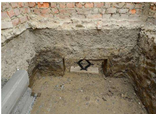
Rys. 4-32. Podbijanie fundamentów, a) przygotowany odcinek do szalowania, tymczasowo zabezpieczony podnośnikiem trapezowym, b) podbity fragment oryginalnej ławy fundamentowej
