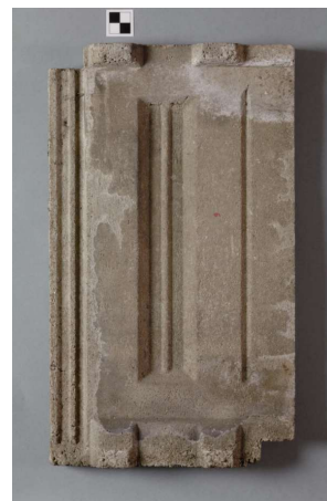
Rys. 6-8. Cementowa zakładkowa dachówka marsylska (typ 3) o wyrazistym, nieco kanciastym podwójnym żłobieniu.
