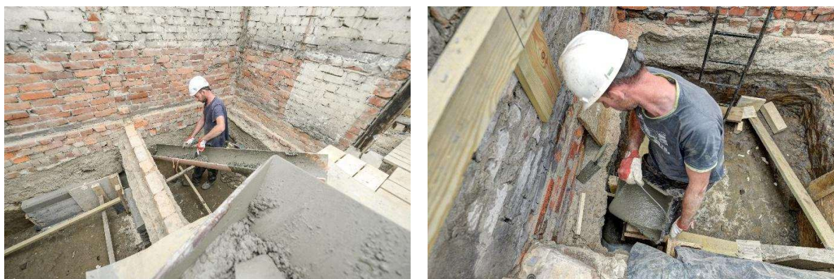
Rys. 4-27. Podbijanie fundamentów, betonowanie jednego z odcinków podbicia, prace ręczne.
