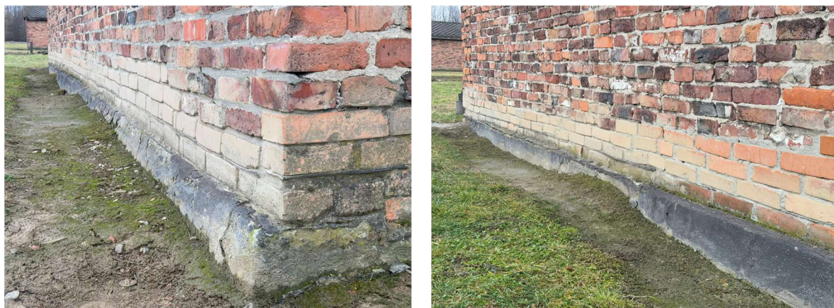
Rys. 4-12. Przykład wykonania wtórnej izolacji pionowej ułożonej na cementowej obrzutce – stan zachowania rozwiązania realizowanego w latach 90. XX w.
