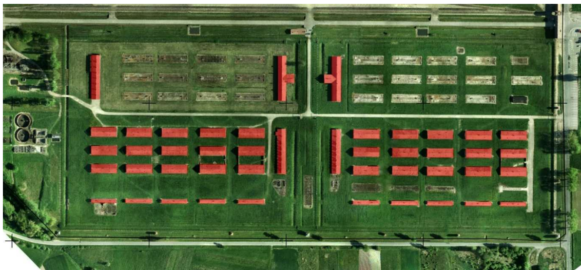
Rys. 2-6. Obiekty kubaturowe na odcinku BI zachowane do dnia dzisiejszego
