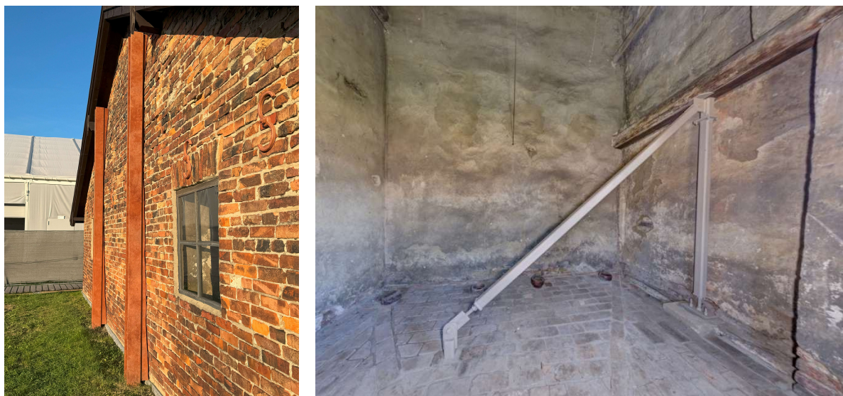
Rys. 7-26. Stabilizacja ściany szczytowej zachodniej w baraku B-123, odcinek B1b, a) widok wzmocnienia od zewnątrz, b) widok wzmocnienia wewnątrz)
