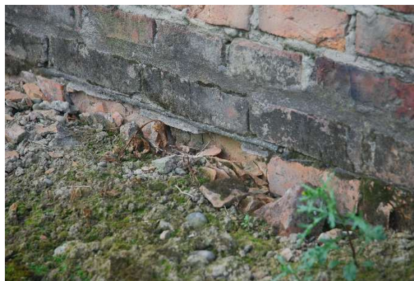
Rys. 4-6. Fundament – przykłady uszkodzeń górnych fragmentów ścian fundamentowych: a) korozja wywołana głównie przyczynami o charakterze biologicznym (uszkodzeń doznają pojedyncze cegły), b) uszkodzenia wywołane cyklami zamarzania (uszkodzeń doznają cegły znajdujące się w określonym położeniu)
