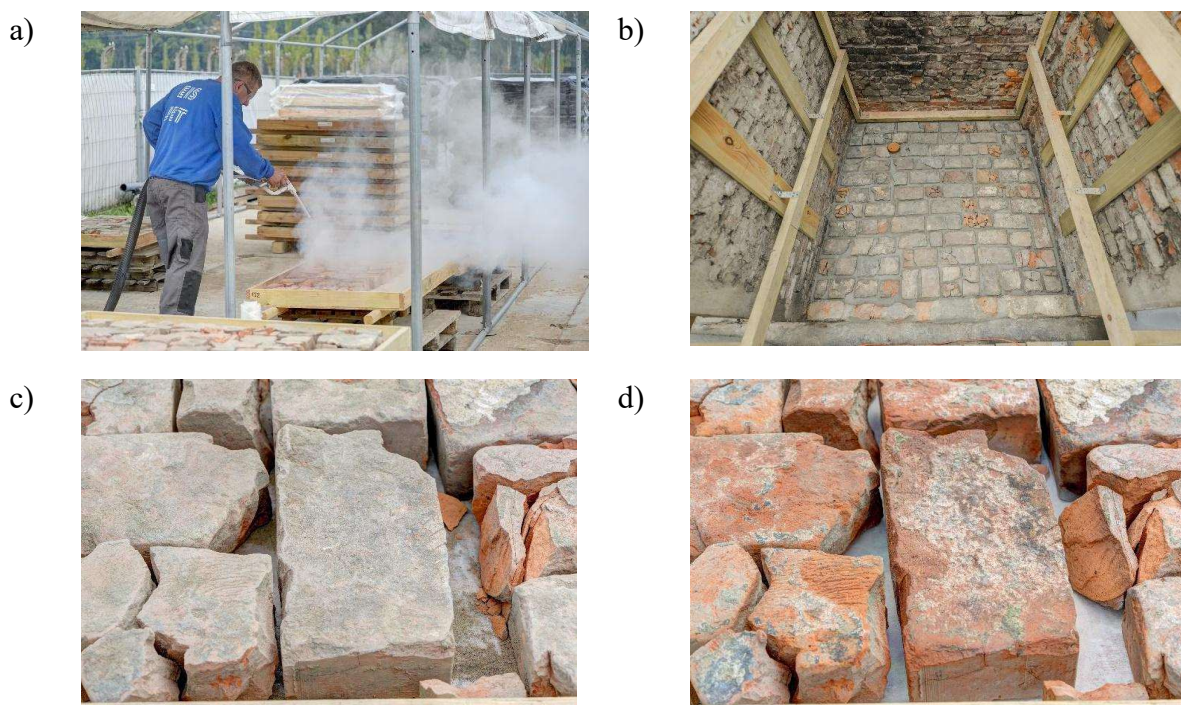
Rys. 5-17. Postępowanie z elementami ceramicznej posadzki po jej zdemontowaniu: a) czyszczenie za pomocą suchego lodu, b) posadzka po ponownym wbudowaniu, c), d) cegły przed zabiegiem i te same cegły po zabiegu
