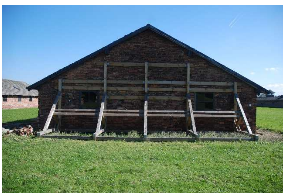
Rys. 7-15. Tymczasowe zabezpieczenie zdeformowanych ścian szczytowych zachodniej w baraku B-124
