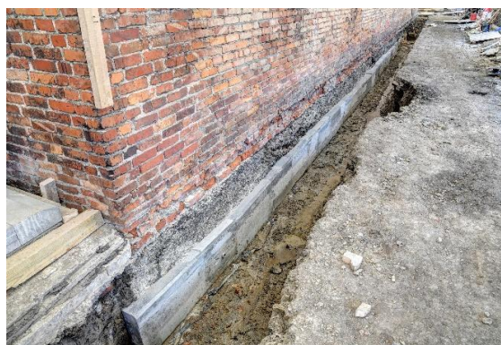
Rys. 4-32. Podbijanie fundamentów, a) przygotowany odcinek do szalowania, tymczasowo zabezpieczony podnośnikiem trapezowym, b) podbity fragment oryginalnej ławy fundamentowej
