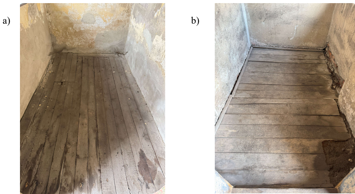
Rys. 5-2. Posadzka drewniana: a) barak B-127, b) barak B-75
