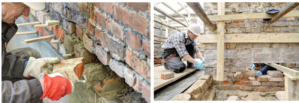
Rys. 4-25. Naprawa fundamentu ceglanego: a) ściana zewnętrzna podłużna, b) wewnętrzna ściana działowa
