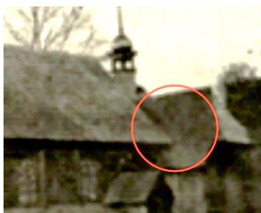
Rys. 152. Widok fragmentu dachu z zaznaczonym uskokiem u styku nawy i zakrystii [187]
