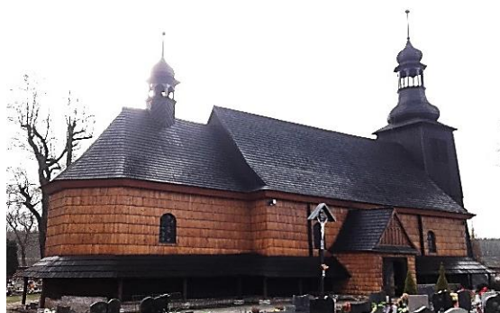
Rys. 151. Widok kościoła od północnego wschodu. Fotografia własna, 2018 r.
