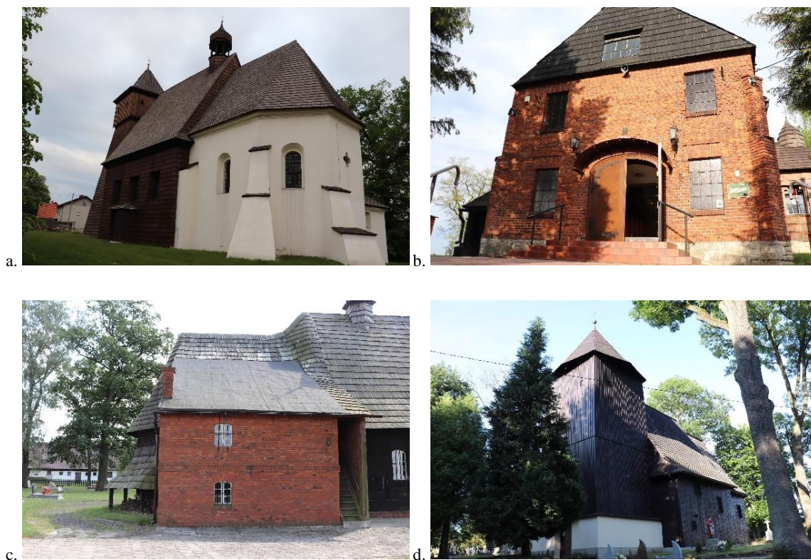
Rys. 86. Przykłady kościołów zbudowanych w technologii mieszanej – wybrane przykłady: a. widok murowanego prezbiterium oraz zakrystii w kościele w Sierotach (2019), b. murowana kruchta poprzedzająca nawę w kościele w Księżym Lesie (2018), c. murowana zakrystia w kościele w Zakrzowie Turawskim (2017), d. wieża kościoła w Bąkowie (2018). Fotografie własne
