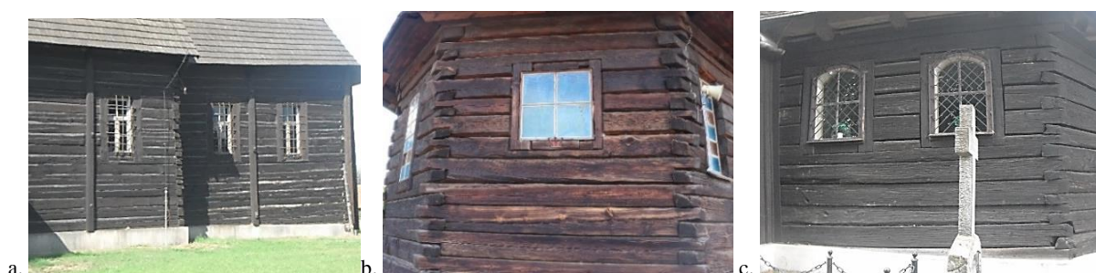
Rys. 79. Kościoły konstrukcji zrębowej nie szalowane – wybrane przykłady: a. fragment południowej elewacji kościoła w Chocianowicach (2021), b. fragment wschodniej ściany prezbiterium w kościele w Krzywiczynach (2008), c. fragment południowej elewacji prezbiterium w kościele w Maciejowie (2019). Fotografie własne
