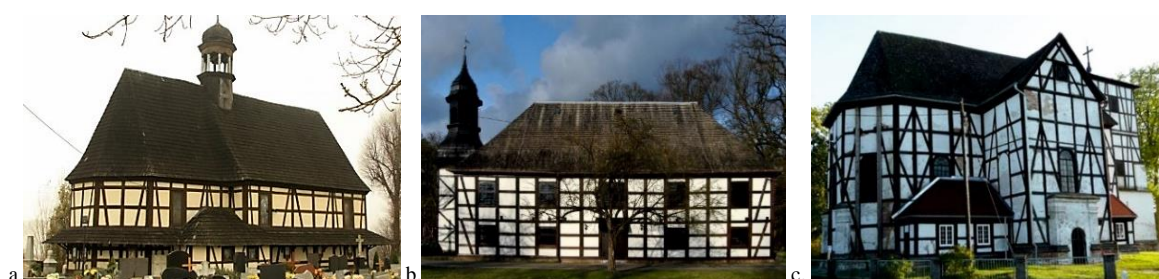
Rys. 59. Górnośląskie kościoły wzniesione w konstrukcji słupowo-ryglowej: a. Głogówek, b. Radomierowice, c. Wierzbica Dolna. Fotografie własne, 2017 r.
