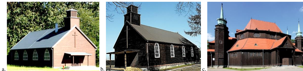
Rys. 60. Górnos Śląskie kościoły wzniesione w konstrukcji szkieletowej: a. Górnos Śląski Skansen Etnograficzny w Chorzów – kościół ewangelicki, b. Zabrze-Mikulczyce, c. Zabrze-Poręba. Fotografie własne, 2017 r.
