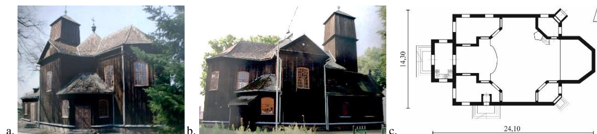
Rys. 42. Łęki Wielkie, kościół pw. św. Katarzyny i Niepokalanego Serca Maryi: a. widok południowo-zachodni [329], b. elewacja północna [133], c. schemat rzutu – opracowanie własne
