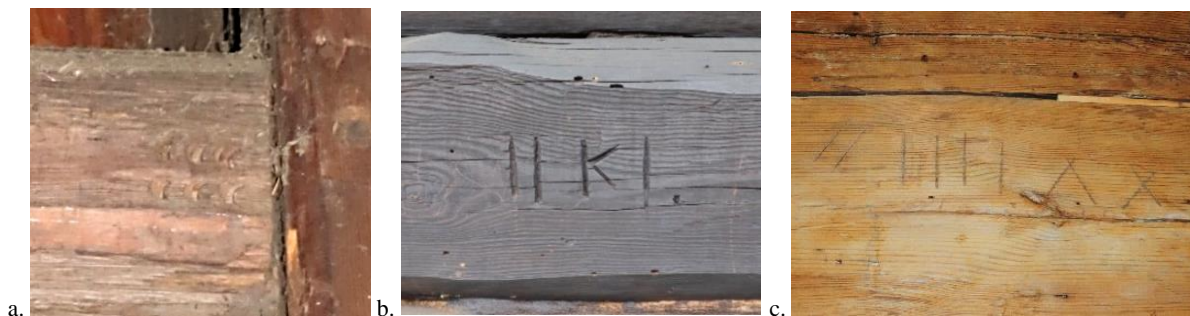
Rys. 63. Znaki ciesielskie: a. Opole-Bierkowice, Muzeum Wsi Opolskiej, kościół pw. św. Katarzyny, fragment południowej ściany wieży, b. Istebna-Kubalonka, kościół pw. Krzyża Świętego, fragment południowo-wschodniej ściany nawy, c. Przewóz, kościół pw. św. Judy Tadeusza, fragment ściany zamykającej prezbiterium. Fotografie własne, 2022 r.
