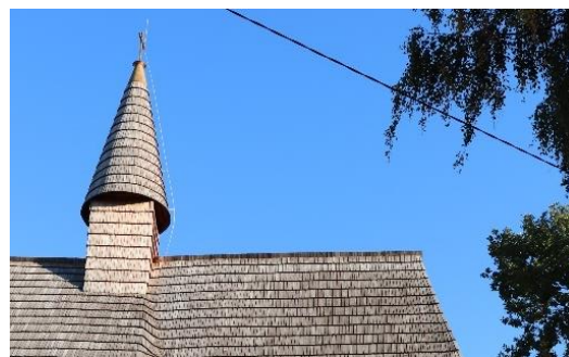
Rys. 158. Widok sygnaturki po przebudowie. Fotografia własna, 2021 r.
