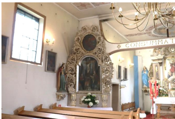
Rys. 159. Widok fragmentu północnej ściany nawy i prezbiterium obudowanej płytami gipsowo-kartonowymi. Fotografia własna, 2019 r.
