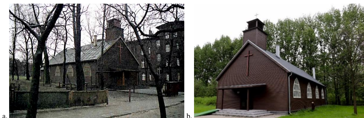
Rys. 21. Kościół ewangelicki z Bytomia, dzielnicy Bobrek: a. kościół przed pożarem w Bytomiu w dzielnicy Bobrek [355], b. kościół ewangelicko-augsburski zrekonstruowany w Górnośląskim Parku Etnograficznym w Chorzowie, fotografie własne (2019)
