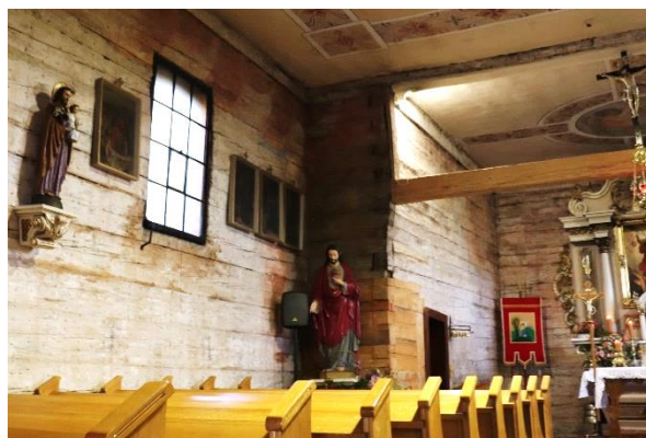
Rys. 160. Widok fragmentu nieobudowanej zrębowej konstrukcji północnej ściany nawy i prezbiterium. Fotografia własna, 2021 r.
