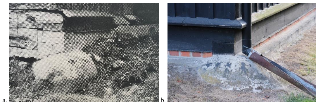
Rys. 67. Posadowienie kościoła w Gołkowicach k. Kluczborka: a. fotografia archiwalna [237], b. stan istniejący, fotografia własna, 2019
