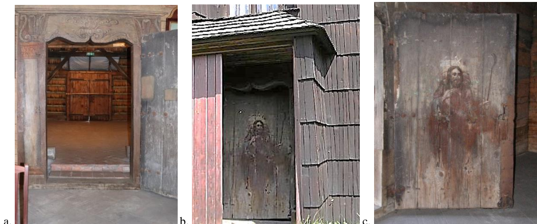
Rys. 116. Drzwi w kościele pw. św. Jerzego w Gliwicach-Ostropie: a. portal dębowy wykonany w kształcie oślego grzbietu wieża-nawa (fotografia własna, 2022), b. drzwi wewnętrzne w kruchcie bocznej, c. skrzydło drzwiowe w kruchcie bocznej z polichromią z wizerunkiem Chrystusa Dobrego Pasterza (fotografie: Jacek Hulimka, 2016)
