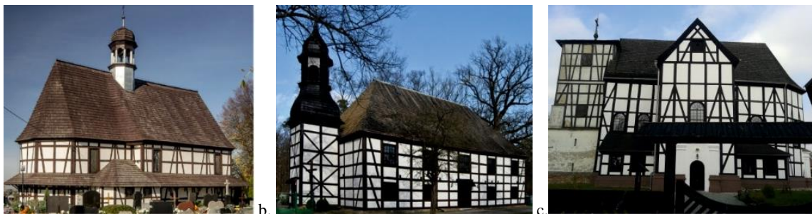
Rys. 83. Górnośląskie kościoły drewniane zbudowane w konstrukcji słupowo-ryglowej: a. Głogówek (2019), b. Radomierowice (2018), c. Wierzbica Górna (2021). Fotografie własne
