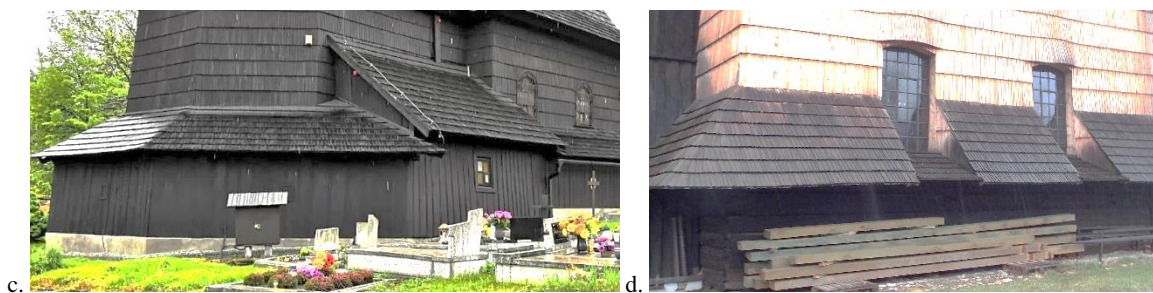
Rys. 102. Soboty i przydaszki, wybrane przykłady: a. Grodzisko – soboty otwarte wsparte na słupach z mieczowaniami (2020), b. Miedzna – soboty do połowy zabudowane (2018), c. Bielowicko – soboty zamknięte (2019), d. Sieroty – przydaszki z wykrojem na otwory okienne (2018). Fotografie własne
