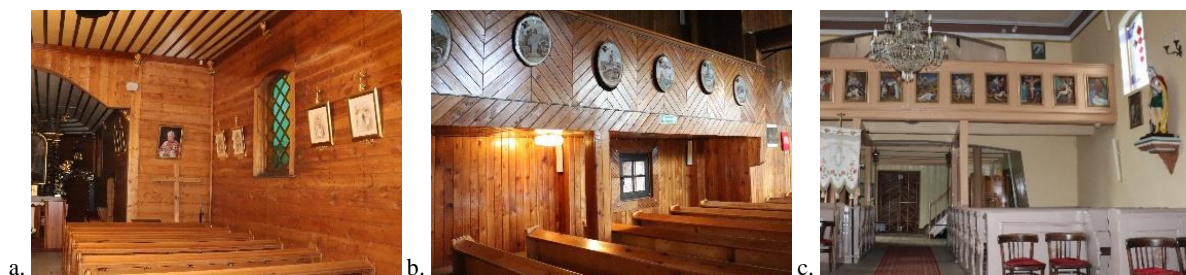
Rys. 78. Przykładowe szalowanie ścian wnętrza kościoła: a. Dobrodzień – fragment południowej ściany nawy i prezbiterium (2019), b. Komorzno – fragment północnej ściany nawy i prezbiterium (2020), c. Gołkowice k. Wodzisławia Śląskiego – fragment północno-zachodniej ściany nawy (2020). Fotografie własne
