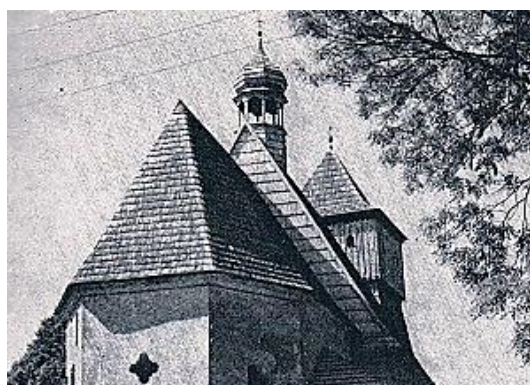
Rys. 145. Widok przywróconej, strzelistej formy dachów [239]
