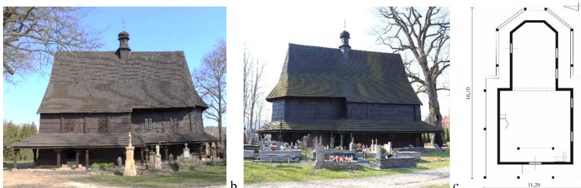
Rys. 32. Lipnica Murowana, kościół pw. św. Leonarda: a. elewacja południowa (2019), b. elewacja północna (2019), c. schemat rzutu – opracowanie własne
