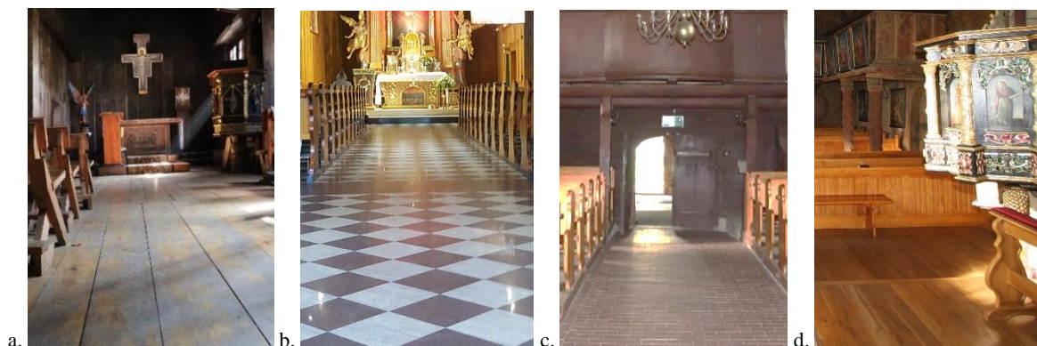
Rys. 72. Przykładowe wykończenie podłóg: a. deski (Katowice, 2019), b. płytki ceramiczne (Rybnik-Kuźnia Ligocka, 2020), c. cegła (Proślice, 2021), d. panele (Żernica, 2018). Fotografie własne
