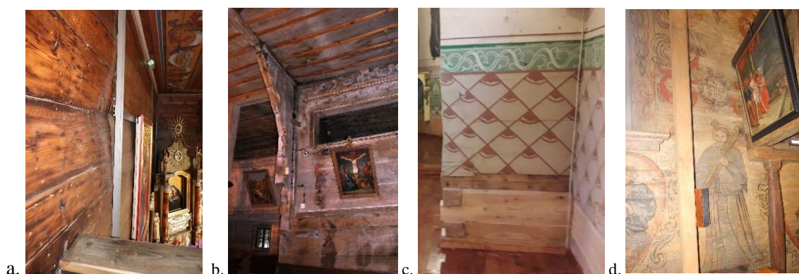
Rys. 80. Wnętrze kościoła z widocznymi belkami zrębowymi – wybrane przykłady: a. fragment północnej ściany nawy, Bierań Stary (2019), b. fragment północnej ściany prezbiterium, Jakubowice (2021), c. fragment ściany tęczowej w południowym narożniku nawa-prezbiterium, Świniary Wielkie (2021), d. fragment południowej ściany nawy (Żernica, 2021). Fotografie własne
