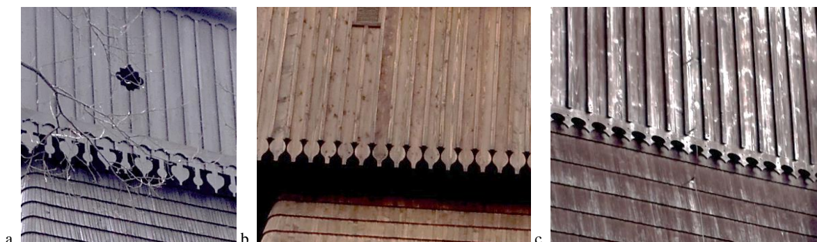
Rys. 117. Przykłady detalu ciesielskiego wykonanego w dolnych partiach nadwieszonej izbicy – wybrane przykłady: a. Łaziska Rybnickie (2020), b. Miedzna (2019), c. Żernica (2018). Fotografie własne
