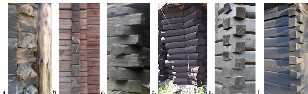
Rys. 75. Wiązanie ścian konstrukcji zrębowej z ostatekami: a. Chocianowice (2019), b. Lubliniec (2018), c. Maciejów (2020), d. Pawelki (2021), e. Poniszowice (2020), f. Smolnica (2022). Fotografie własne
