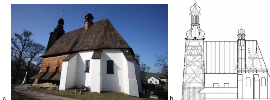
Rys. 94. Przykładowe rozwiązanie dachu dwukalenicowego, kościół pw. Wszystkich Świętych w Sierotach: a. widok elewacji południowej, fotografia własna (2019), b. schemat przekroju podłużnego, opracowanie własne
