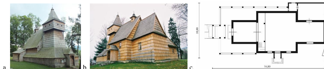
Rys. 34. Grywałd, kościół pw. św. Marcina: a. elewacja południowo-wschodnia (2018), b. elewacja północno-zachodnia (2020), c. schemat rzutu –opracowanie własne
