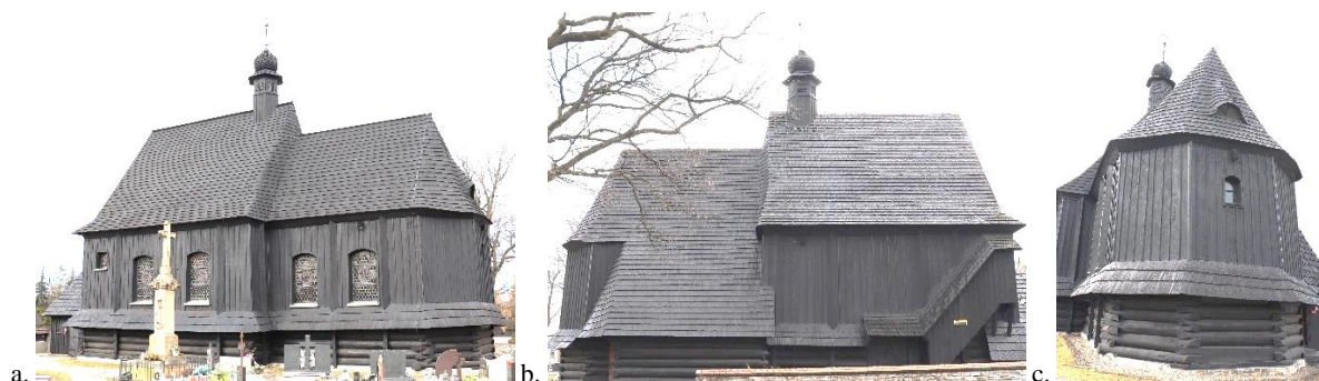
Rys. 111. Zastosowanie stolarki okiennej na przykładzie kościoła pw. św. Walentego w Bieruniu Starym: a. doświetlenie kościoła od strony południowej, b. brak okien w elewacji północnej, c. ujęcie niewielkiego okna w ścianie zamykającej prezbiterium. Fotografie własne (2018)
