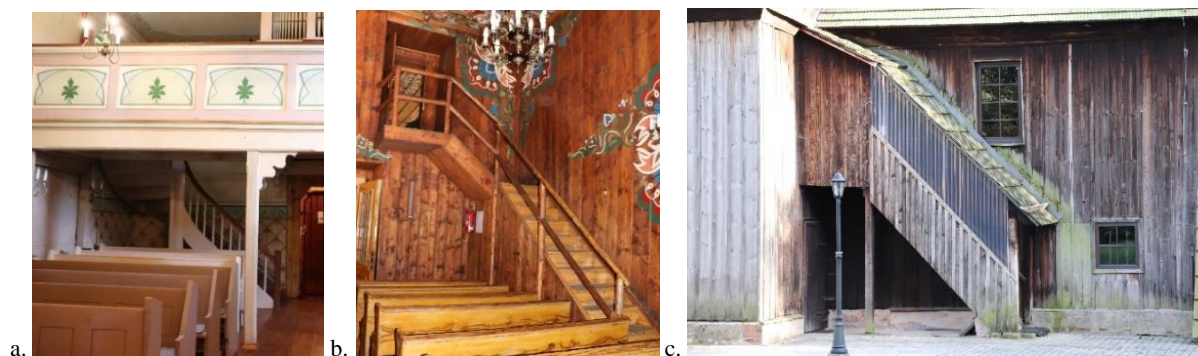
Rys. 89. Dostępność komunikacyjna empory muzycznej: a. Świniary Wielkie: wewnętrzne schody wbudowane w narożniku nawy (2020) b. Kaczyce: schody wbudowane w parterze wieży (2019), c. Komorzno: zewnętrzne schody dostawione do bocznej ściany nawy (2017). Fotografie własne
