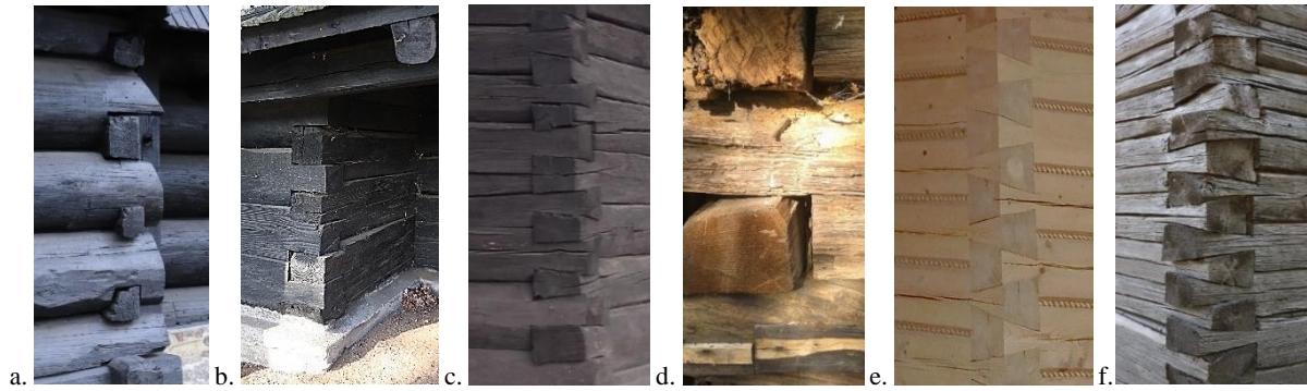
Rys. 76. Wiązanie ścian konstrukcji zrębowej bez ostatków: a. Bieruń Stary (2019), b. Bojszów (2020), c. Mikołów -Borowa Wieś (2019), d. Brzezinki (2020), e. Stecówka (2019), f. Smolnica (2022). Fotografie własne
