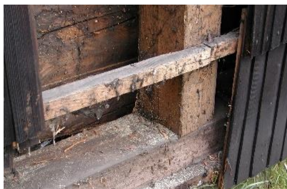
Rys. 148. Widok fragmentu wtórnej konstrukcji szkieletowej dostawionej do północnej ściany nawy. Fotografia: J. Hulimka, 2008 r.
