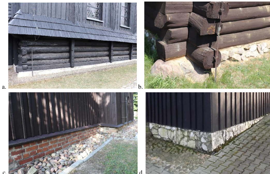
Rys. 68. Rodzaje stosowanych posadowień – wybrane przykłady: a. posadowienie na otynkowanej, kamiennej podmurówce (Bieruń Stary, 2028), b. posadowienie na głazach i kamiennej podmurówce (Pawelki, 2021), c. posadowienie na głazach i podmurówce wykonanej z kamienia i cegły (Jakubowice, 2020), d. kamienna podmurówka (Biskupice k. Olesna, 2019). Fotografie własne
