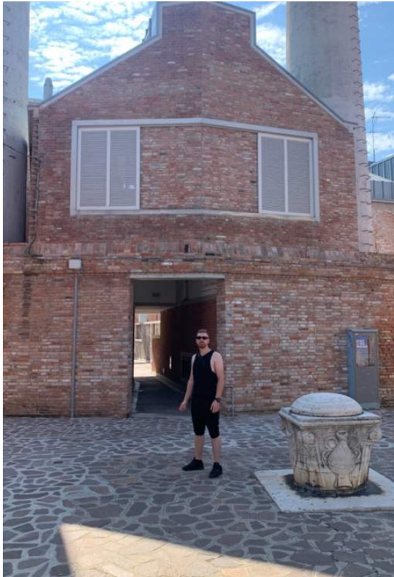
II.87. Widok na budynek A obiektu Le Conterie od strony północnej
