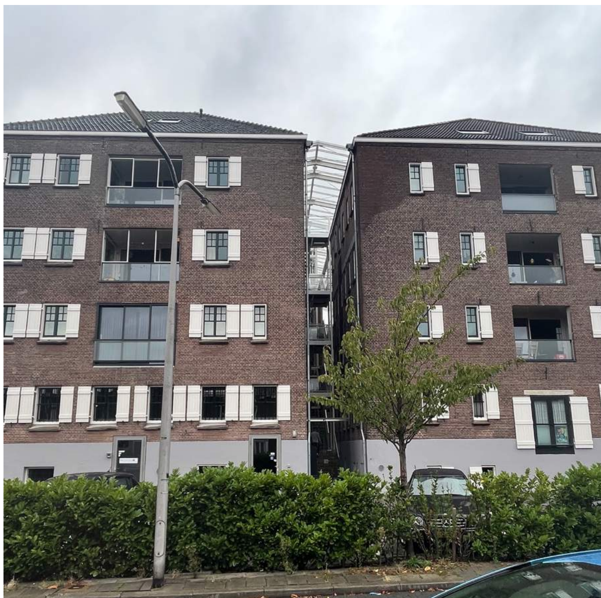
Il.70. Widok na obiekt Cheese Warehouse od ulicy Westerkade
