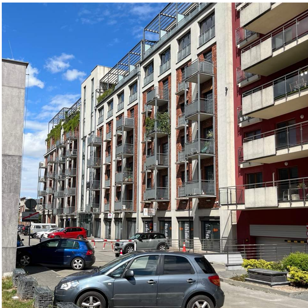
Il.166. Widok na budynek A obiektu Lofty w Młynie od strony parkingu
