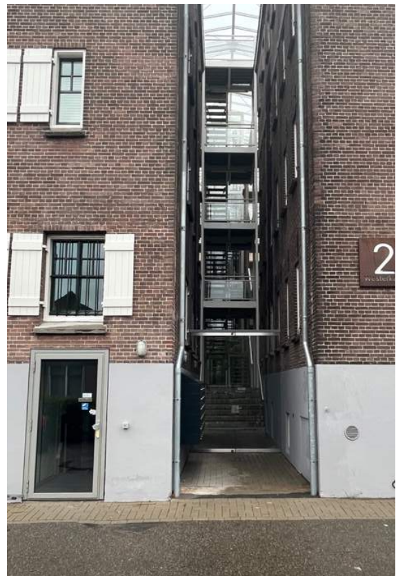
II.79. Fragment elewacji południowo- wschodniej budynku Cheese Warehouse
