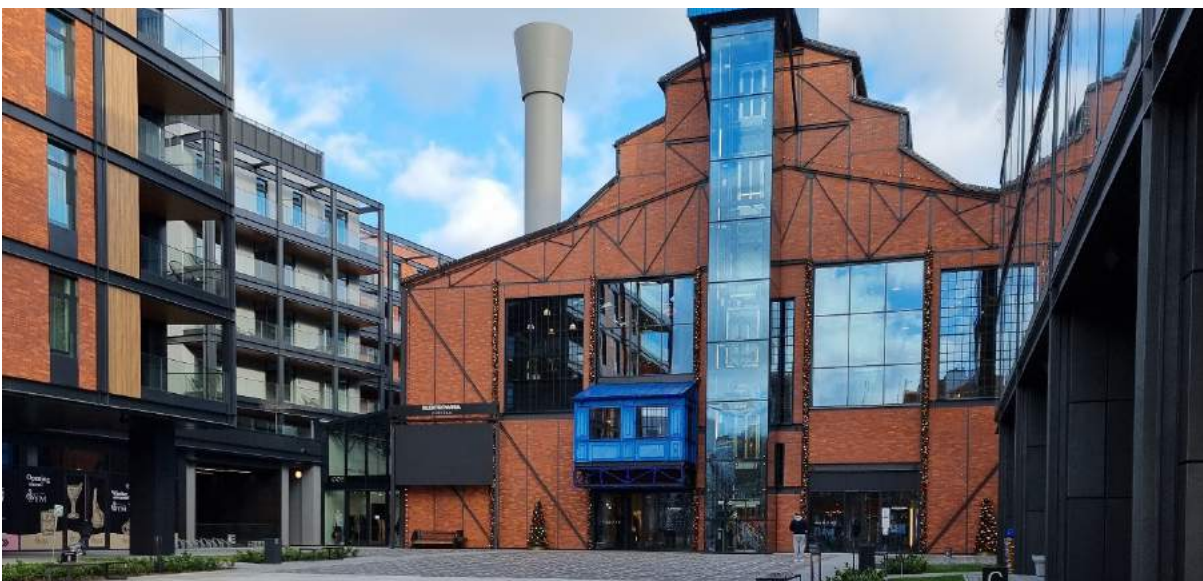
II.9. Zrewitalizowany budynek Elektrowni Powiśle w Warszawie
