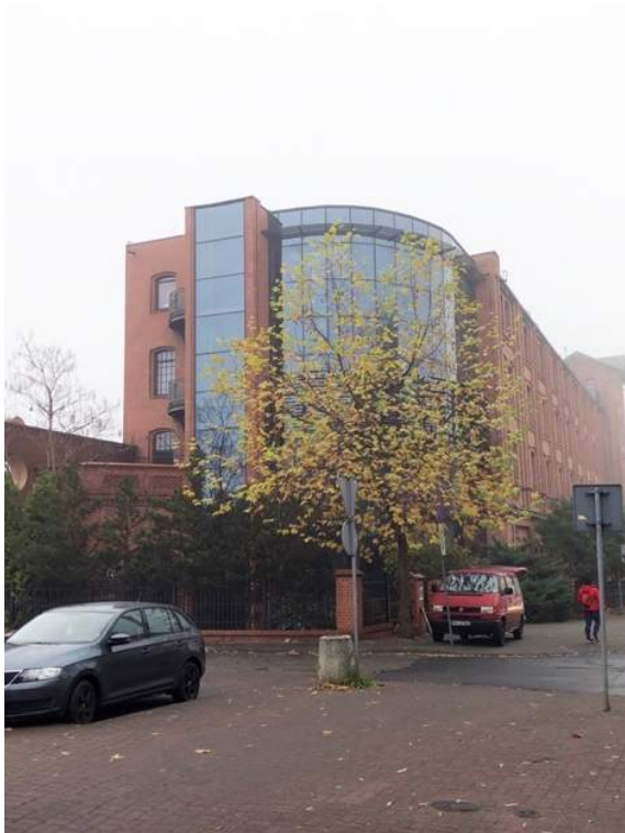
Il.164. Widok na budynek A obiektu Tkalnia 14
