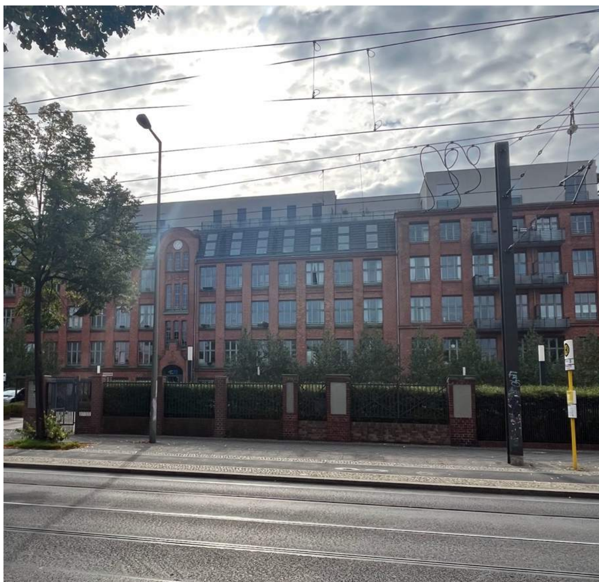
Il.38. Widok na obiekt Zuckerwarenfabrik od strony północno-zachodniej
