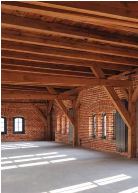
Il.143. Wnętrze budynku Spichlerz po adaptacji. Detal stropu
