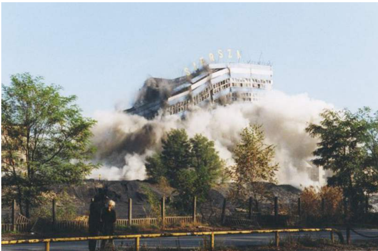
Il.13. Wyburzenie budynków Kopalni Węgla Kamiennego „Siersza” w Trzebini, rok 2000
