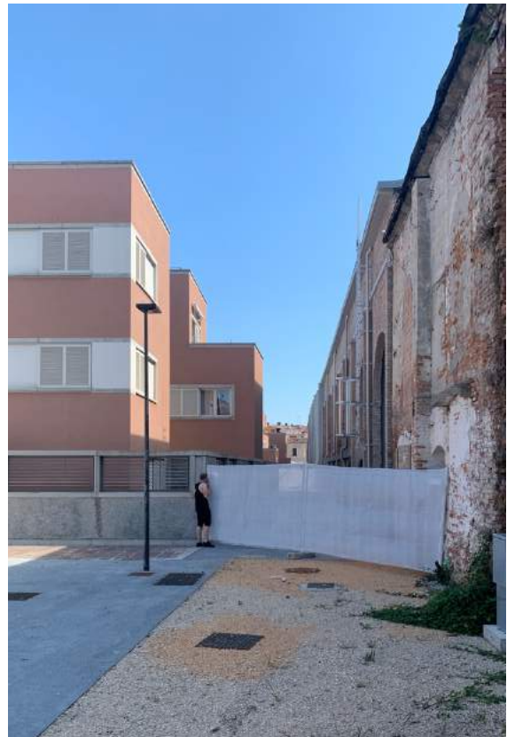
II. 88. Widok na budynek A obiektu Le Conterie od strony południowej
