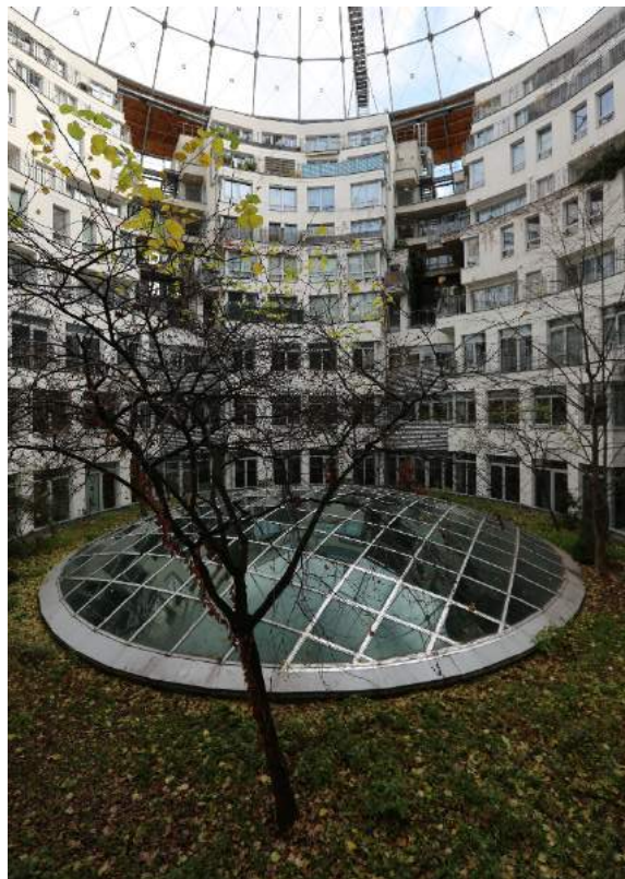
II.68. Elewacja wewnątrz dziedzińca budynku C obiektu Gasometr II.69. Widok na szklany dach budynku C obiektu Gasometr
