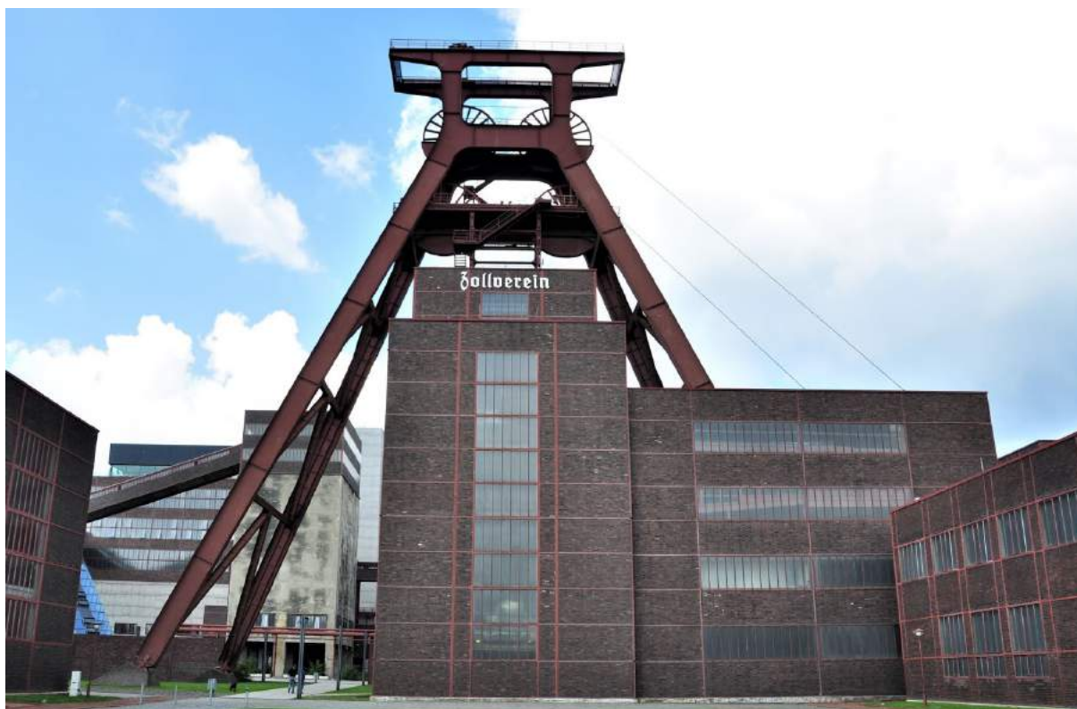
Il.15. Główny budynek ekspozycyjnej w kompleksie przemysłowym kopalni i koksowni Zolleryen w Essen w Niemczech. Obiekt wpisany na listę obiektów dziedzictwa kulturowego i dziedzictwa naturalnego UNESCO w 2001 roku
