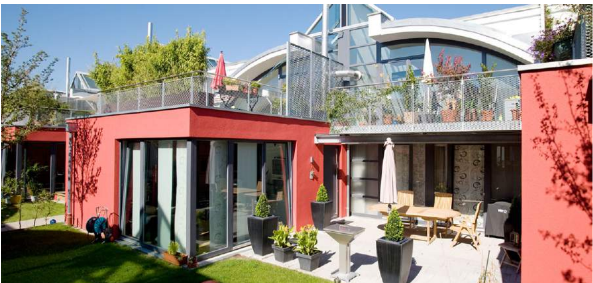
Il.58. Widok bryły budynku Postlofts po adaptacji (elewacja mieszkania typu atrialnego)
