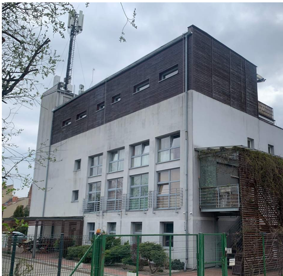
Il.113. Widok na Starą Kotłownię od strony parkingu
