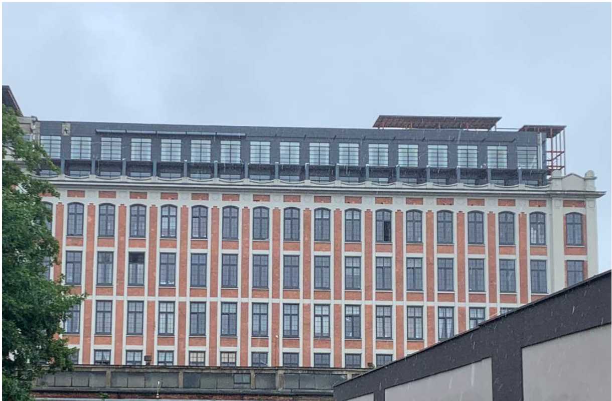
Il.184. Elewacja północna budynku Lofty De Girarda w Żyrardowie
