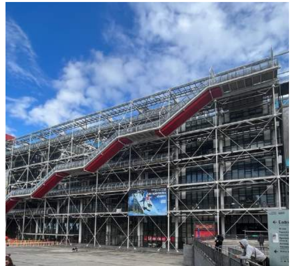
Il.19. Elewacja głównego budynku Centrum Sztuki Nowoczesnej im. Pompidou w Paryżu, we Francji
