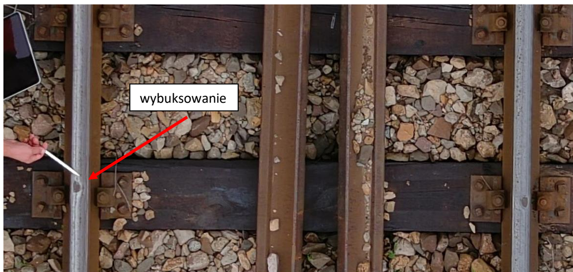
Rysunek 47. Przykład wybuksowania główki szyny w stacji Sosnowiec Jęzor JCA.
