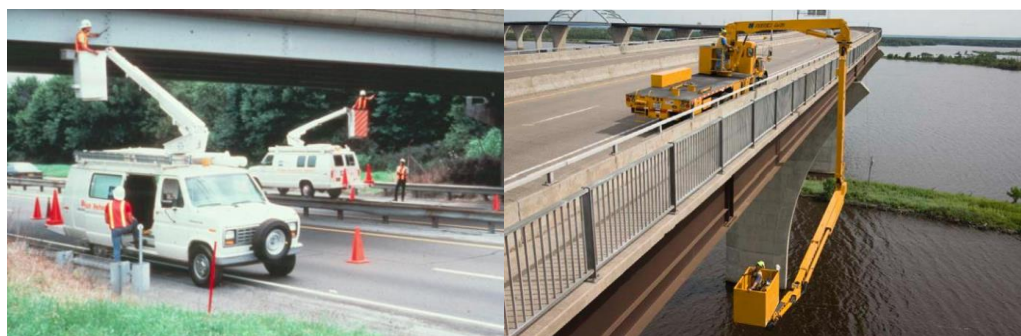
Rysunek 10. Inspekcje mostów powodujące ograniczenia w ruchu drogowym [97].
