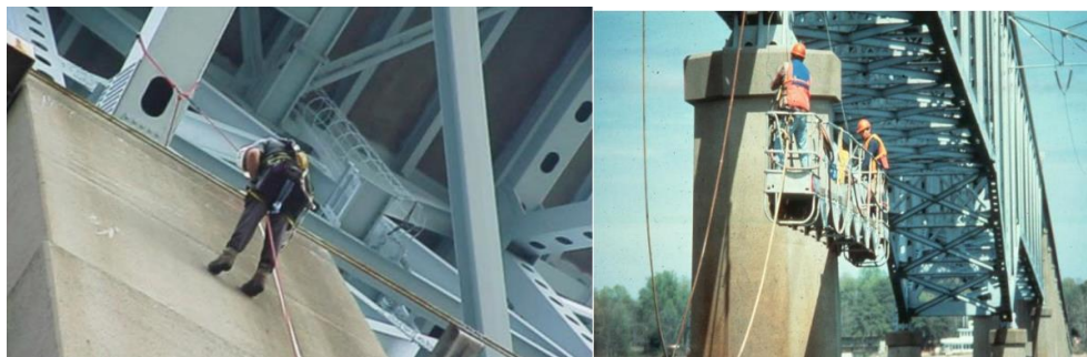
Rysunek 9. Inspekcje mostów z użyciem sprzętu alpinistycznego lub specjalnych platform [97].
