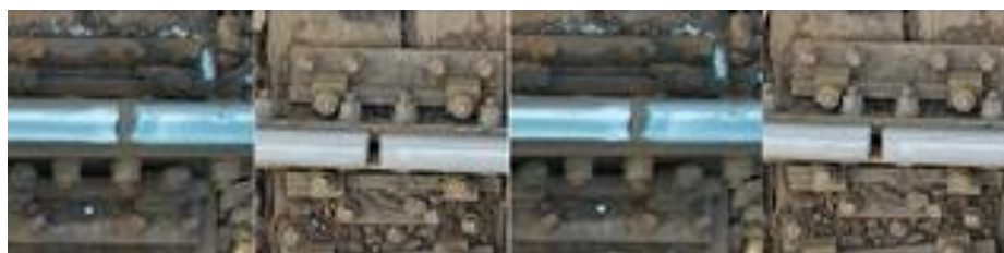
Rysunek 37. Miejsca styków międzyszynowych na podparciu szyn.
