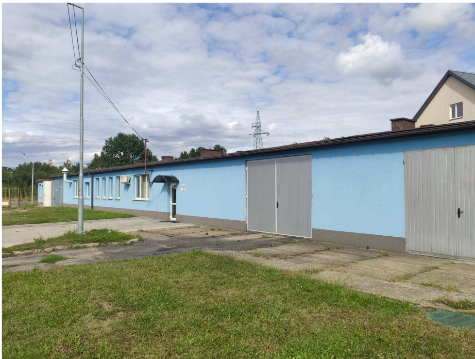
Rysunek 38 – Budynek administracyjno-biurowy
