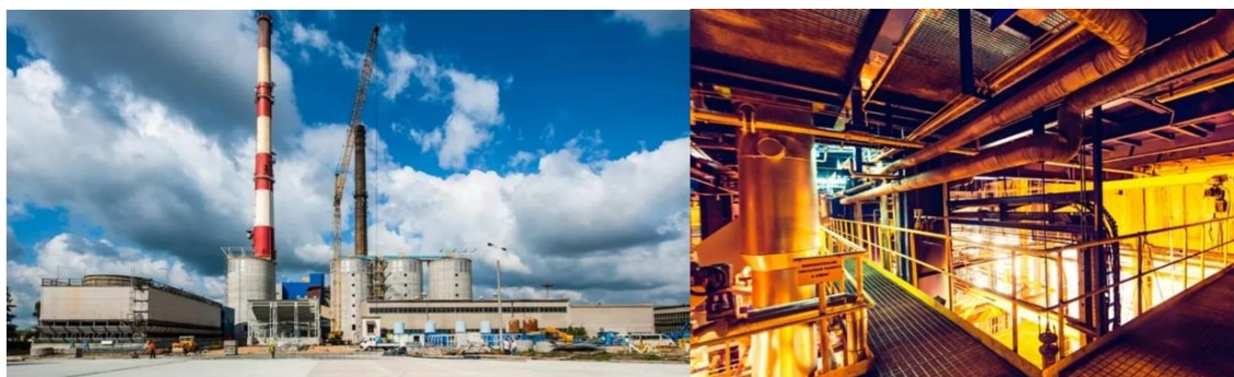
Rys. 7 Widok elektrociepłowni Tychy z zewnątrz oraz hala maszyn [44]
