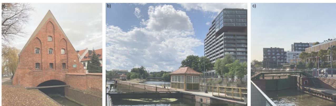
Ryc. 108. Budynki i budowle inżynieryjne wykorzystujące oraz regulujące wodę rzeczną. a) Zabytkowy Mały Młyn znajdujący się na Kanale Raduni w obszarze centralnym Gdańska. Fot. własna, 12.2022r. b) Zabytkowa miejska śluza znajdująca się na wodach Brdy w Bydgoszczy. W widoku po prawej współczesny budynek apartamentowy Nordic Haven Apartments. Fot. własna, 08.2021r. c) Zabytkowa śluza mieszcząca zlokalizowana na wodach Odry, w rejonie Mostu Pomorskiego oraz współczesnej zabudowy apartamentowej wychodzącej z ładu w głąb wody. Fot. własna.09.2020r.
