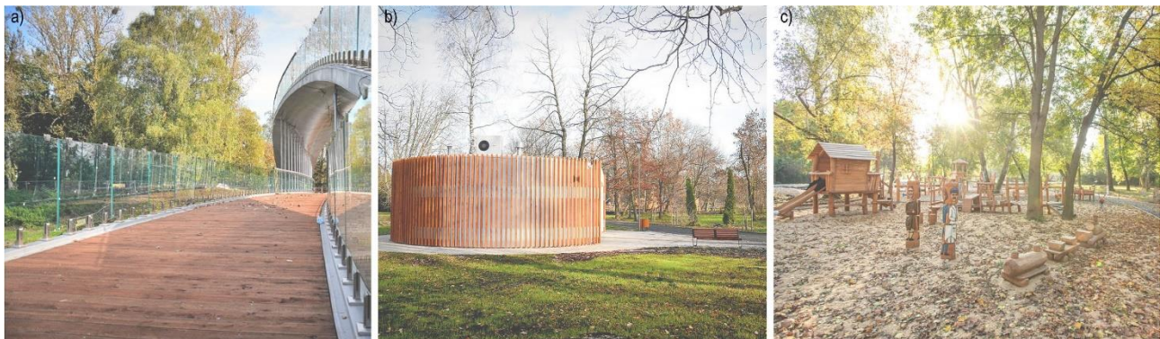
Ryc. 161. Rozwiązania architektoniczno-urbanistyczne Parku Ludowego. a) Nowo zrealizowana kładka pieszo-rowerowa. b) Widok na toaletę publiczną. c) Widok na plac zabaw. Źródło: www.lublin.eu, data dostępu: 07.2023r.
