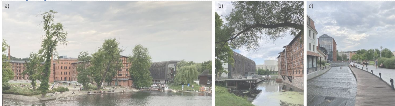
Ryc. 179. Zrewitalizowany obszar Wyspy Młyńskiej, obszar wielofunkcyjny, łączący funkcje centrową, reprezentacyjną, kulturową, rekreacyjną, turystyczną, identyfikacyjną, przyrodniczą. a) Widok na Wyspę Młyńską od strony Opery Nova, w widoku Młyn Rothera oraz hotel Przystań Bydgoszcz. b) Widok na hotel Przystań Bydgoszcz - po lewej, Młyn Rothera - po prawej oraz Operę Nova. c) Widok na historyczne Miedzynadzie. Fot. własna: 08.2021r.
