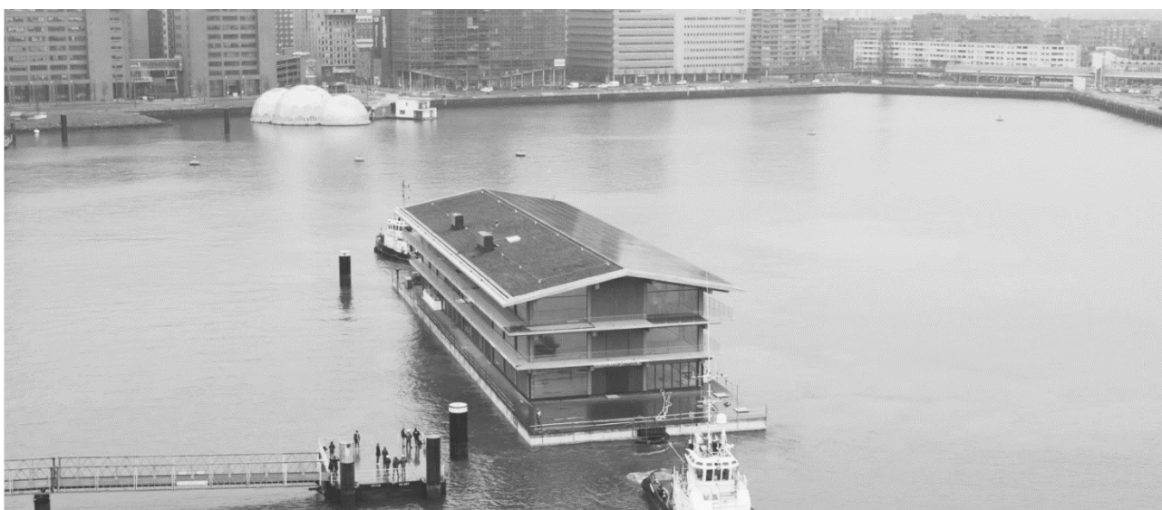
Ryc.59. Rotterdam, port Rijnhaven. W widoku zrównoważony, pływający budynek biurowy „Floating Office” w tle widoczny jeszcze pływający pawilon „Floating Pavilion”. Źródło: www.archelocom.com , data dostępu: 11.2022r.
