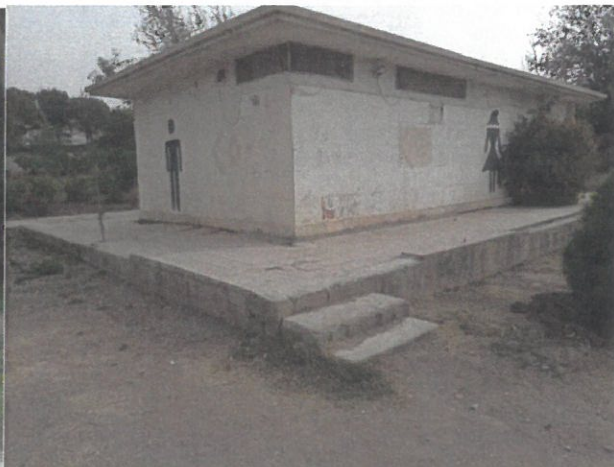
Rysunek 9. Przykład schodów na głównej ścieżce do toalet w Azadi Park, Irak
