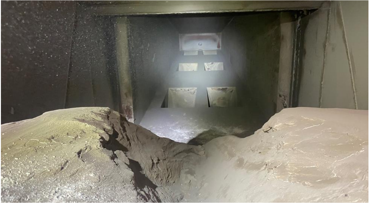
Rysunek 104 Usypany sorbent na dnie kanału spalin, na początku kanału wlotowego do filtra workowego, przy nieodpowiednim ustawieniu lanc dozujących. Brak widocznych pozostałości materiału w końcowym odcinku kanału na wlocie do filtra workowego.
