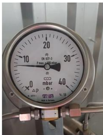
pomiar spadku ciśnienia w pierwszym przedziale zgodnie z kierunkiem przepływ spalin
