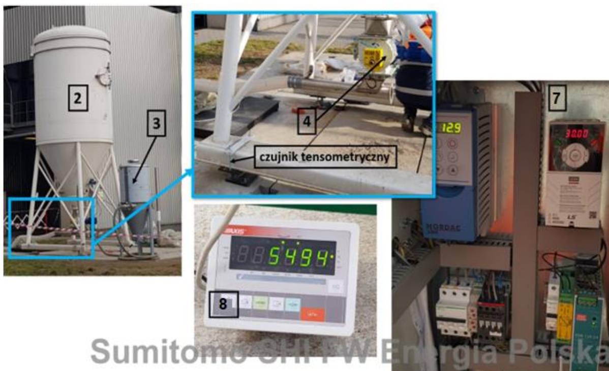
Rysunek 4 Mobilna instalacja tymczasowa na obiekcie A, część 1.
