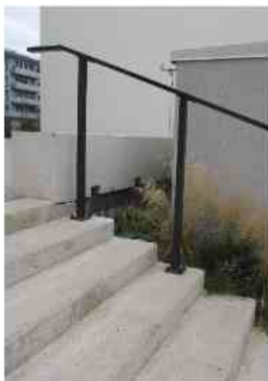
Rycina 47. Przerwy w murze; os. Nowe Żerniki. Źródło archiwum autorki
