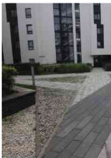
Rycina 50. Nawierzchnia częściowo przepuszczalna, os. Idea. Źródło: archiwum autorki
