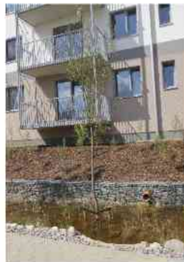
Rycina 43. Rura częściowo umieszczona pod ziemią, os. Zielony Południk. Źródło: archiwum autorki
