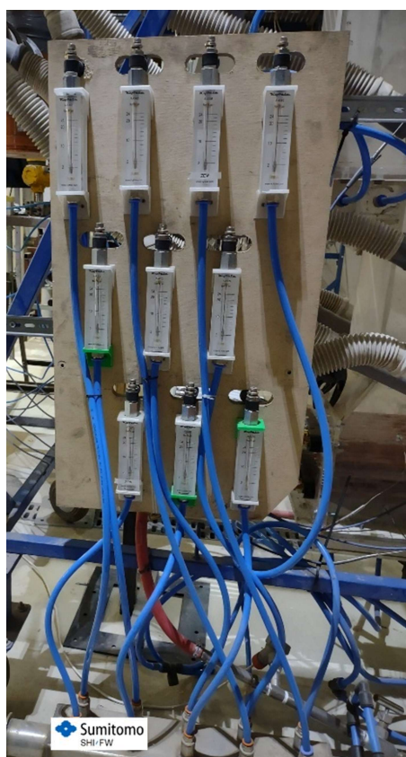
Rys. 38. Rotametry pomiarowe powietrza sprężonego do fluidyzacji materiału warstwy.
