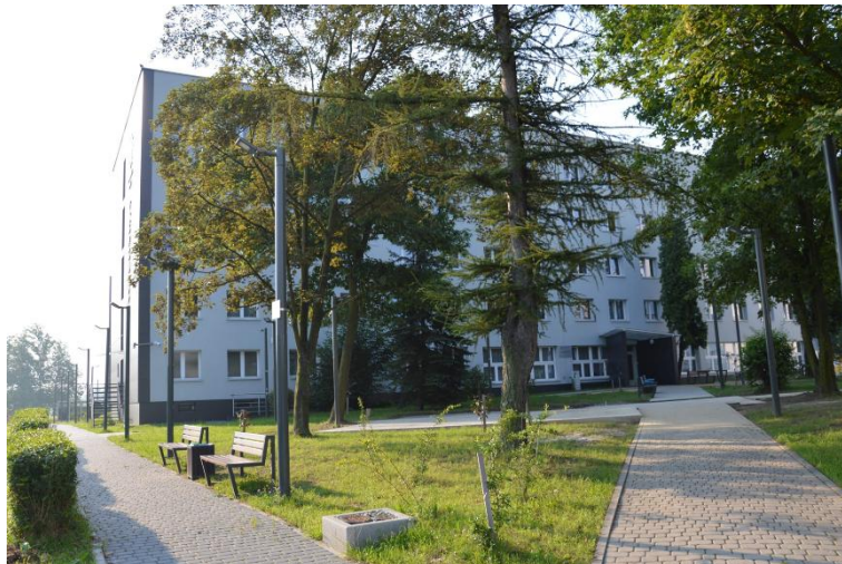
Rys. 31 Widok obiektu ds. Karolinka
