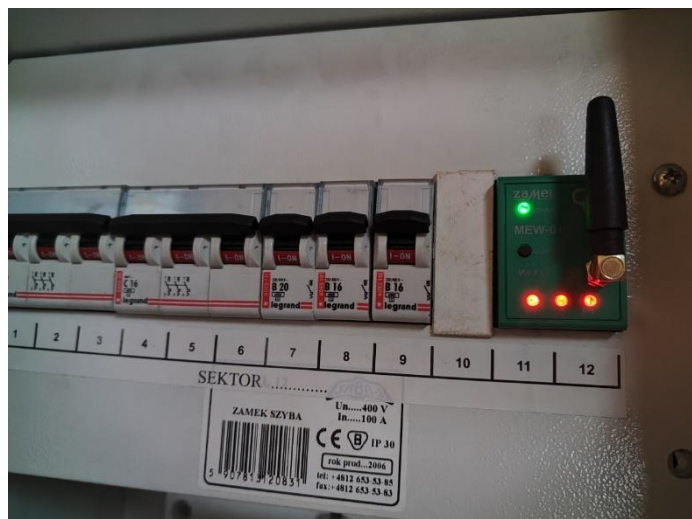
Rys. 26 Widok rozdzielnicę głównej wraz z MEW-01
