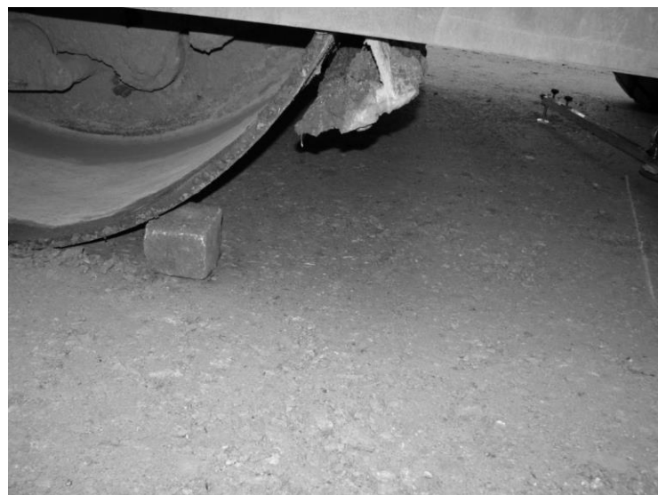
Fot. 5.6 Zabezpieczenie przeciwwagi (walca) przed osunięciem się na warstwie o dużym nachyleniu podłużnym drogi (zdjęcie autora)
