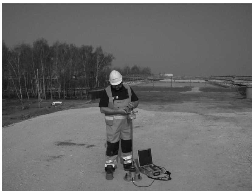
Fot. 5.7 Wykonywanie badania lekką płytą dynamiczną (zdjęcie autora)
