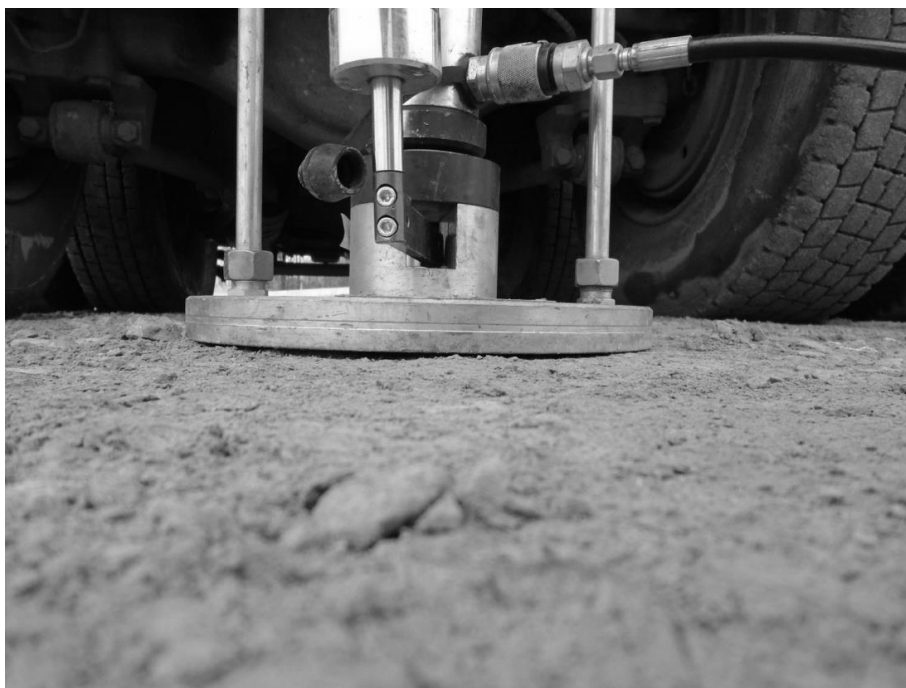
Fot. 5.3 Przykład wadliwego wykonania wyrównania przed wykonaniem badania (zdjęcie własne)
