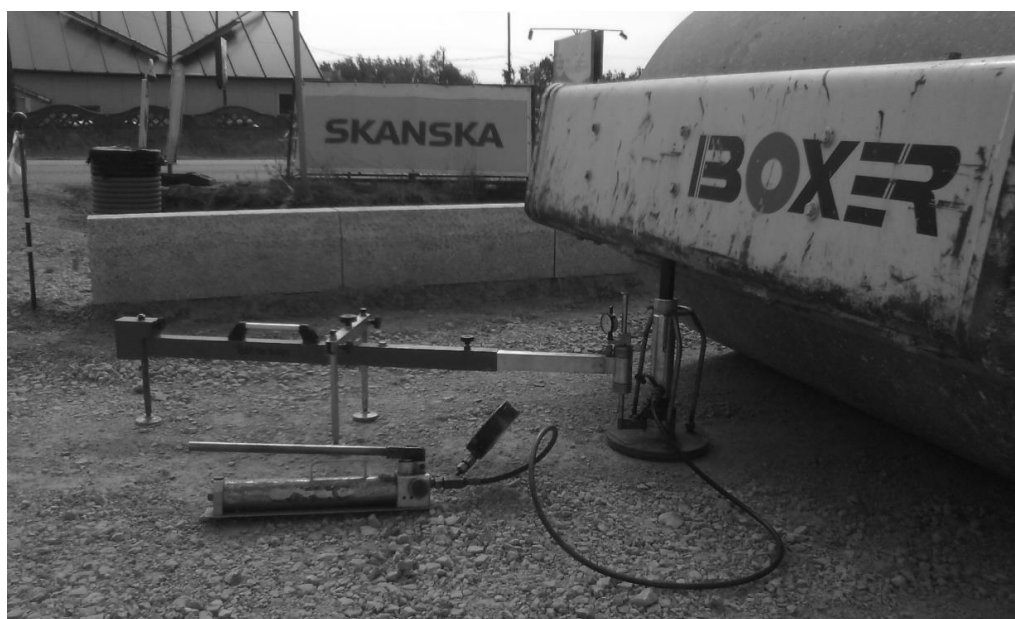
Fot. 6.3. Badanie jednoczynnikową płytą statyczną VSS (zdjęcie własne)
