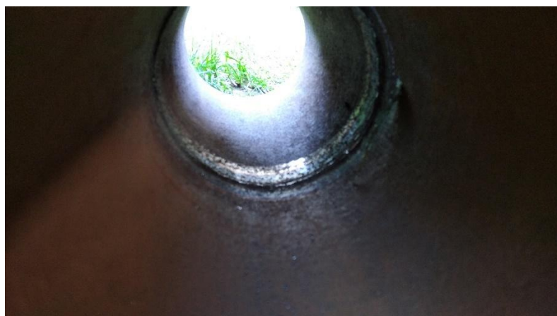
Rys. 75. Widok złącza IV od strony grani spoiny
