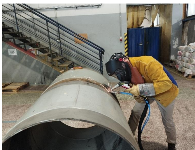
Rys. 169. Widok próbki testowej RT1 podczas spawania
