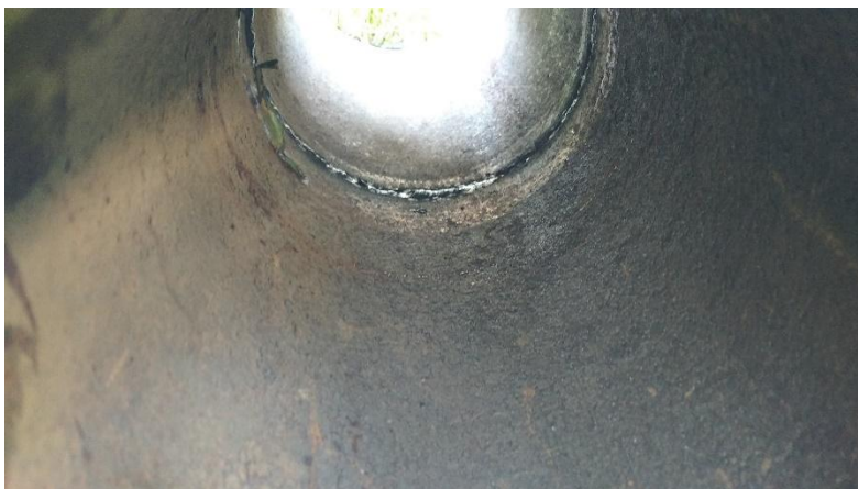
Rys. 63. Widok złącza II od strony grani spoiny
