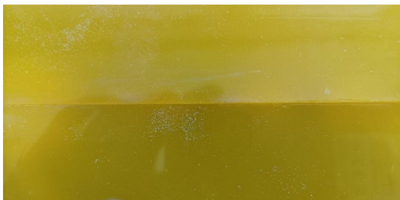
Rys. 119. Widok złącza 7A od strony wykładki kompozytowej (od strony grani)
