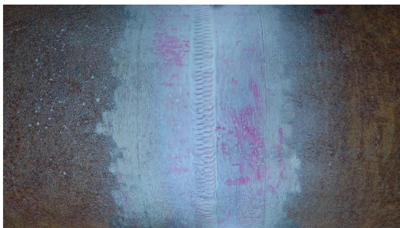
Rys. 56. Widok złącza I od strony lica spoiny po badaniu penetracyjnym
