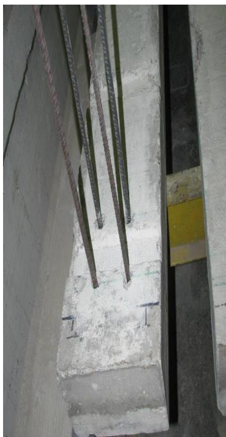
Rys. 7.2.2 Etap I – osadzanie starterów zbrojenia rdzeni w prefabrykowanej belce
