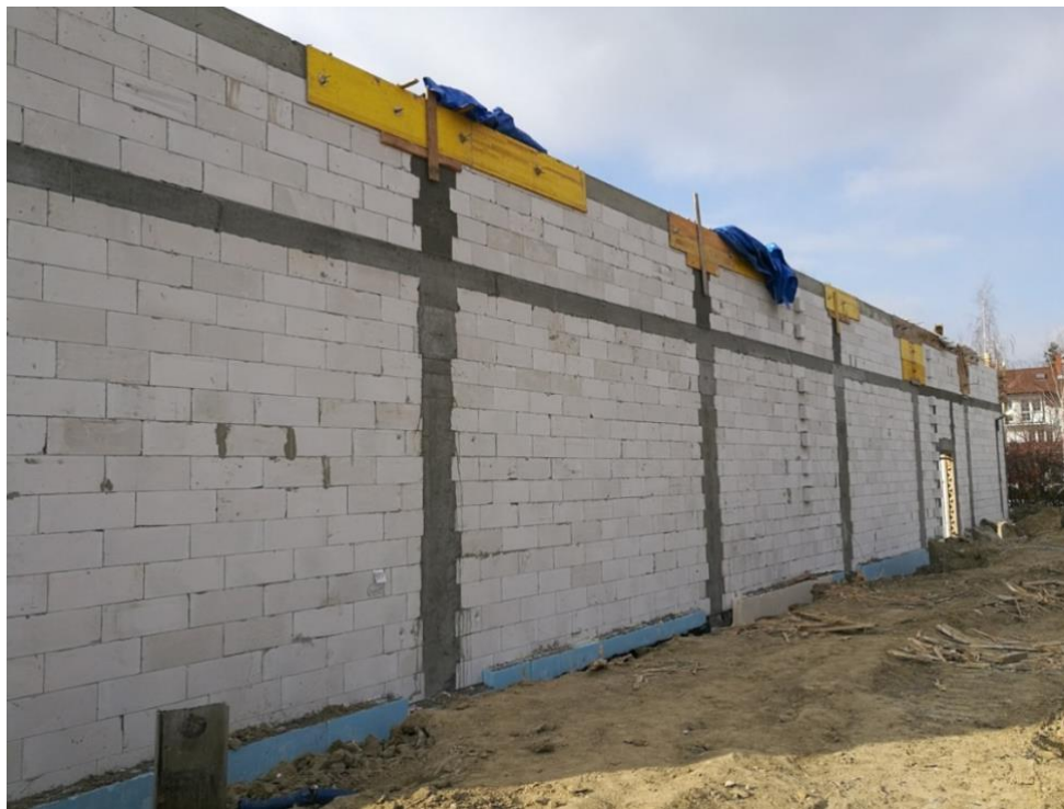
Rys. 4.3.9 Przykład budynku komercyjnego z murami skrępowanymi (fot. Tomasz Rybarczyk)
