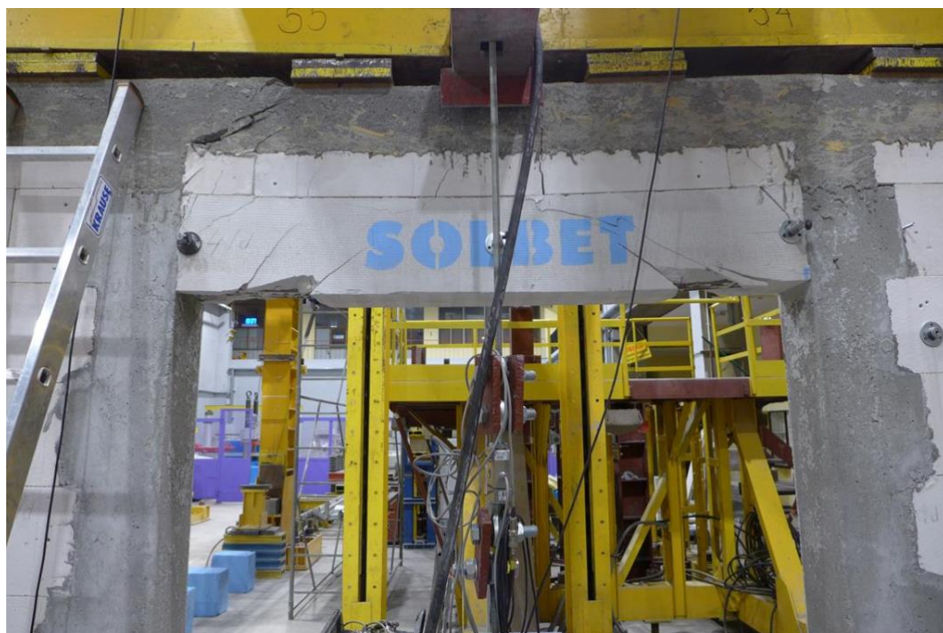
Rys. 7.3.49 Uszkodzenia modeli skrępowanych podwójnie z wypełnionymi spoinami pionowymi: a) M2SO-Z1-1, b) M2SO-Z1-2
