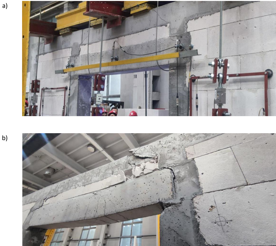
Rys. 7.4.13 Uszkodzenia modeli skrępowanych podwójnie z niewypełnionymi spoinami pionowymi: a) i b) M2SO-SC
