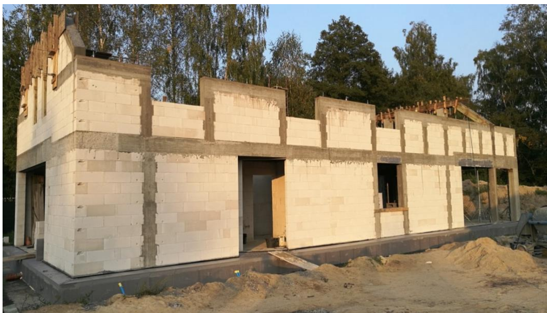
Rys. 4.5.10 Przykład murów skrępowanych w budynku mieszkalnym jednorodzinny (fot. Tomasz Rybarczyk)
