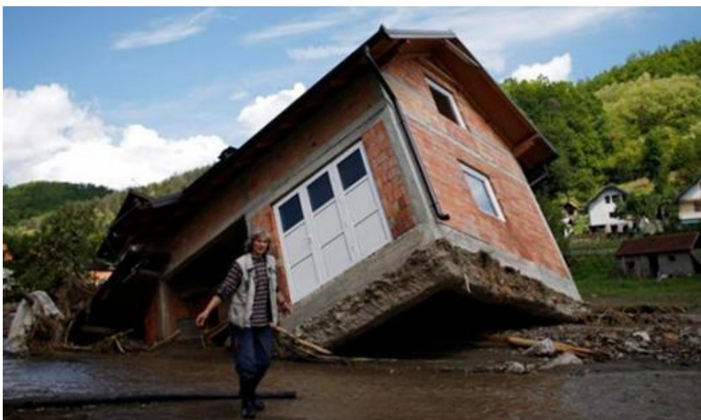
Rys. 4.3.1 Przykład odporności konstrukcji budynku ze ścianami skrępowanymi na obciążenia wyjątkowe (budynek po powodzi w Bośni 2014)[W1]
