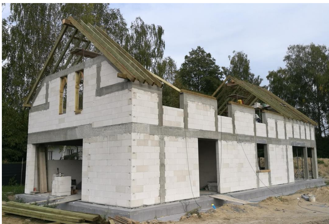
Rys. 4.3.6 Przykład budynku mieszkalnego jednorodzinnego ze skrępowaniem murów z betonu komórkowego (fot. Tomasz Rybarczyk)
