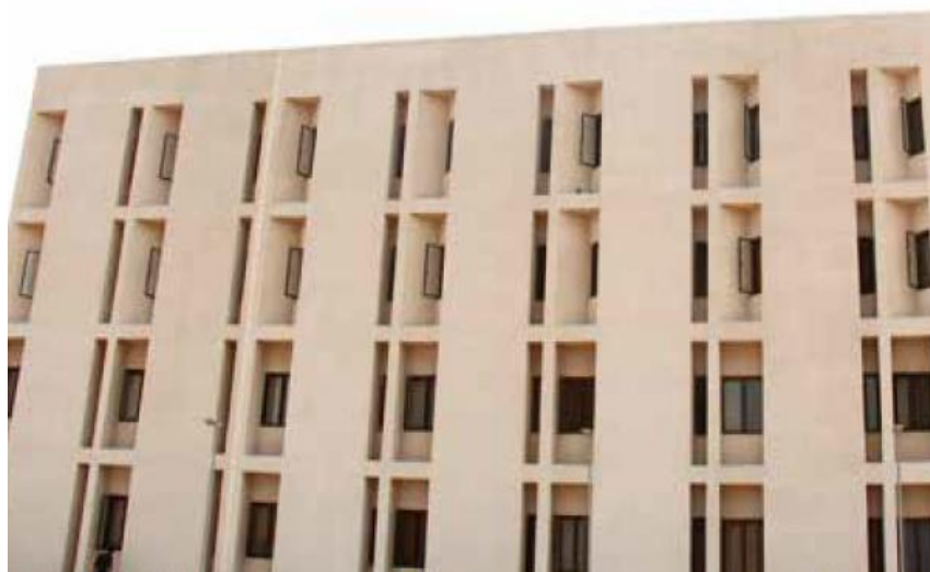
Rys. 4.3.12 Przykład elewacji budynku ze ścianami skrępowanymi Campus on the Sabarmati IIT Gandhinagar – Indie [94]
