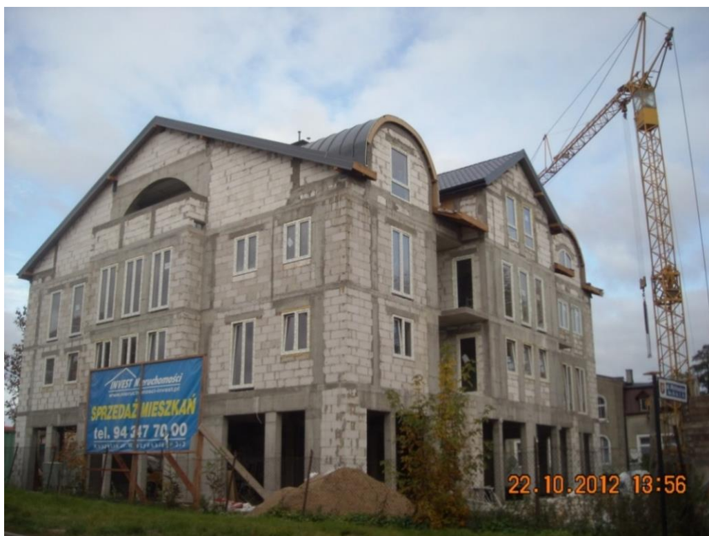
Rys. 4.3.8 Przykład budynku mieszkalnego wielorodzinnego ze skrępowaniem murów z betonu komórkowego (fot. Tomasz Rybarczyk)
