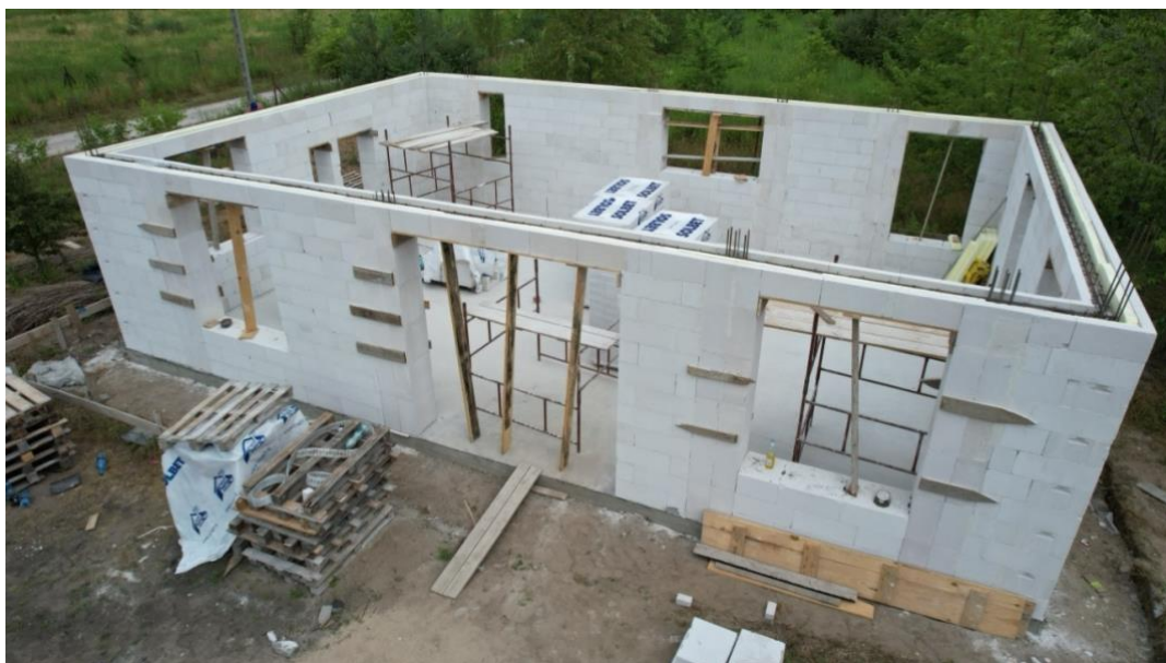
Rys. 4.3.5 Przykład budynku mieszkalnego jednorodzinnego ze skrępowaniem ścian jednowarstwowych z betonu komórkowego (krępujące elementy żelbetowe trzpienie i wieńce są wykonywane w kształtkach U) (fot. Tomasz Rybarczyk)
