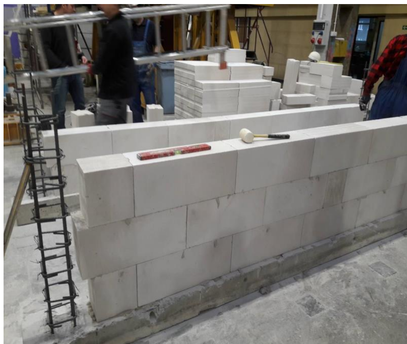
Rys. 7.2.3 Etap II – murowanie ścian
