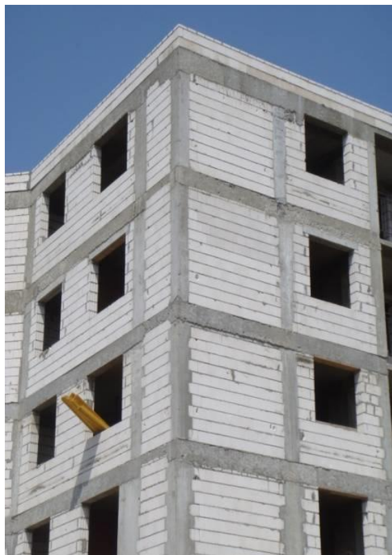
Rys. 4.5.9 Przykłady murów skrępowanych w budynkach wielokondygnacyjnych (fot. Łukasz Drobiec) [80]
