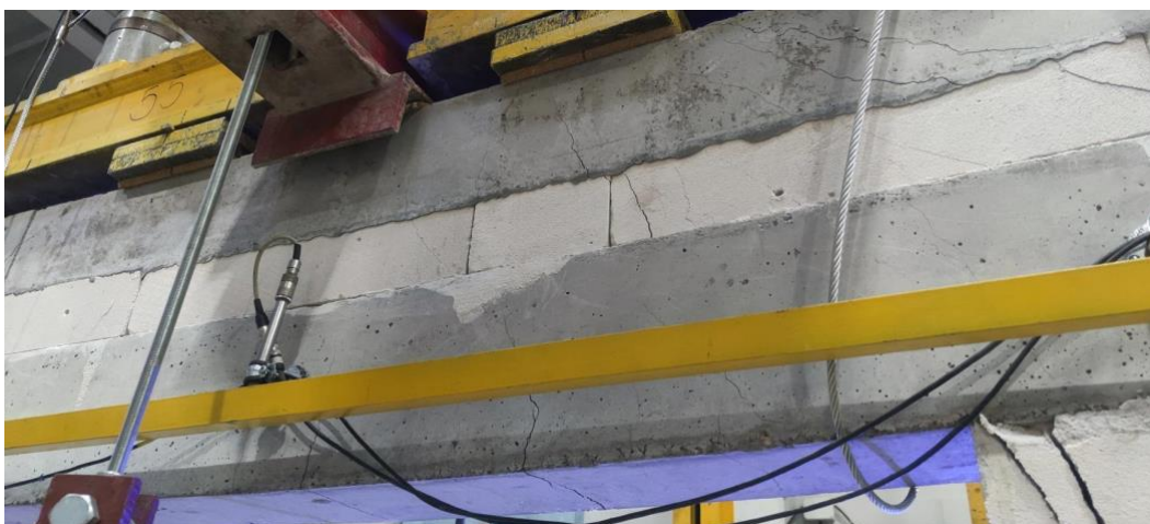
Rys. 7.4.12 Uszkodzenia modeli skrępowanych obwodowo z niewypełnionymi spoinami pionowymi: a) i b) MSO-SC
