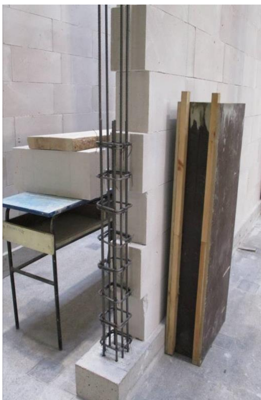
Rys. 7.2.4 Etap III – Zbrojenie rdzeni, przygotowanie szalunku do połowy wysokości rdzenia
