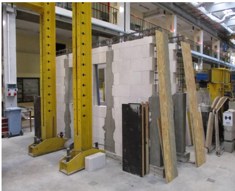
Rys. 7.3.4 Etap III – Częściowo zabetonowane rdzenie
