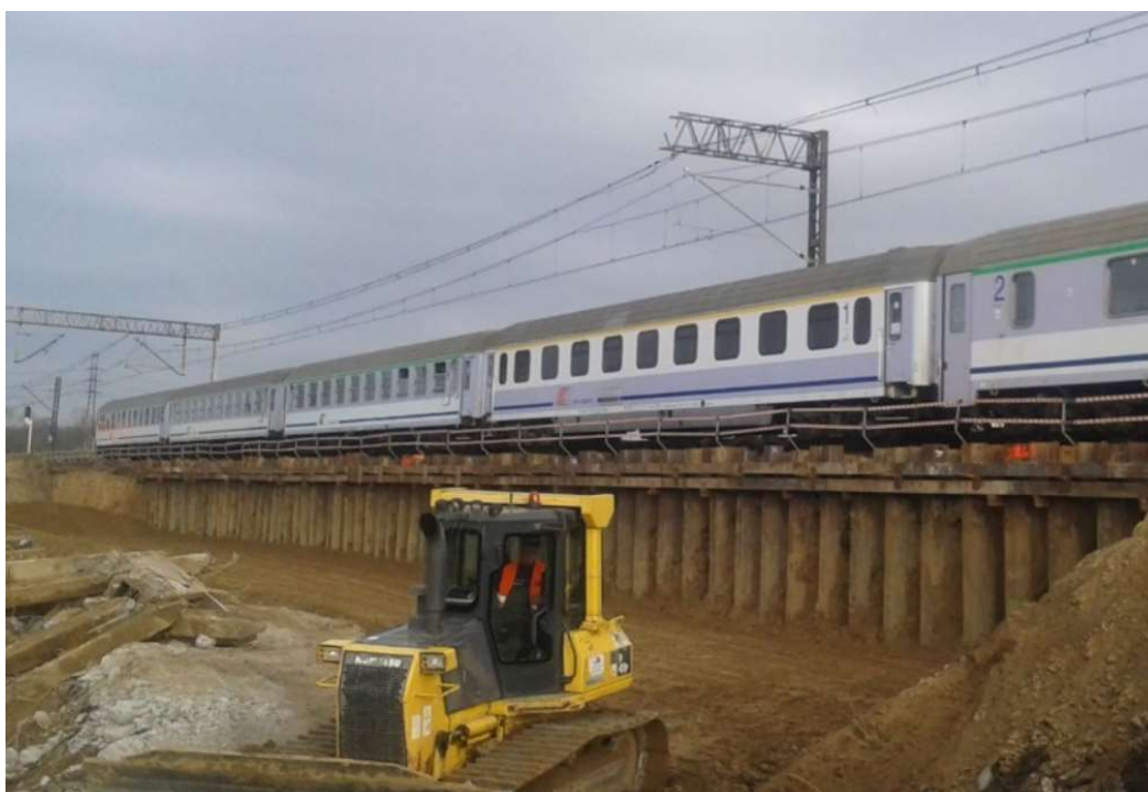
Rys.1.5. Ścianka szczelna usztywniona ściąгами stalowymi - budowa łącznicy kolejowej Kraków Zabłocie – Kraków Krzemionki (www.chrobok.com.pl)
