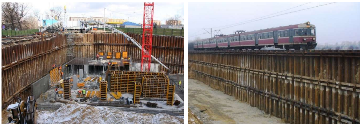
Rys. 1.11. Tymczasowe zabezpieczenie wykopu ścianką szczelną kotwiona: w dwóch poziomach – dla wykonania 3-kondygnacyjnego garażu podziemnego, w trzech poziomach - dla wykonania wiaduktu kolejowego ( www.chrobok.com.pl )
