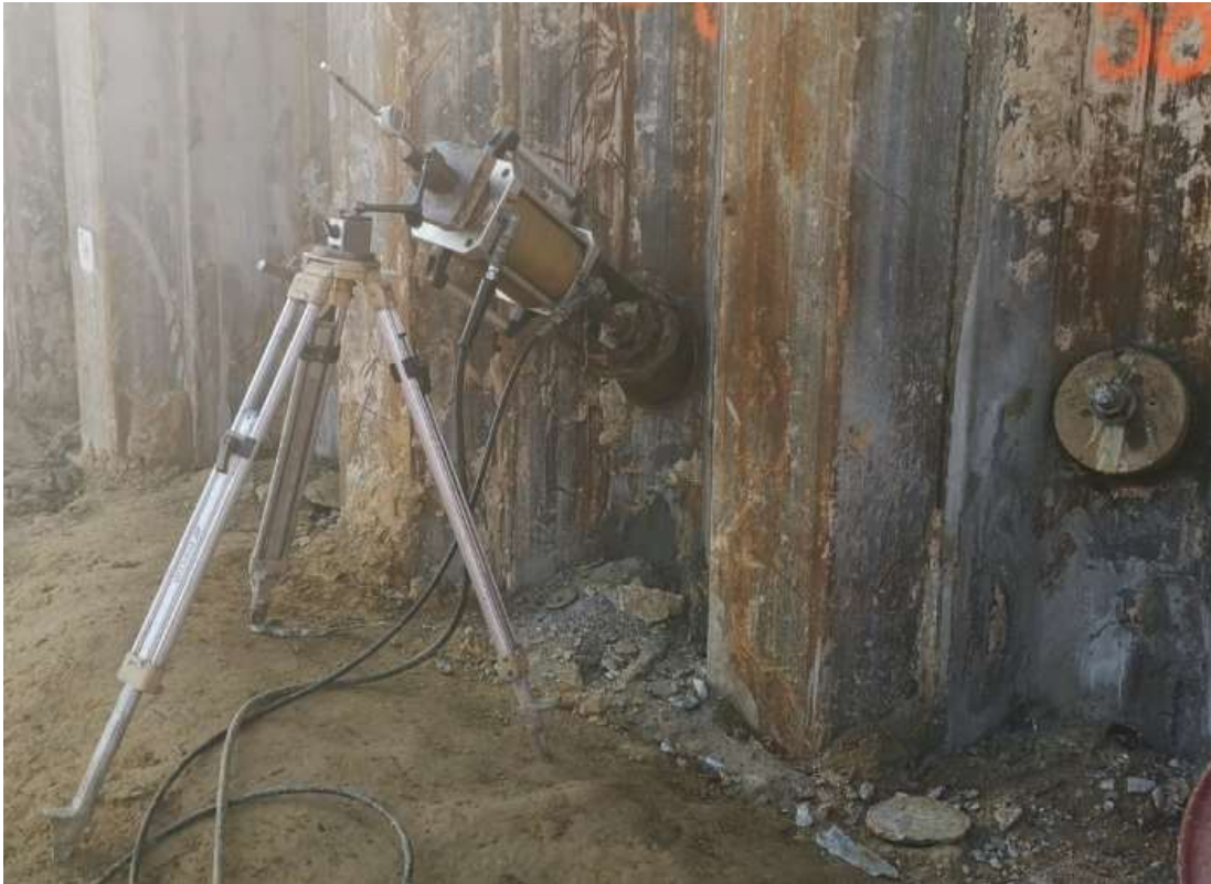
Rys. 1.10. Badanie odbiorcze nośności kotwy gruntowej na ścianie szczelnej (metris.com.pl)
