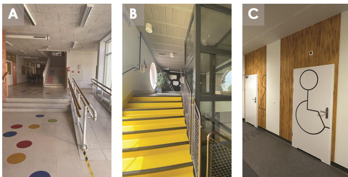
Rys. 60 a, b, c – dostępność budynków szkół, w zakresie rozwiązań sprzyjających poruszaniu się osób o ograniczonej zdolności ruchowej i sensorycznej (SZKOŁA 01, 05, 07). [opracowanie: W. Skowronek, fotografie wykonane przez autorkę]
