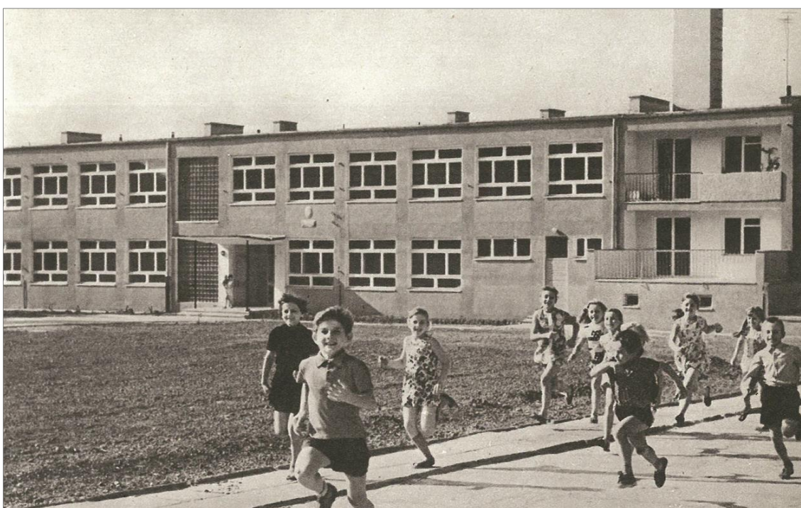
Rys. 12 – przykład zbiorczej szkoły gminnej w Kopernikach według projektu typowego. [źródło: Dobek J. [red.]: Architektura i budownictwo szkolne PRL, 1976]
