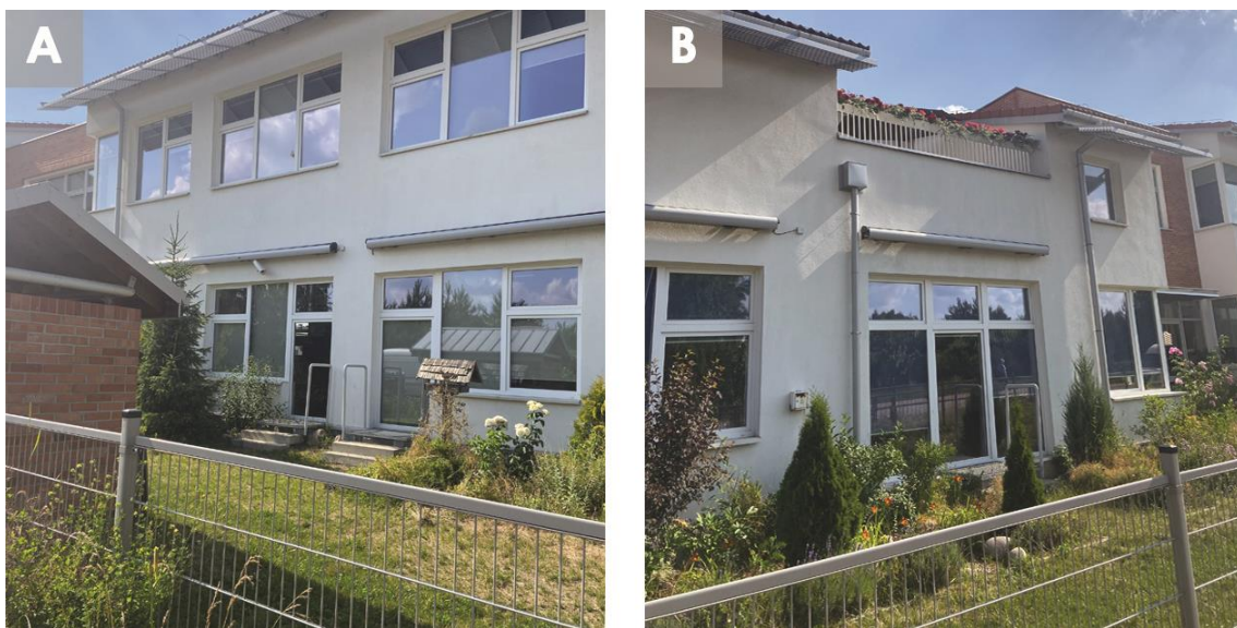
Rys. 48 a, b – rozwiązania ogródków klasowych przy salach lekcyjnych w poziomie parteru na terenie szkoły (SZKOŁA 01). [opracowanie: W. Skowronek, fotografie wykonane przez autorkę]
