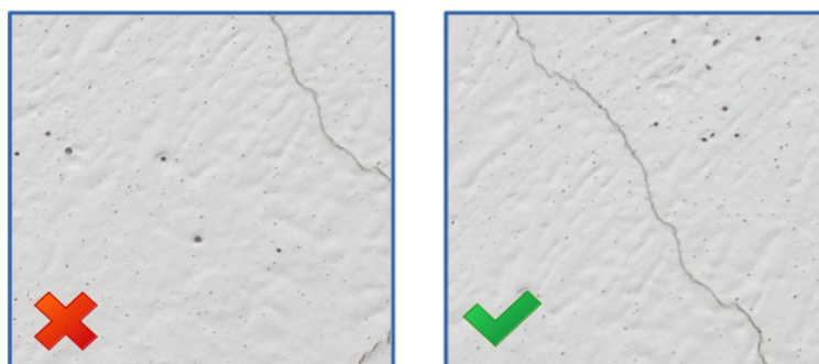
Rys. 27: Nieprawidłowe (lewa) i prawidłowe (prawa) położenie obiektu na obrazie
