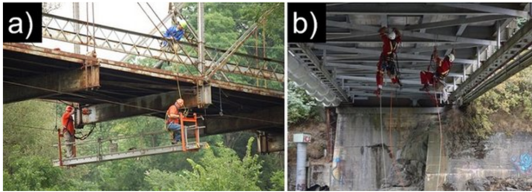
Rys. 1: Warunki pracy inspektora mostowego. Źródła: a) Harcon Corporation, b) Working AT Height [243]
