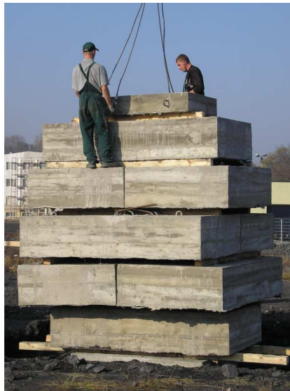
Rys. 5.24. Stos płyt obciążających w ostatnim etapie obciążenia, próbne obciążenia w Piekarach Śląskich.
