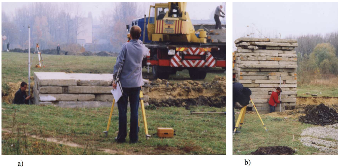
Rys. 5.15. Próbné obciążenie w Chorzowie — pomiar osiadań stosu obciążającego.
