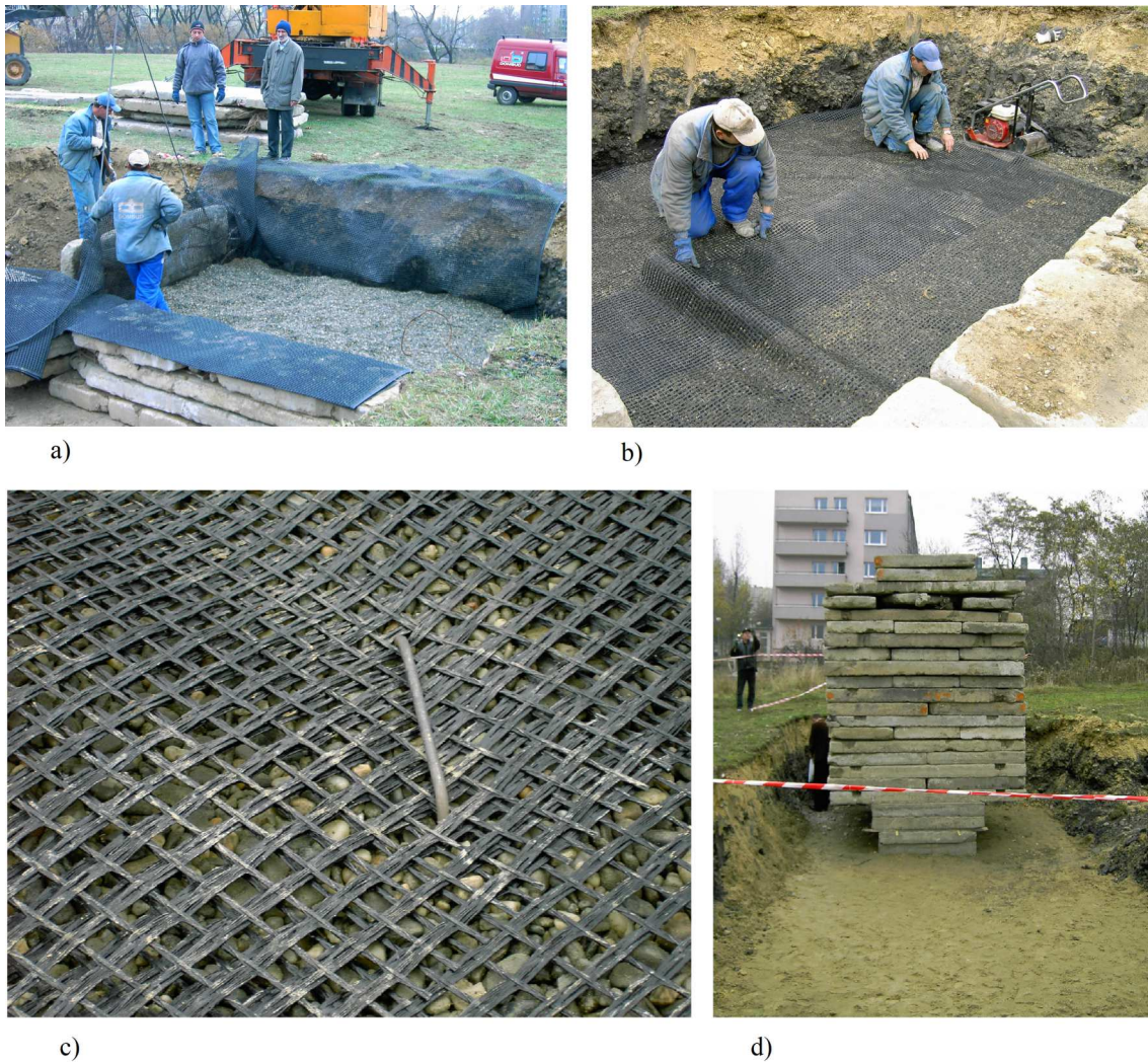
Rys. 5.14. Formowanie materaca na miejscu próbnych obciążeń w Chorzowie: a) — widok ogólny na stanowisko próbnego obciążenia, widoczny stos utrzymujący stateczność ściany bocznej i wypełnienie geomateraca; b) — naciąganie górnej powierzchni geosiatki z zamknięciem na zakład; c) — szpilkowanie geosiatki po jej naciągnięciu; d) — widok na ustawiony stos obciążający (badanie bez wzmocnienia podłoża).
