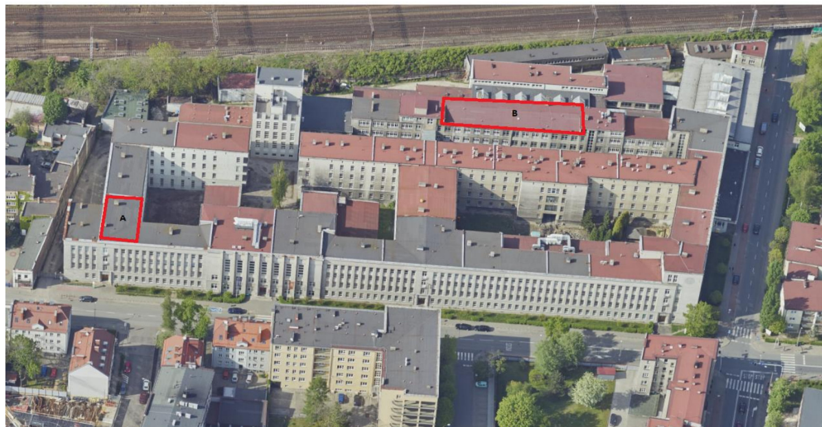
Rys. 1. Części dachów budynków A i B przewidziane pod zabudowę instalacjami PV
