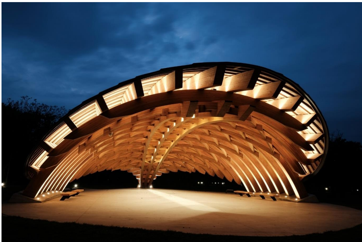
C) Konstrukcja drewniana z drewna klejonego.
